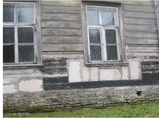
Arbavere mõisa puitkonstruktsiooni proteesimine väikeplokkidega
