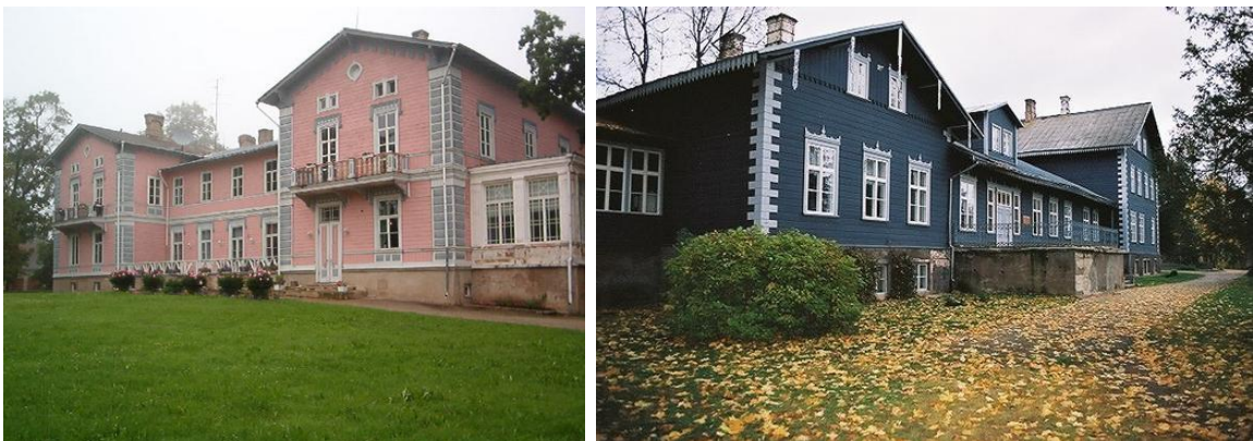
Kohala Lääne-Virumaal ja Pärsti Viljandimaal on tüüpilised näited neorenessansslike võtete rakendamise puitmõisate arhitektuuris.
