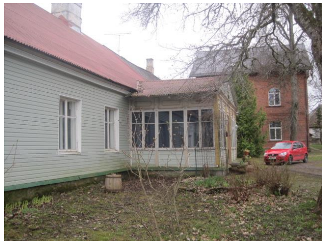
Väljastpoolt soojustamise tulemusena tekivad puithoonel võõristust tekitavad aknapõsed Loodi mõisas.
