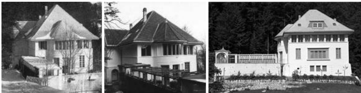
48. C.-E. Jeanneret. La Maison Blanche, 1912. Algusaastatel, pärast 1940ndaid, pärast 2004. aasta restaureerimist. Eterniit on asendatud asbestivaba kiudtsementplaadiga.
