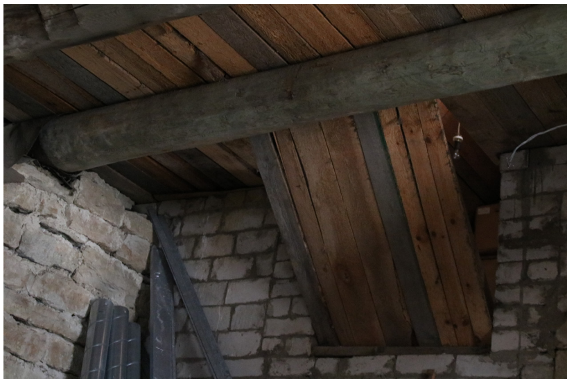
80. Puitkonstruktsioon; teise korruse trepi toed
