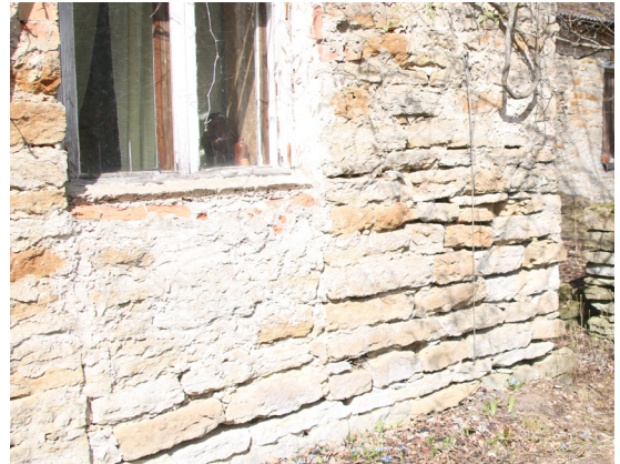
70. Vaade peahoone ava kinniladumisele
