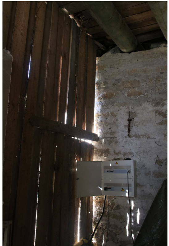
74. Vaade suures hoiuruumis nurka
