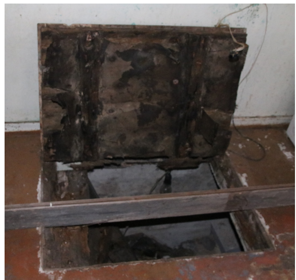
14. Luuk köögipõrandas, viib keldrisse
