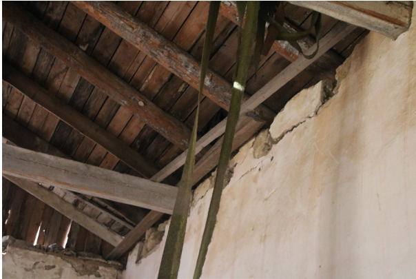
87. Seina ja puitkonstruktsiooni kohtumine
