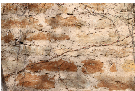
63. Kollaka tooniga kivi ja mört
