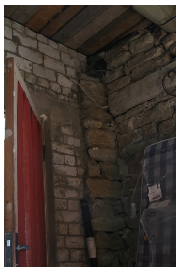
82. Paekivi ja tellismüüri kohtumine
