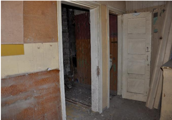
Foto 57. Ruumide 17 ja 18 vaheline vahesein on lammutatud
