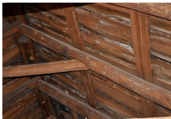
Foto 13. Katusekonstruktsioon
