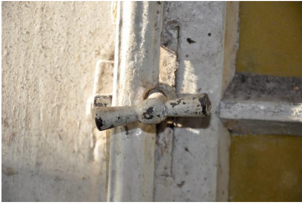
Foto 61. Aknakremon II korruse saali aknal
