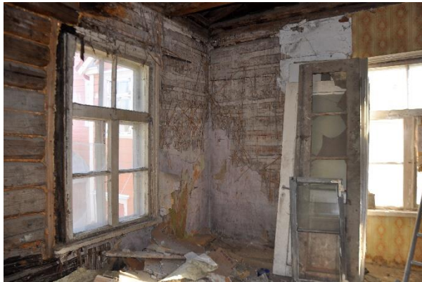
Foto 59. Ruum 19, mille palkseinad on kõige halvemas olukorras
