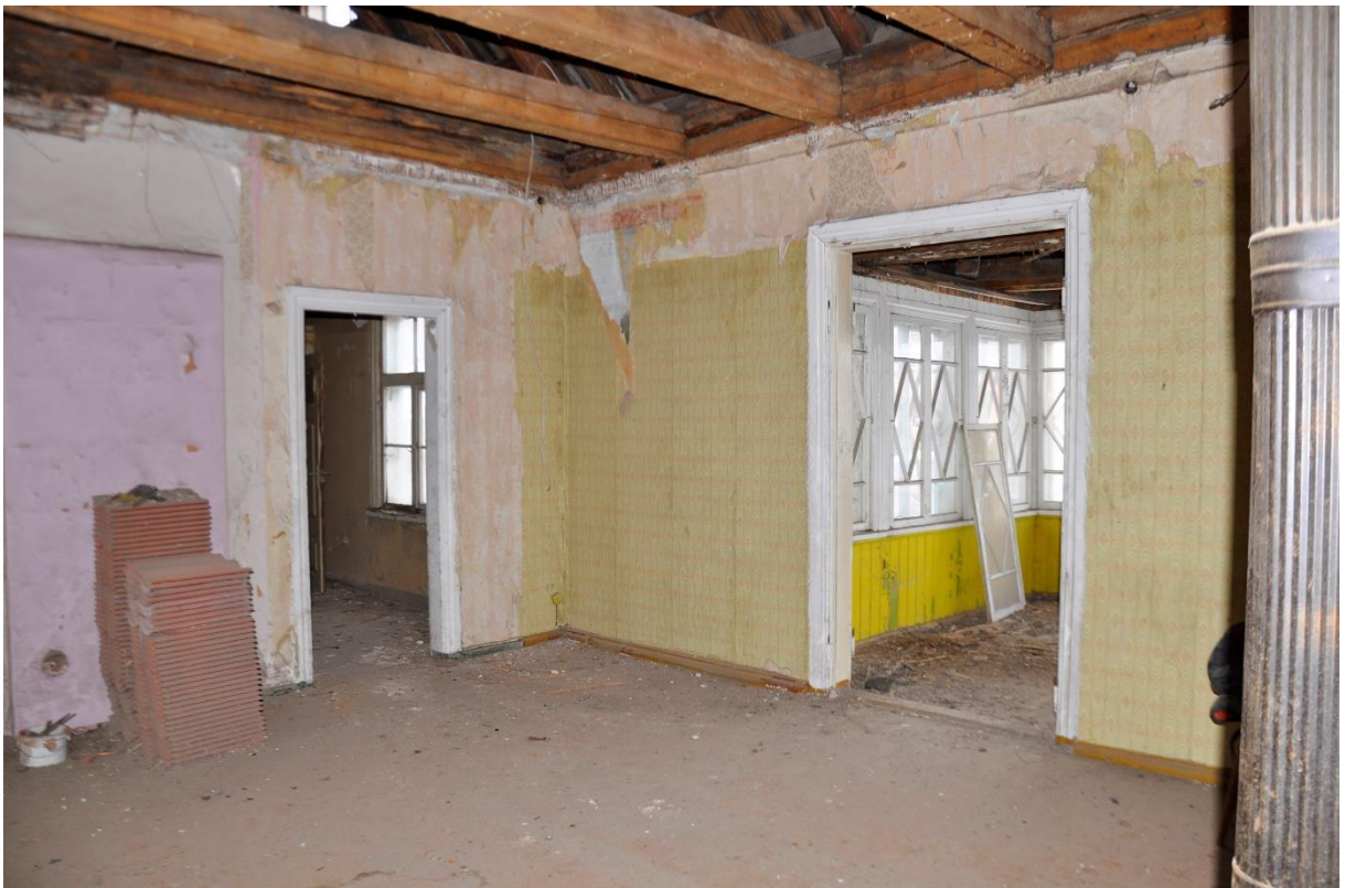
Foto 53. II korruse saal, ruum nr 13, paremal maalingutega sein, eelmiste omanike poolt eemaldatud lagi
