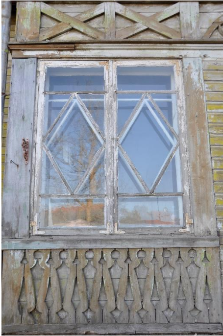
Foto 26. Avatav veranda aken põhjaküljes (ava nr 8.4)
