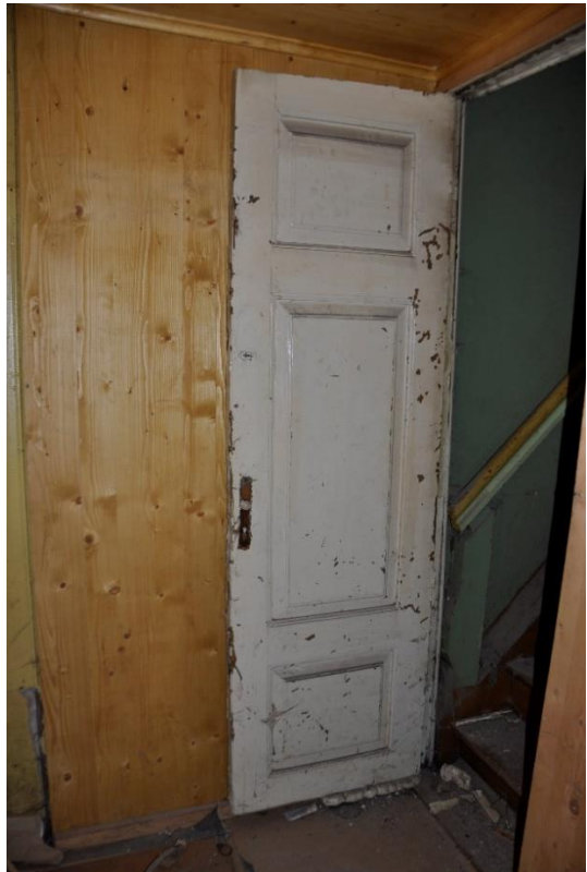
Foto 20. Evakuatsioonitrepi uks (ava nr 2.3)
