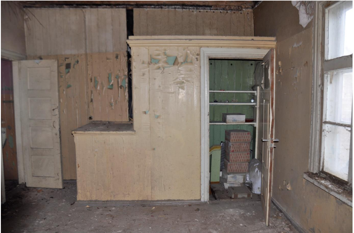
Foto 54. II korruse köök, ruum nr 16, keskel evakuatsioonitrepikoda
