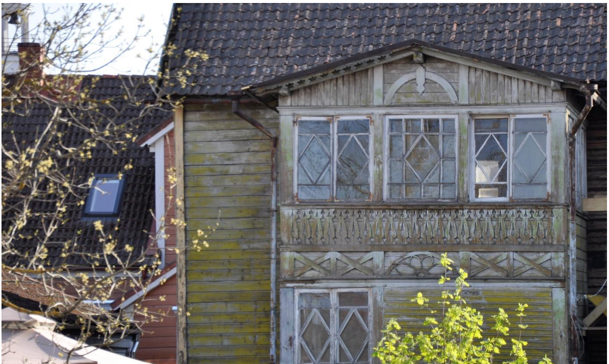
Foto 11. Hästi säilinud veranda puitehisdetailid
