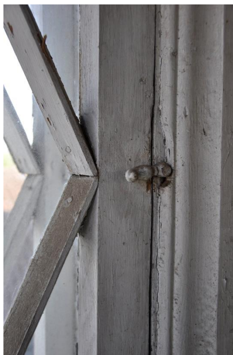
Foto 63. II korruse veranda aknaliistud on kinnitatud naeltega
