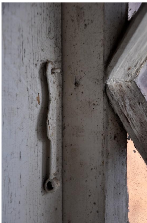
Foto 62. II korruse veranda aknahaagid
