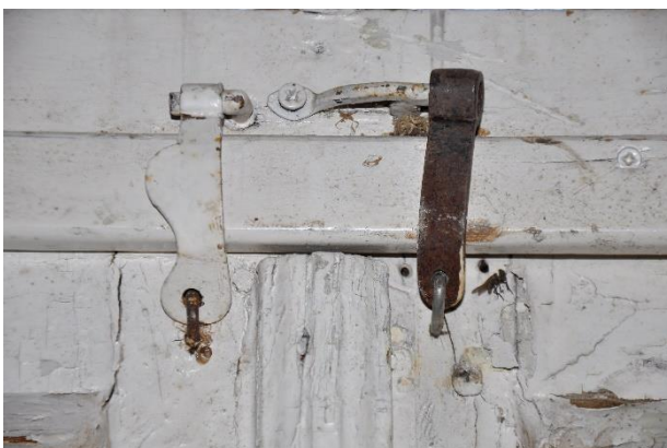
Foto 64. II korruse köögi siseakna sulgurid
