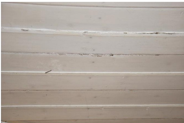
Foto 32. I korruse elutoa poola laudisega kaetud lagi Foto 33. Soemüüri truubiluuk ruumis nr 19
