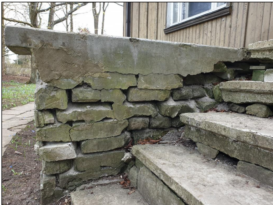
9. Lagunenud ja taastamist vajav kirdefassaadi trepp. 2019 Aivo Pedak
