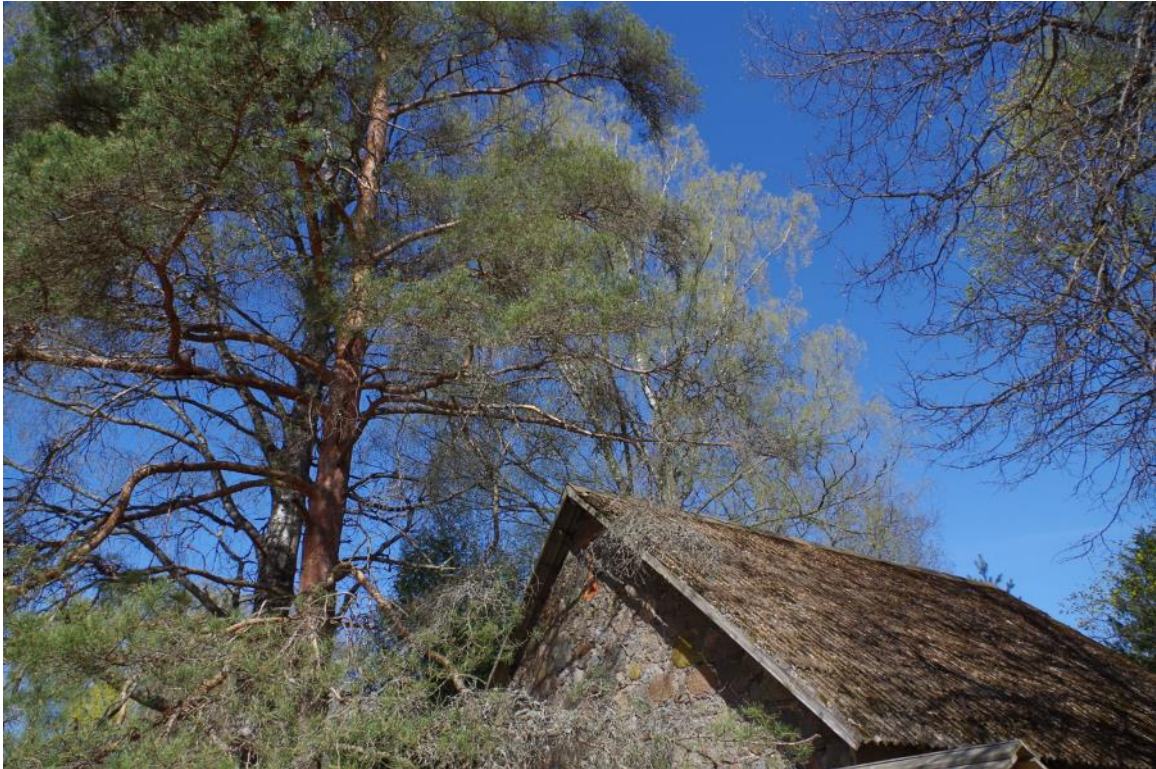
22. Kabeli lähedal kasvavad suured puud (kased, männid), mille oksad ulatuvad katusele ja kahjustavad seda, 28.04.2019
