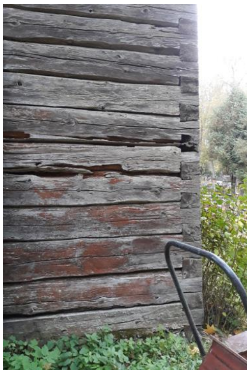
51, 52, 53. Vasakul fotol pruunmädaniku kahjustus kellatorni loodeseinas (allpool palkidel olev punakas värv on vetika põhjustatud) ja samad kohad lähivaates, 28.04.2019
