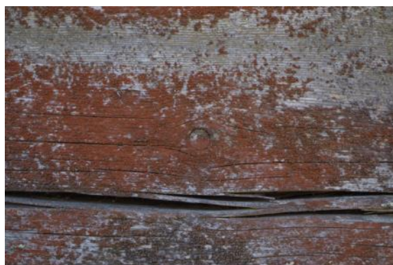
51, 52, 53. Vasakul fotol pruunmädaniku kahjustus kellatorni loodeseinas (allpool palkidel olev punakas värv on vetika põhjustatud) ja samad kohad lähivaates, 28.04.2019
