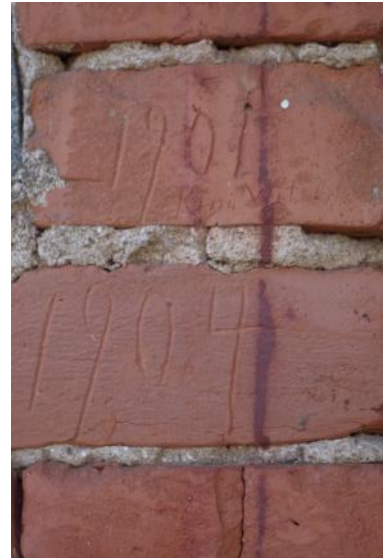
24, 25. Ust raamistav tellisladu ↑ ja telliste sisse kraabitud aastaarvud → 28.04.2019
