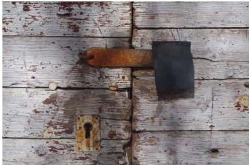
26, 27. Kabeli ukse sulused, 28.04.2019
