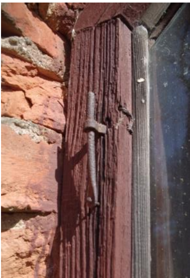
30. Hingedetail edelapoolse aknapiida küljes, 28.04.2019
