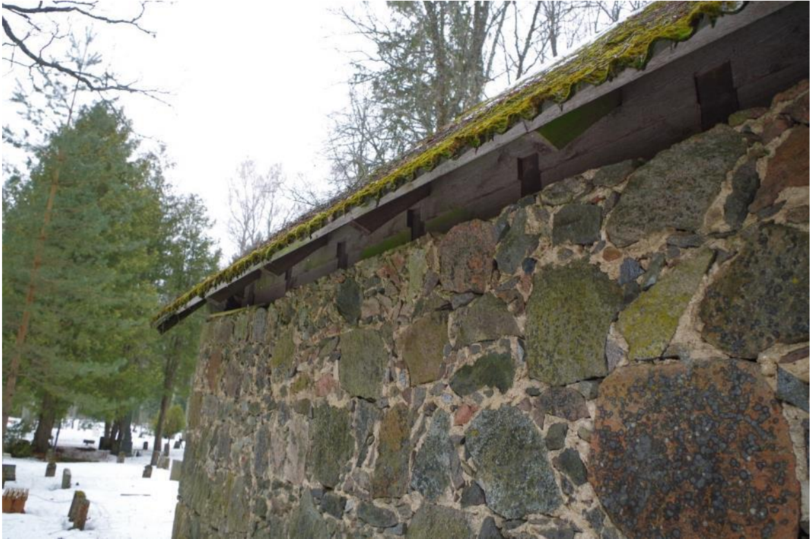
20. Kabeli tagumine külg, näha on kahest prussist koosnev müürlatt ja sarikate ning laetalade otsad, 19.02.2019
