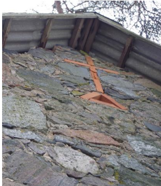
31. Dekoratiivne tellisrist ja tuulutussava edelaviilul, 28.04.2019
