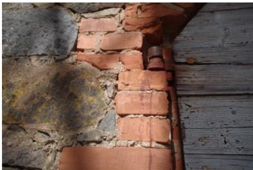
24, 25. Ust raamistav tellisladu ↑ ja telliste sisse kraabitud aastaarvud → 28.04.2019
