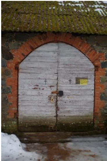
24, 25. Ust raamistav tellisladu ↑ ja telliste sisse kraabitud aastaarvud → 28.04.2019
