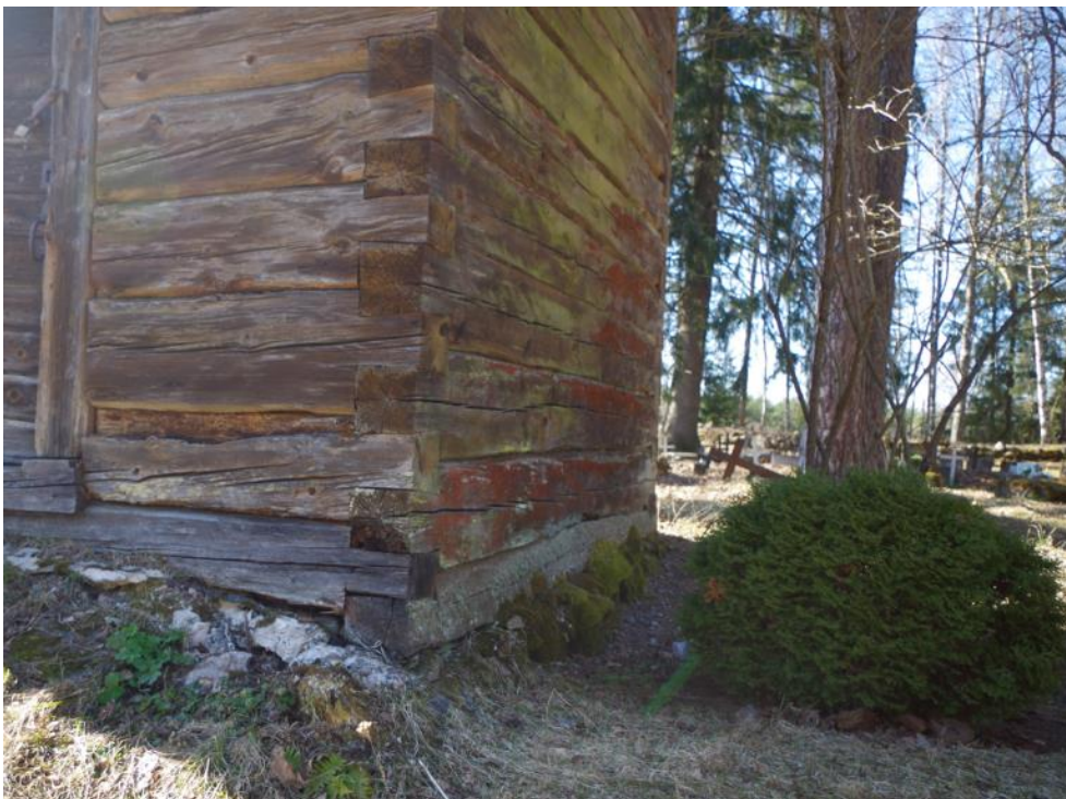
49. Kellatorni vundament, vaade idast, 28.04.2019
