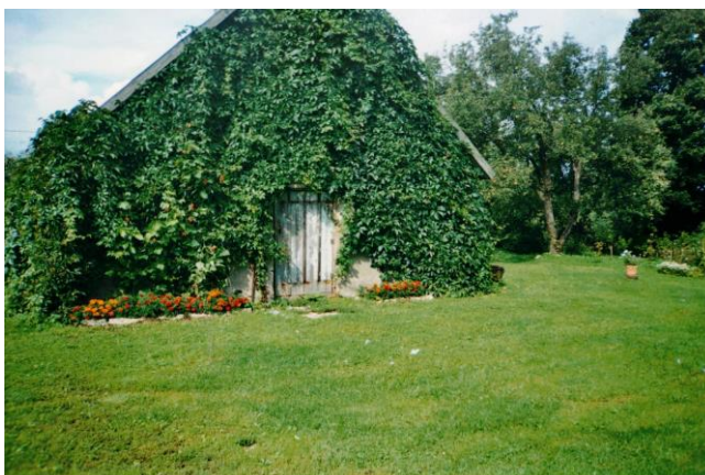
Joonis 31 Hoone tarinditele kahjulikku mõju avaldav haljastus
