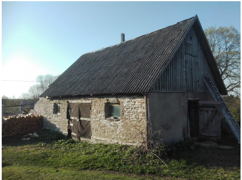
Joonis 29 Vaade laudalõunaküljele, vuugiparandused teostatud 2017
