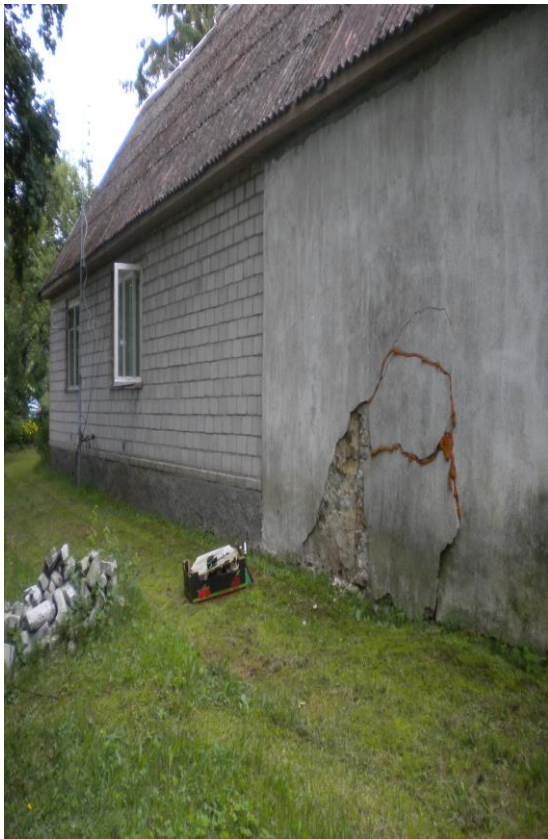
Joonis 45 vaade purunenud krohvile pækivi seinal
