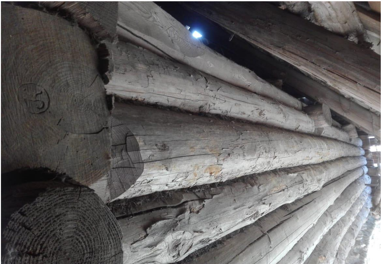
Joonis 68 Vaade Rehetoa palkseinale, palgiotsas pressitud meistrimärk
