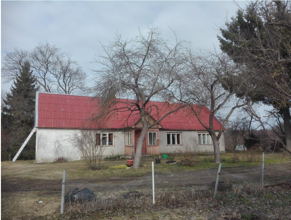
Joonis 37 Vaade elumajale lõunast
