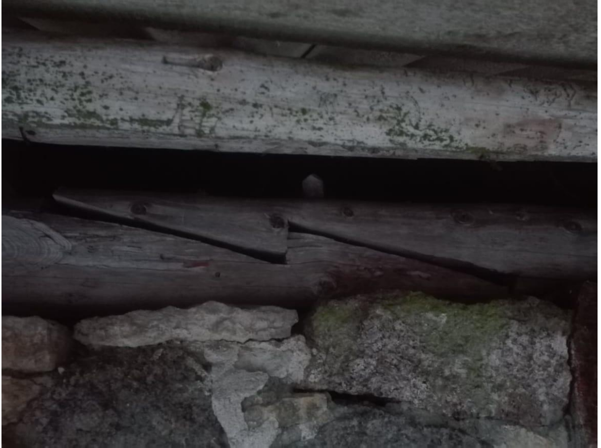
Joonis 67 Vaade müürpalkide jätkukohale
