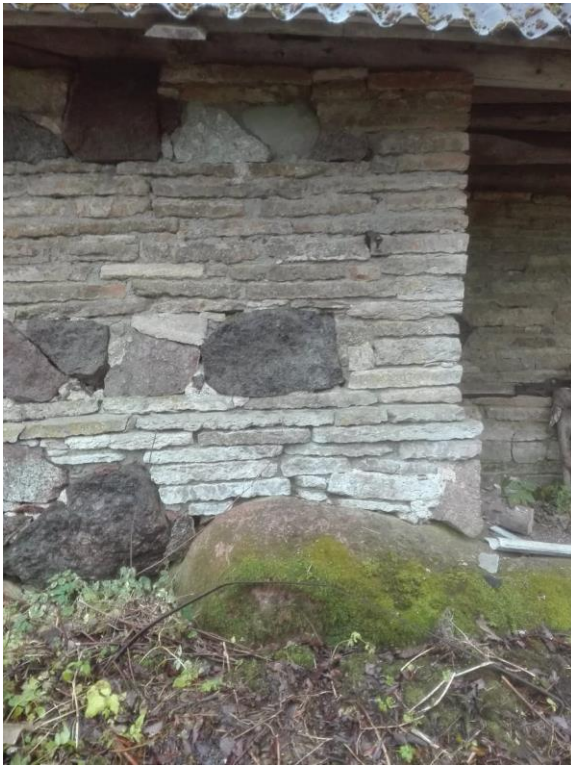
Joonis 59 Suurele kivile toestatud müüriti
