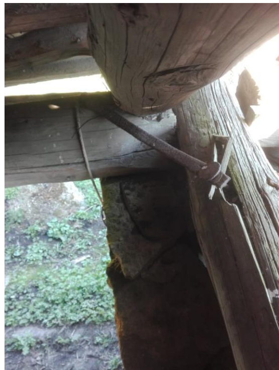
Joonis 58 Vaade müürpalkide nurgaseotisele, naelkoba
