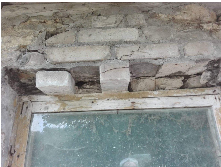
Joonis 27 Vaade lagunened aknasillusele
