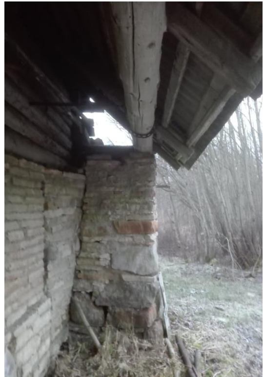
Joonis 60 Otsaseina tugipiilar, millel müürpalk
