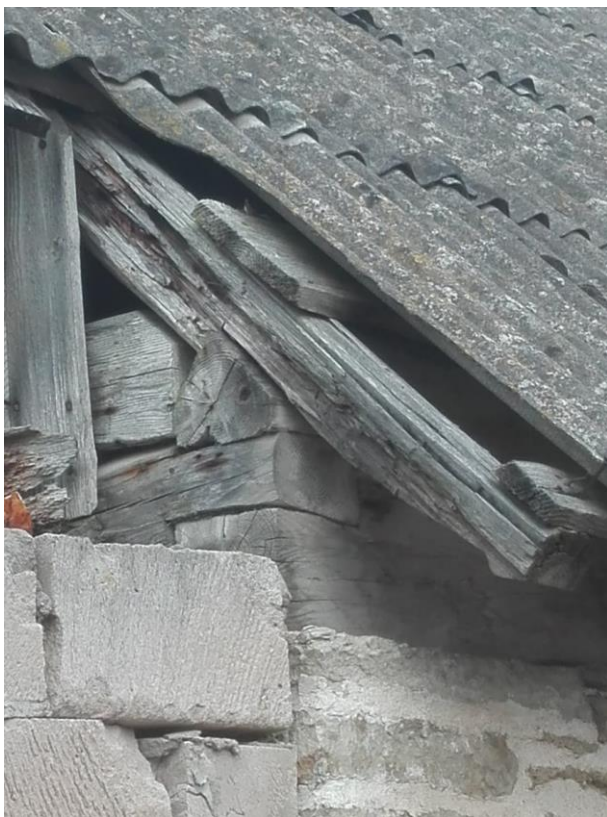
Joonis 30 sarikas ning müürpalgid ilmastikuolude käes
