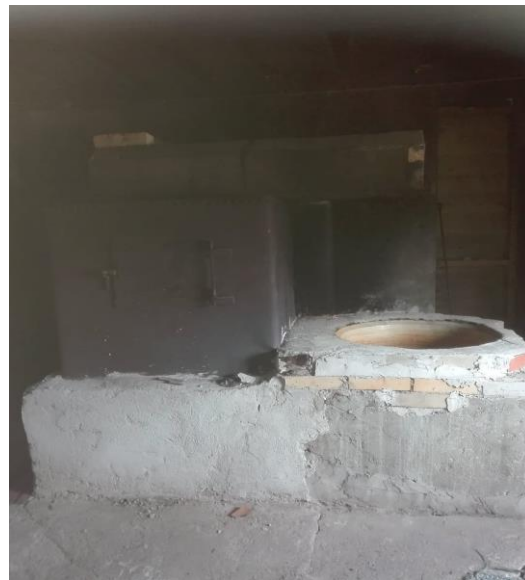
Joonis 15 Vaade kerisahjule ja põrandale
