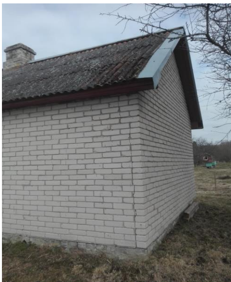
Joonis 14 Vaade praole seinas
