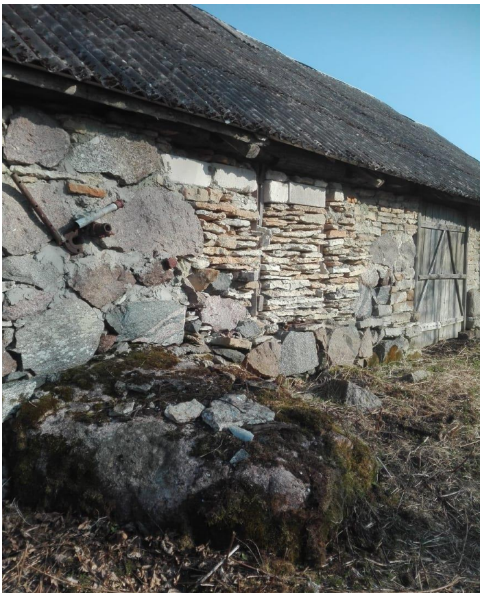
Joonis 65 Uuesti laotud müüritise osa lääneseinas
