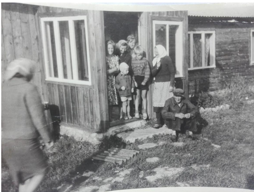
Joonis 36 Vaade eeskojale ja elumaja palkseinaale
