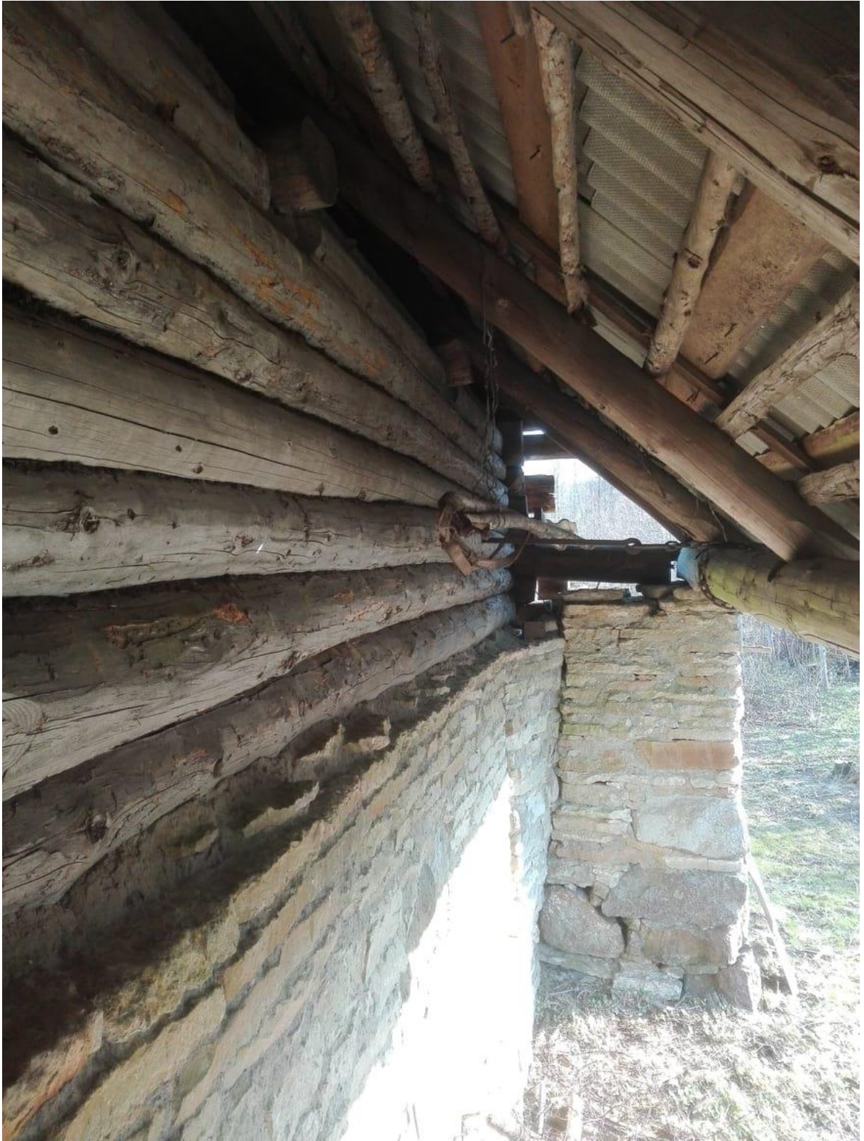
Joonis 73 Paekivimüüritisele aetatud rehetoa palksein on tihendatud ülemineku kohast saviga
