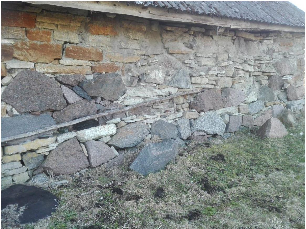
Joonis 70 Vaade esiseinale, milles on kive väljalangenud ja uuesti kinni laotud
