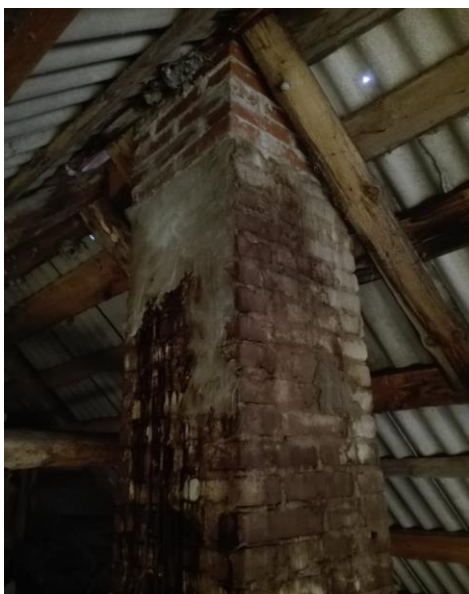
Joonis 40 Vaade pigitunud korstnapitsile pööningul
