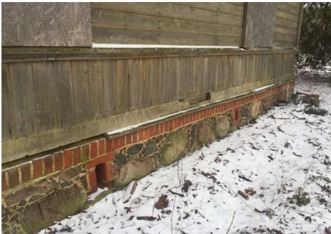
Foto 6. Hoone vundament ja sokkel. (Allikas: autori erakogu)
