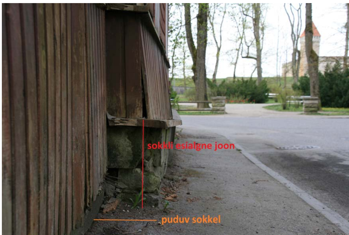
Pilt 5. Hoone väljavajunud sokkel Uuel tänaval.
