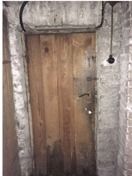
49. Keldri siseuks ja uksevõlv.
