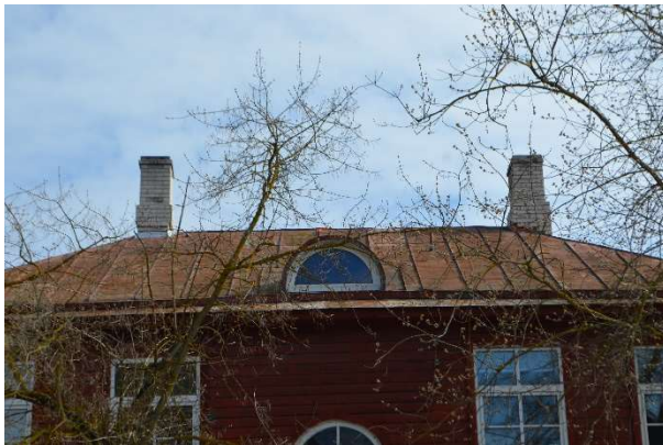
31. Vaade korstnatele esiküljelt.
