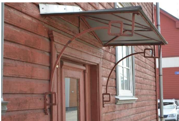
27. Varikatus ja sepistatud kandetarind.
