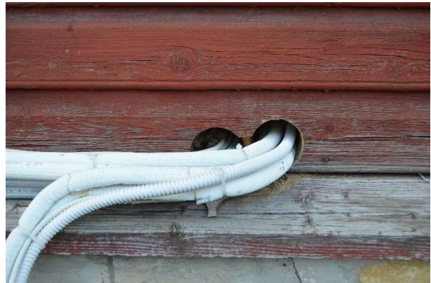
21. Tagakülje laudist läbivad õhksoojuspumpade torud.
