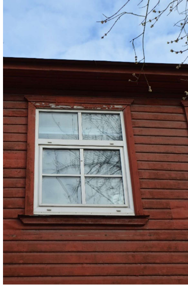
33. Teise korruse aken.
