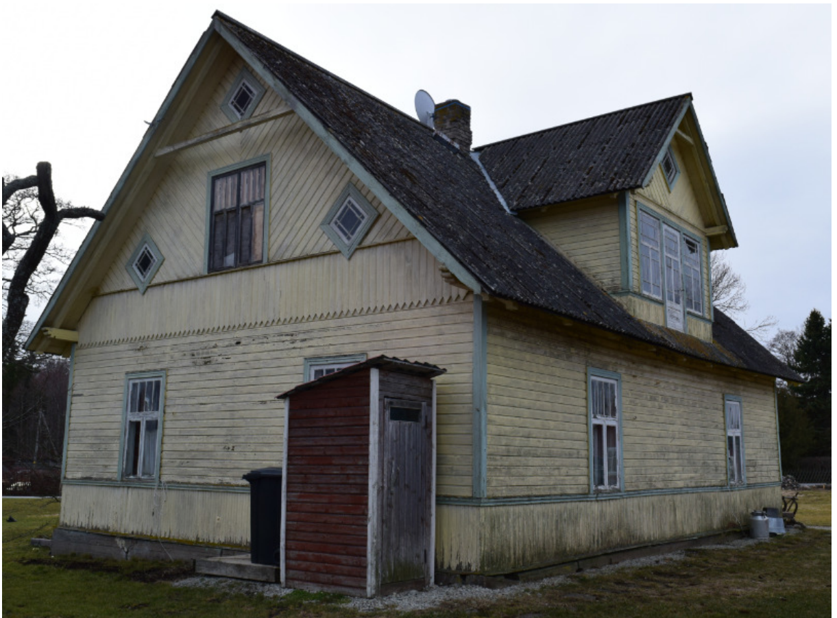
30. Hoone vaade kirdest. Autori foto.
