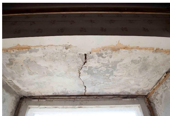
Foto 25. Interjööris vaadeldav pragu fotol 24 oleva akna kohal
