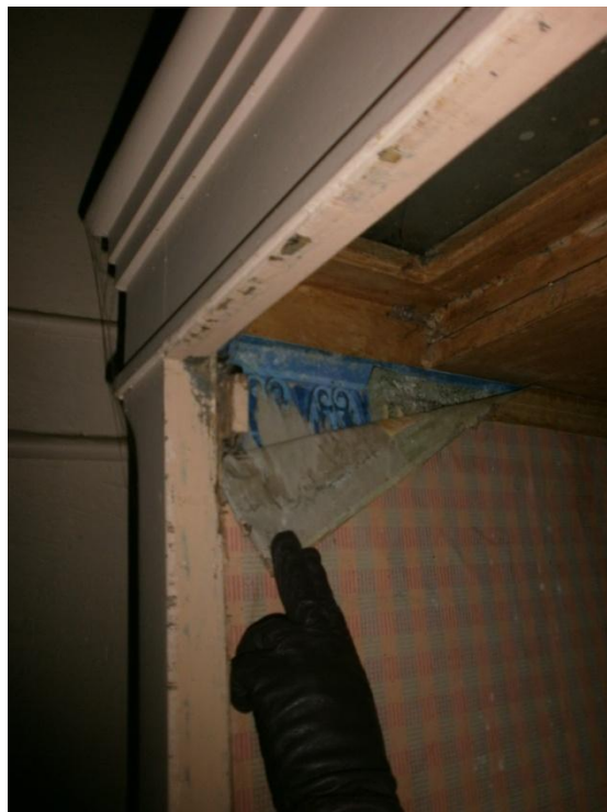
Ruumis nr 15 asuva kuivkäimla esimese tapeedi kihi bordüür . Foto: Kadri Tael, november 2012
