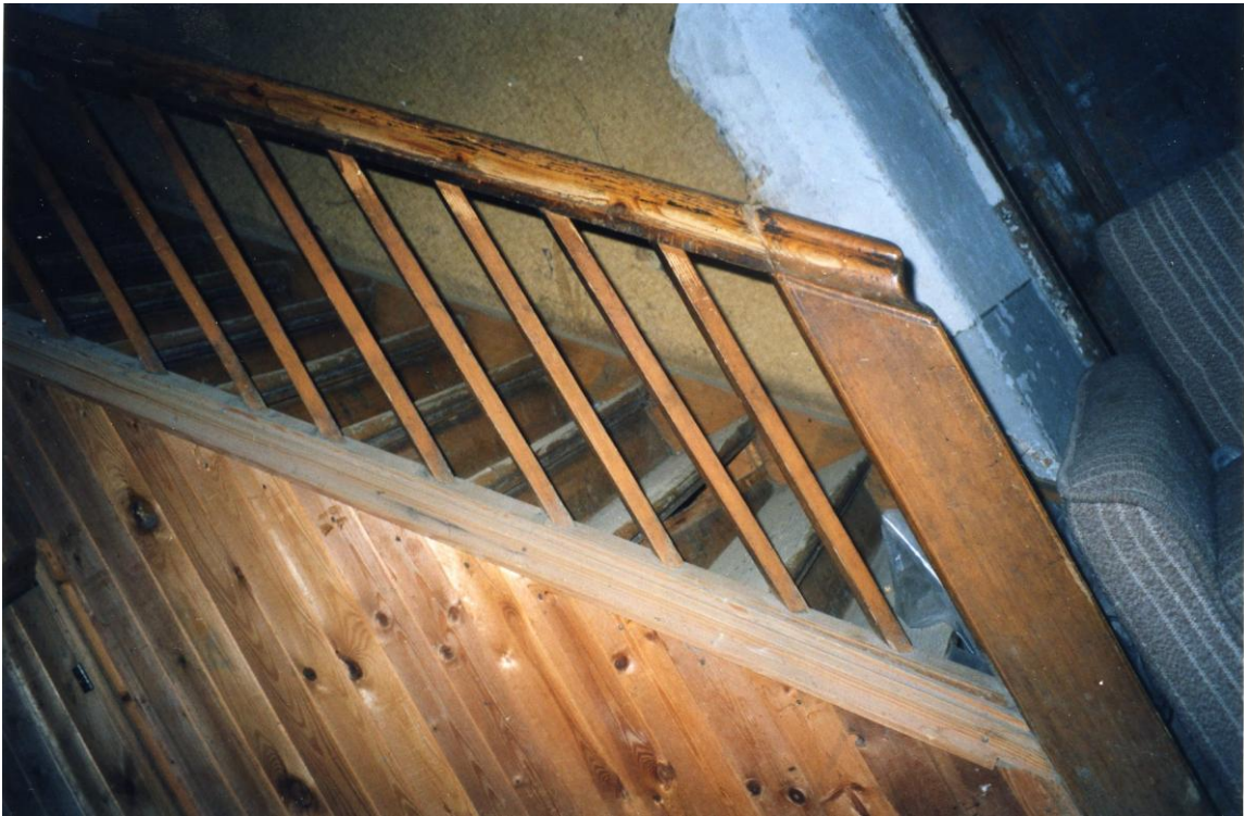
Pastoraadi trepp ruumis nr 9. OÜ Restauraatorprojekt. 2008
