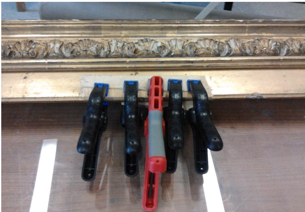
16. Lahtise puutüki kinnitamine PVA liimi abil.
