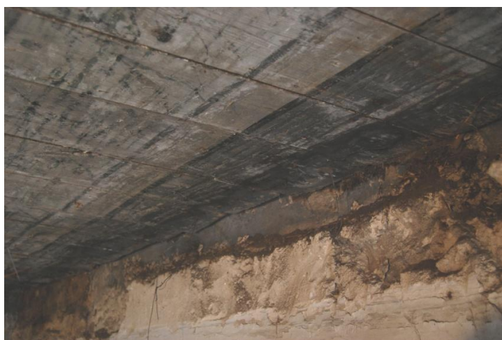
Ill 149 Sinakashall laudise-äär; krohvi alt paistab sarnase tooniga seinaviimistluskiht
