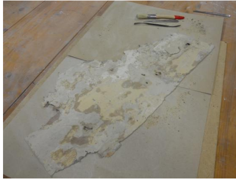
Ill 153 Tapeedikogumi tagakülje krohvist puhastamine
