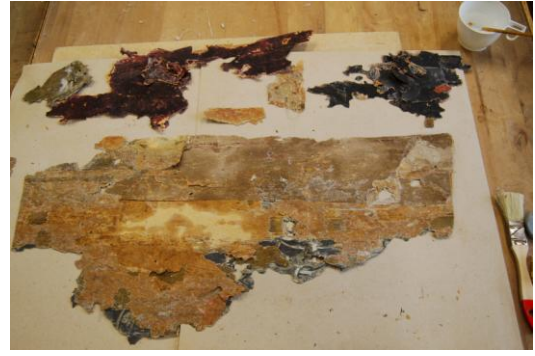
Ill 154 Tapeedikihtide eemaldamine
