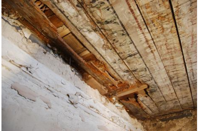
6. Tõenäoliselt mikroorganismide poolt kahjustatud laemaali piirkonnad Ülemine rida: väikese ruumi kahjustunud laudis (laudisel seenekolle); all vasakul: väikese ruumi seenekolle; all paremal: suure ruumi kahjustunud laudis
