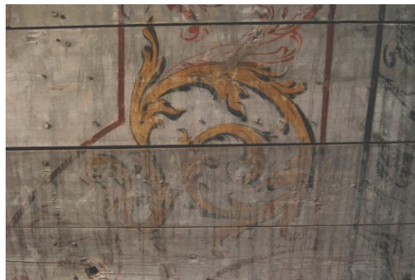
Ill 122 Maalingu puhastatud (üleval) ja puhastamata (all) pind.
