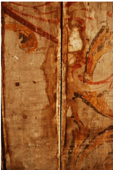
6. Tõenäoliselt mikroorganismide poolt kahjustatud laemaali piirkonnad Ülemine rida: väikese ruumi kahjustunud laudis (laudisel seenekolle); all vasakul: väikese ruumi seenekolle; all paremal: suure ruumi kahjustunud laudis
