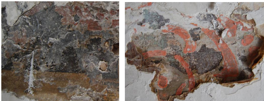
Ill 157 Kollase ookri ja musta värvi viimistluskiht krohvil. Näha on ka trafarettmaalingu-fragmente (paremal ülanurgas)
