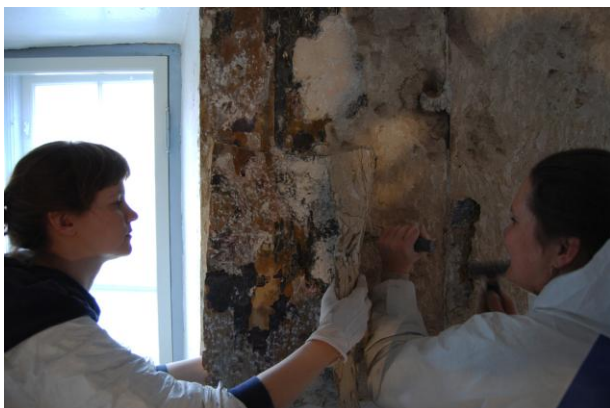
Fragmendi (viimistluskihtide) eemaldamine seinalt koos krohviga. Fotol: Kadri Kallaste, Maris Allik
