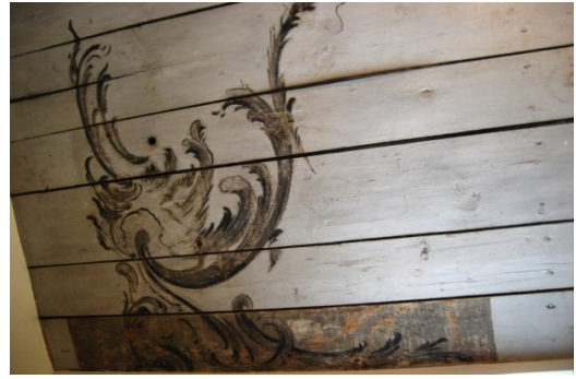
III 39 Suur-Karja tn 4 plafoon. Sondaažilõik, millel näha originaalmaaling
