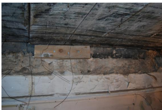
3. Paksu krohvi alt paistab oletatav laemaalingu -aegne seinaviimistlus (sinakashall vööt)
