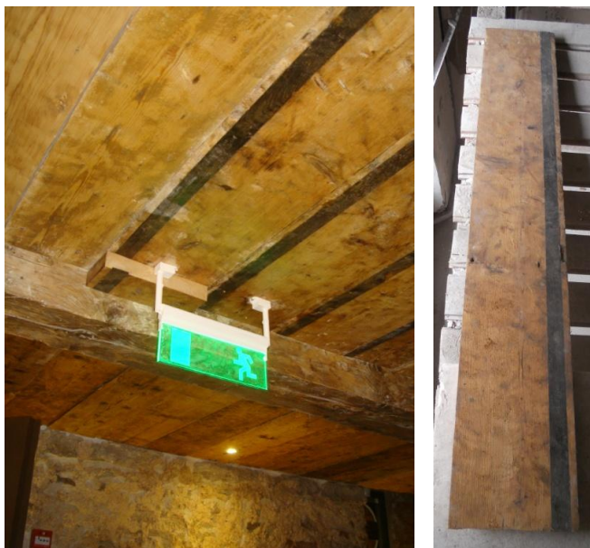
Ill 151 Vasakul: intarsiaga 2. korruse põrandalauad keldrikorruse laematerjaliks kasutatuna. Paremalt: intarsiaga põrandalaud
