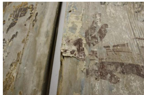
Ill 51 Sauna tn 4 maalitud laudade äärtes on säilinud paberiribad, mis olid kinnitatud laudise üleminekukohtadele ning olid ülemaalitud
