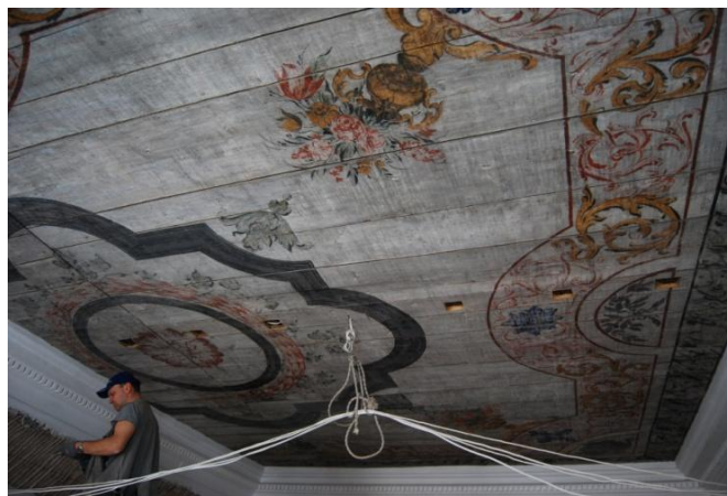
Ill 128 Uute puiduplommide paigaldamine (3. juuni. 2013)
