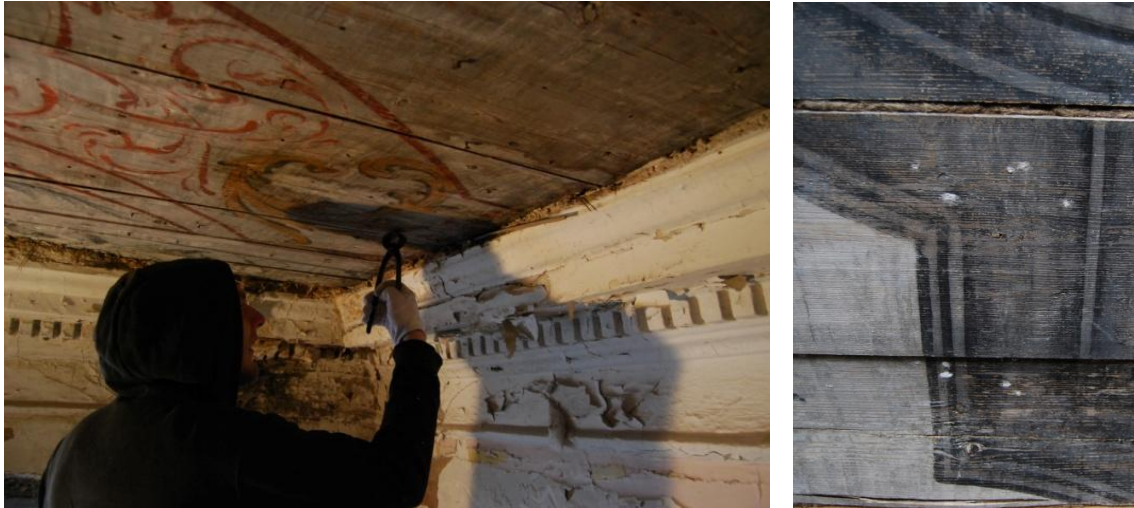
Ill 127 Naelte eemaldamine ja naelaaukude kruntimine
