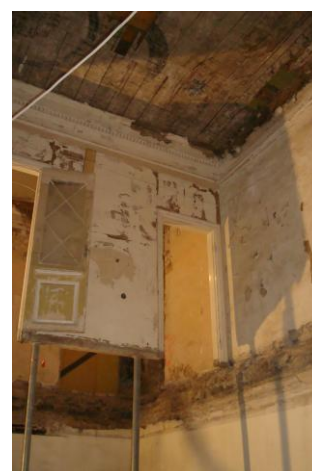
Ill 66 Laemaalinguga ruum, eemaldatud põrandakonstruktsioon
