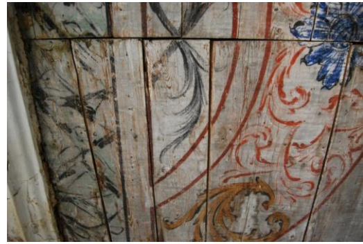
Ill 132 Lae tasapinda integreeritud kõmmeldunud lauad
