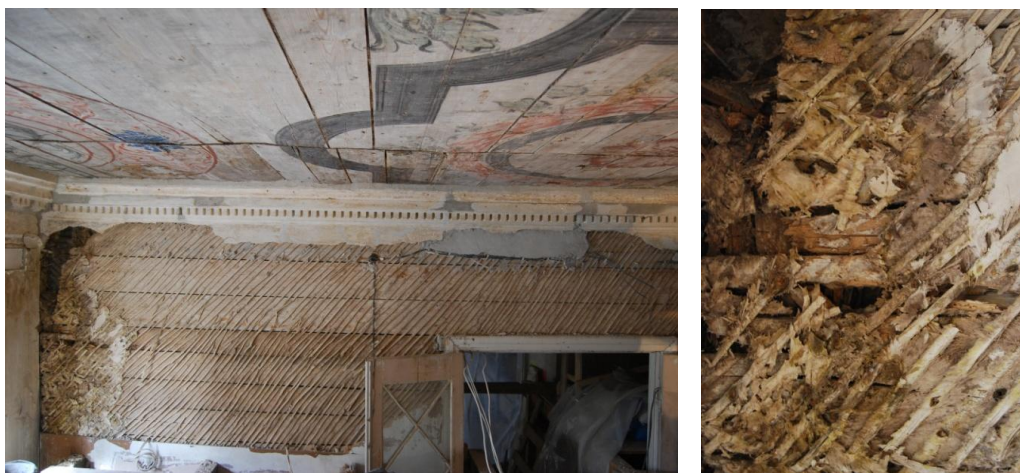
Ill 115 Mikroorganismide (seene) poolt kahjustatud vahesein
