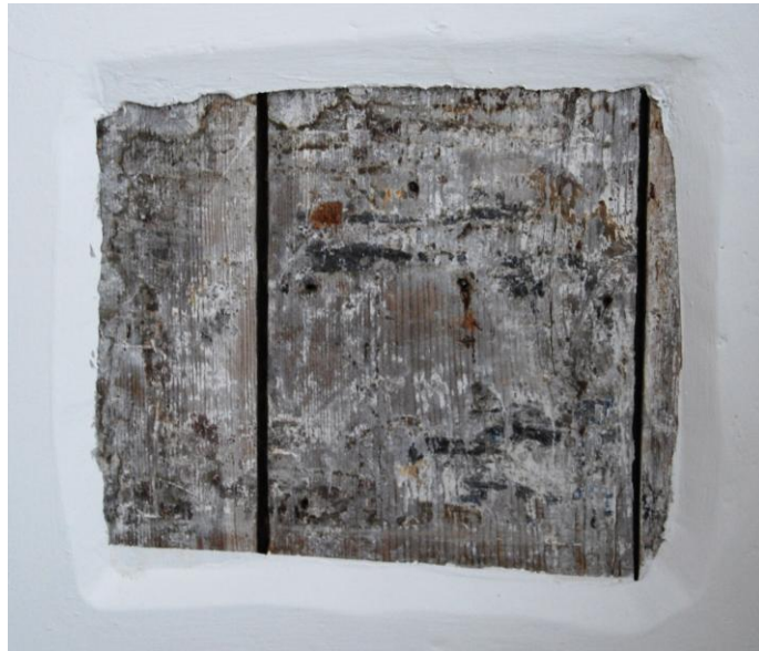
III 25 Lai tn 35. Köögi laesondaaž, millel on näha, et lage katab laudisplafoon
