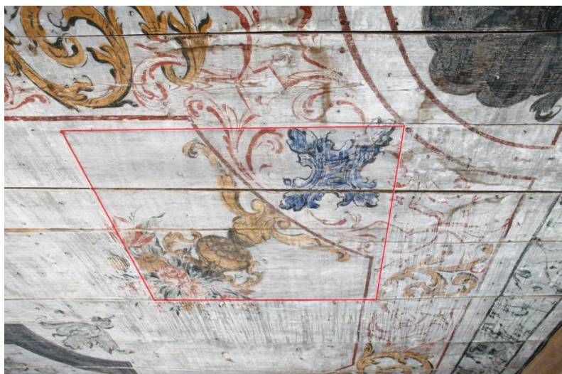
III 138 Punase joone sees on näidisala, mis on toneeritud; seda ümbritseb puhastamata maalingupind
