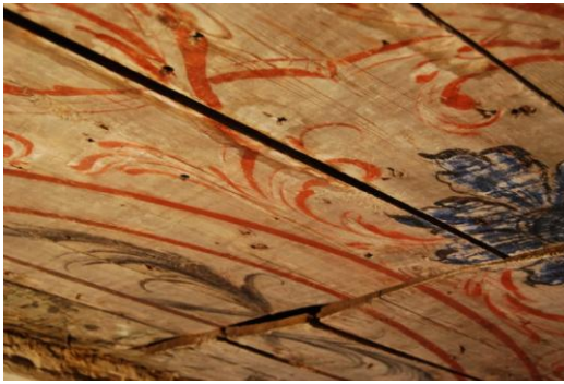
Ill 131 Laudise deformatsioonid
