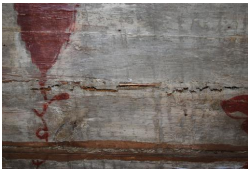
Ill 50 Suur-Karja 8, plafooni tuulepraod on kaetud lõuendiga ja maalitud
