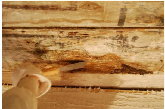
Ill 133 Seenekolde mehhaaniline eemaldamine
