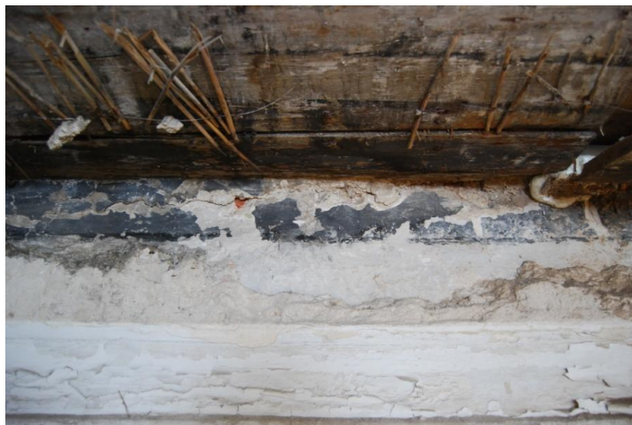
Ill 150 Suurem ruum. Hilisema paksu krohvi alt paistab seinaviimistlus, mis oli oletatavasti laemaalinguaeagne
