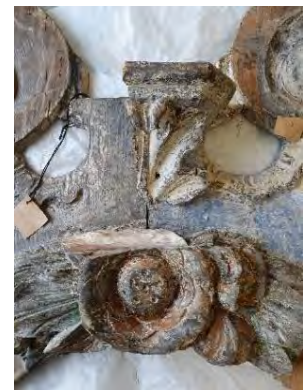
ill 86 ERMi objekti kolmetahuline poolkonsool, mida kaunistab akantusleht. Lauad on kokku liidetud kahest osast põõnade abil.
