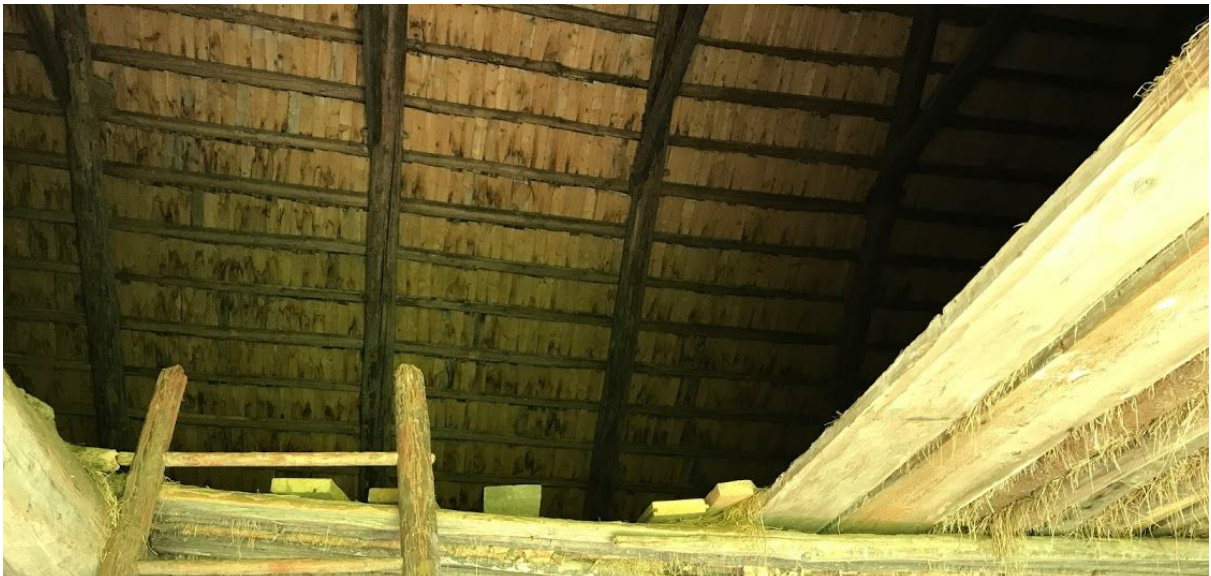
Illustratsioon 9. Vaade rehealuselt katuse konstruktsioonidele
