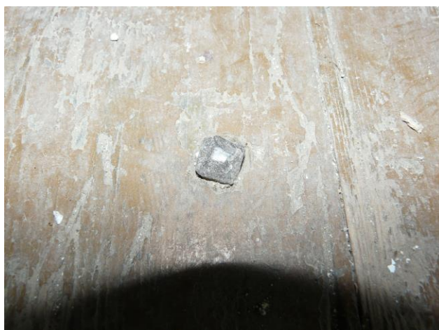
41. Läbi põrandalaudade on löödud sepistatud naelad
