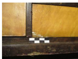
Pildid 1.- 7. detailid niiskuskahjustest.
