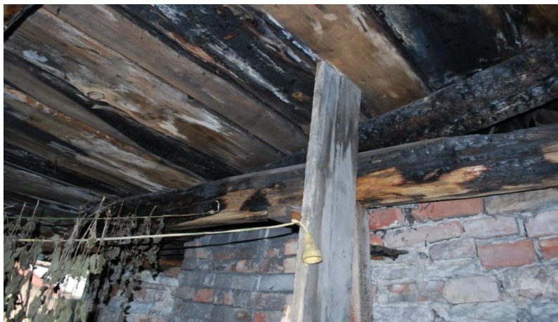
ill: 25. Abihoone põlemisjäljed hoovipoolsemas osas (kuuri ja abihoone vaheline sein) Foto 2008.
