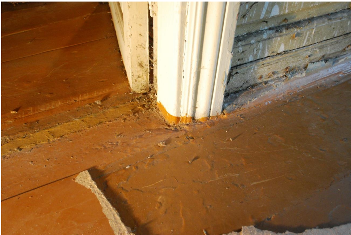
ill: 59. Vahesein on rajatud põrandava peale. Vahesein on hilisem. Foto 2008.
