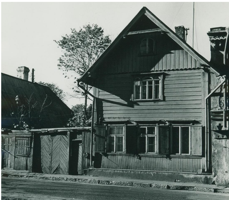
ill: 70. Poska tn elamu värav (kalasabamuster). Linnaprojekt AS arhiiv. Posak 39,41. TKVA. arhiiv, N: 9 – II 62.
