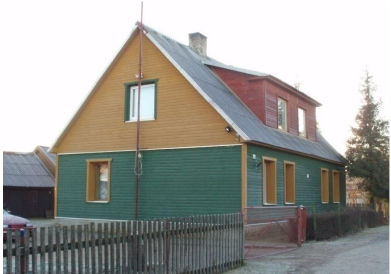
34. Renoveeritud hooned Valgejõe puiesteel, Küüni ja Hiie tänaval
