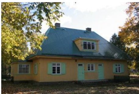
Foto 74. Liivia lastekodu algkool Saaremaal (1926-28). Kalle Kiipus, 2011.
