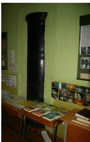
Foto 25. Tartumaal asuva Laguja koolimaja koridoris on säilinud vana plekkahi ja sulundlaudis seinal. S. Mälk, 2011.
