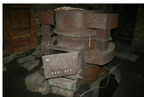
Foto 26. Simiste koolimajas Muhus on säilinud keskkütte-süsteemi katel. S. Mälk, 2011.
