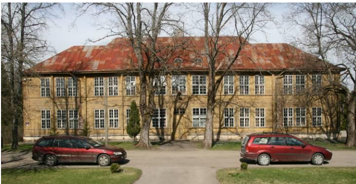
Foto 9. Taebla koolimajale Läänemaal paigaldati välisvooder viis aastat peale hoone valmimist 1935. aastal. Rõhtpalkhooned peavad saama vajuda enne kui vooder paigaldatakse. S. Mälk 2011.
