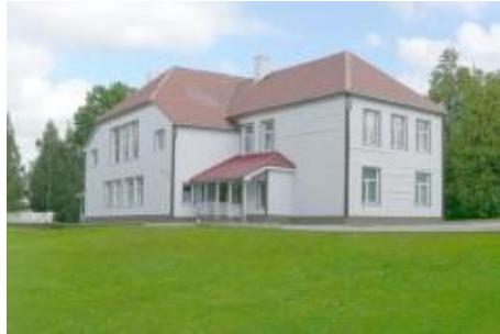
Foto. 213. Karaski koolimaja Põlvamaal (1930-32) on uue voodri ja akendega oma algupärasuse kaotanud. Karaski Keskuse kodulehelt.
