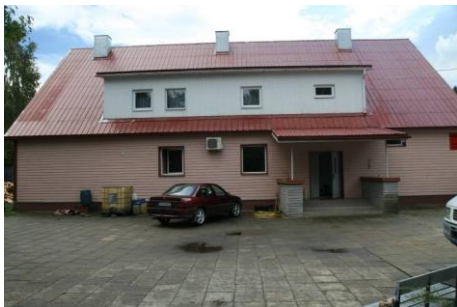
Foto. 202. Kuru koolimaja uute akendeavadega ja ruudujaotuseta aknad, profiilplekk-katus ning välissoojustus on kaotanud hoone algupära (vt ka foto 10). S. Mälk, 2011.
