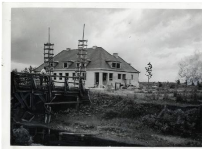
Foto 186. Vöiduküla asunduse algkool Pärnumaal. Silla ehitamine maakuivendamise tõttu rajatud Timmkanalile, u 1936. Eesti Ajalooarhiiv, f. 2111, n. 1, s. 15467.
