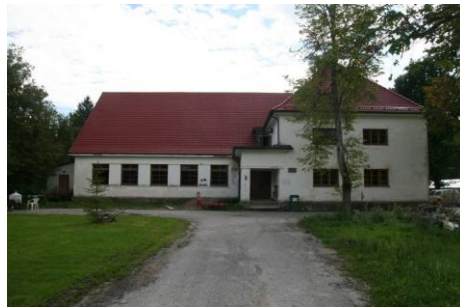
Foto 189. Lepplaane koolimaja korrastatakse ja seatakse elamuks sisse. S. Mälk, 2011.
