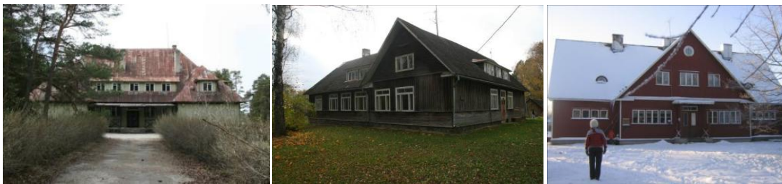
Foto 79. Harju-Risti koolimaja Läänemaal (1929–32) on kaetud katteliistuga püstvoodriga. S. Mälk, 2011.
