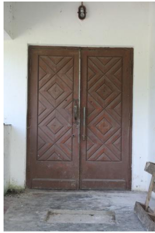
Foto. 192. Rahvapärasest ehitustraditsioonist üle võetud detail – diagonaallaudisega uks Lepplaane koolimajas. S. Mälk, 2011.
