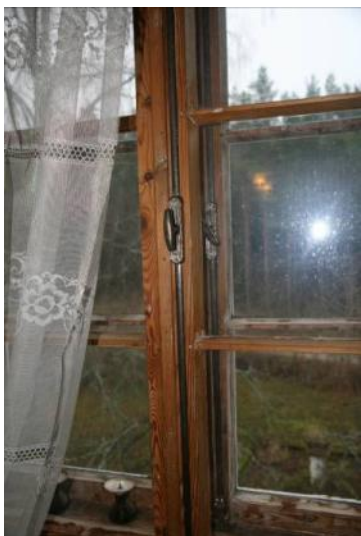
Foto. 223. Simiste koolimaja II korruse idapoolne aken originaalkreemoonide, haakide, klaasidega. S. Mälk, 2011
