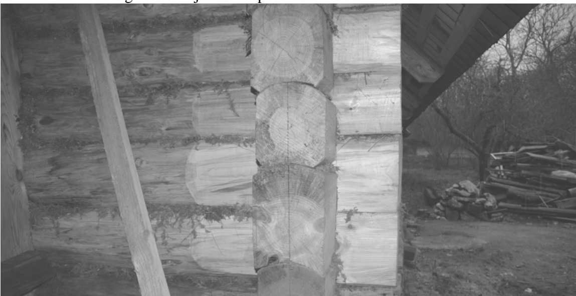
Foto 2.5.3. Kaasaegsed vahendid: asenduspalgid on meisterlikult kettsaega töödeldud. Uued nurgaliited on täpsemad kui algsed.
