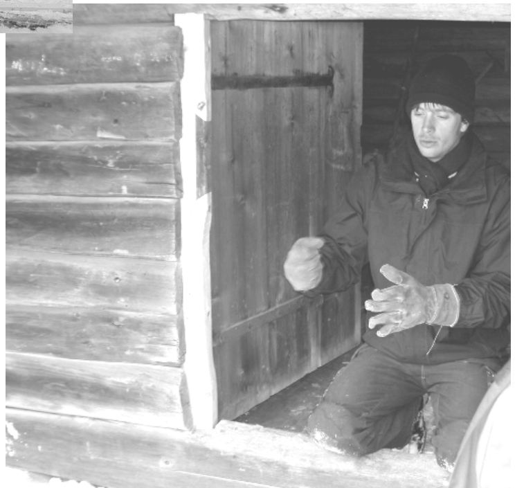
Foto 2.1.3. Jämtli Maakonnamuuseum. Ait Överhogdalsboden'i vallast. Praktika hindamine. Uus tenderpost algse proteesitud detailiga. Allikas: Lars Lundgren
