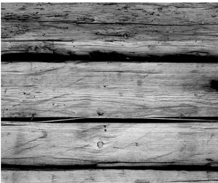
Foto 2.6.14. Sein A, palgid A9, A10 ja A11. Vanema tahumise jäljed
