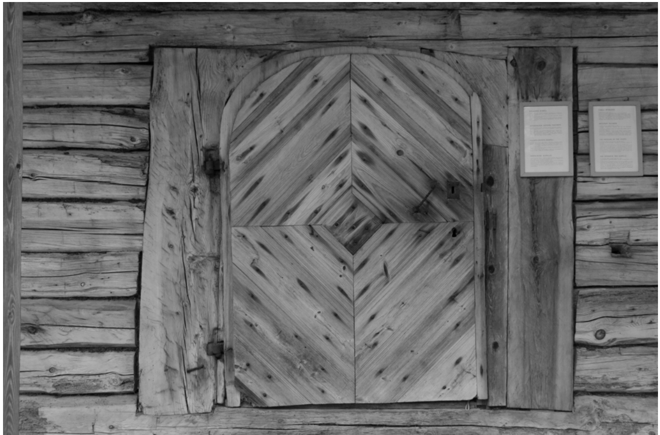
Foto 2.6.11. Kabeli peasissepääs, sein A. Enamus piirnevaid palke on algsed. Dateering vasemal tenderpostil B ning palgil ukse kohal A9 (1699)
