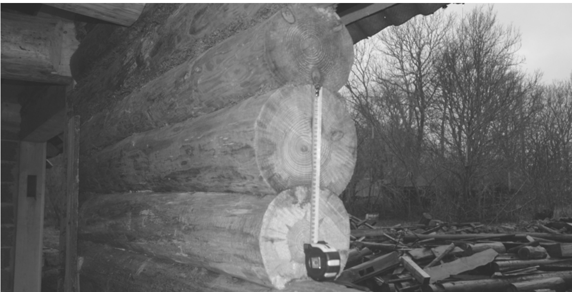
Foto 2.5.4. Asendusmaterjal: lüli- ja maltspuidu suhe on tagasihoidlik. Ülitäpselt valminud vara.
