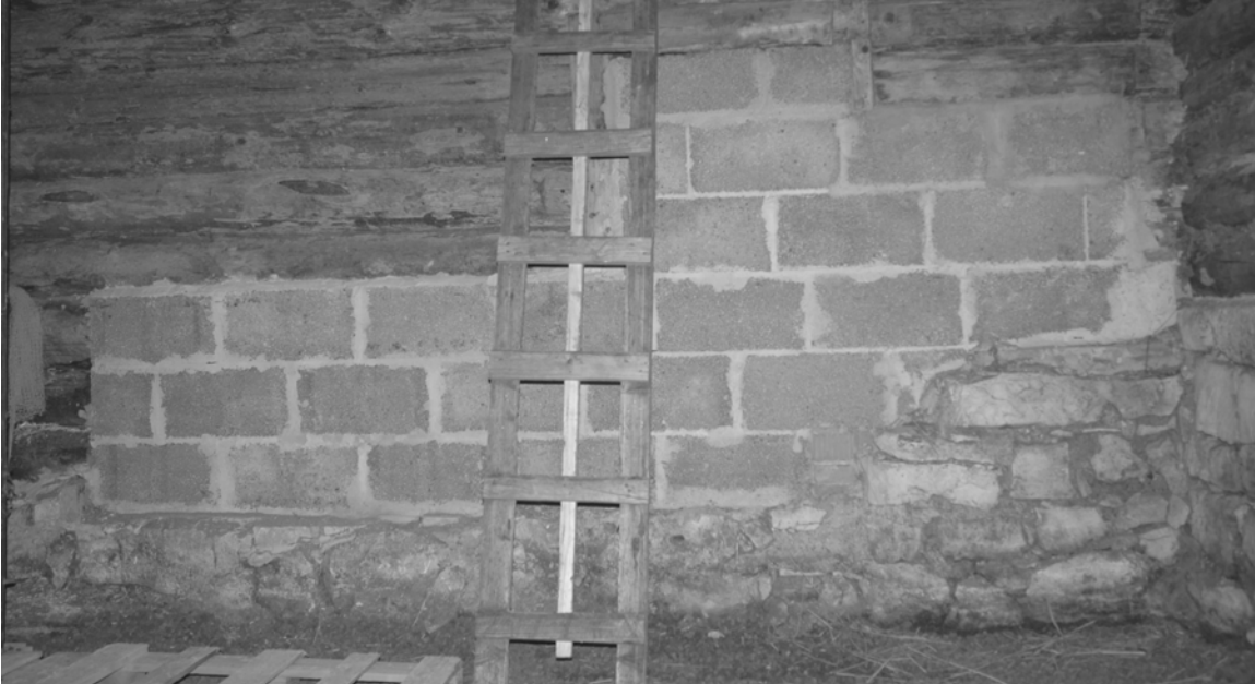
Foto 2.5.2. Kaasaegsed materjalid: fibroplokkidest laotud vahesein B.
