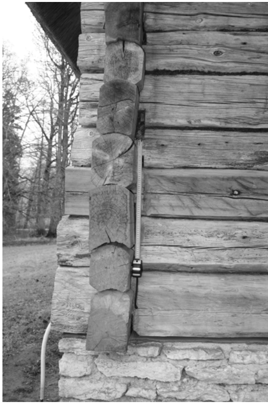
Foto 2.6.7. Nurk AB. Asenduspalgid on algsetest kitsamad
