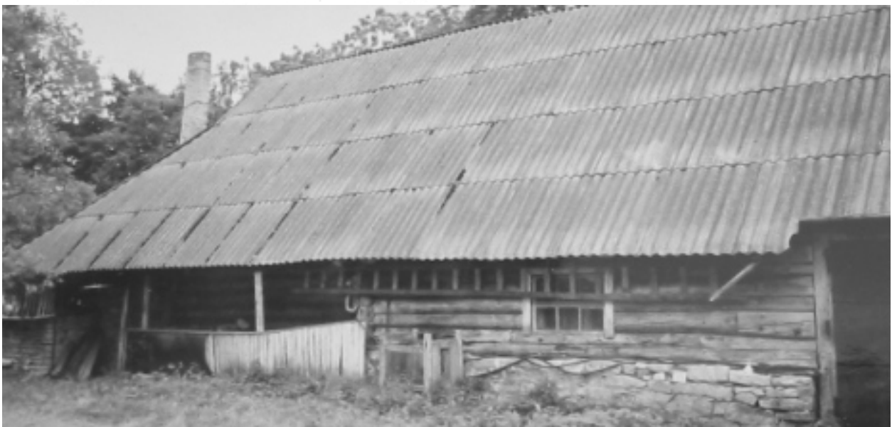
Foto 2.5.1. Laasu talu laudaosa. Põhjafassaad, sein D. Allikas: Rohtla 2003
