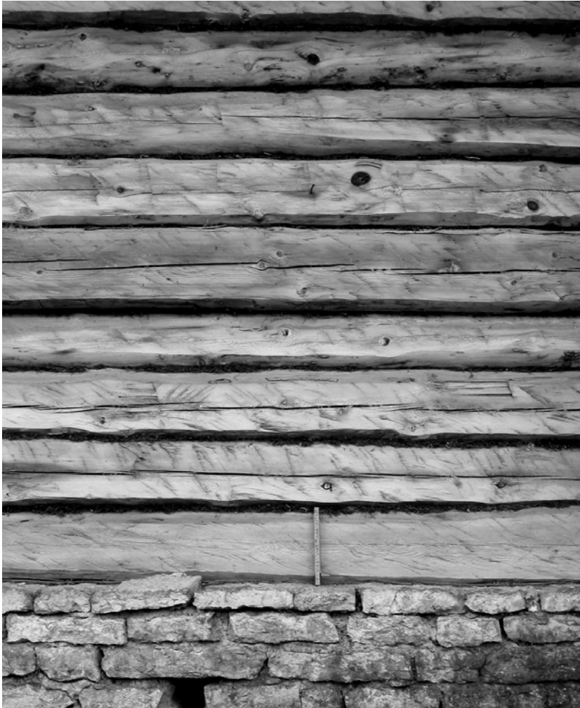
Foto 2.6.12. Sein D. Kabeli asenduspalkide töötlus. Igal palgil on näha veidi erinev tahumiskäekiri, tahumise nurk ja löögi rütm
