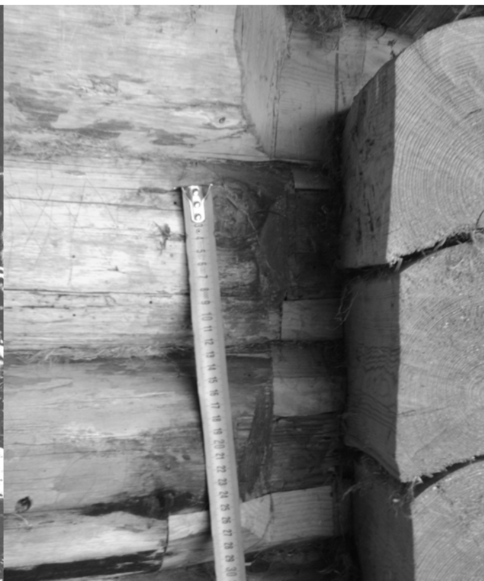
Foto 2.3.3. Palgi varamine kettsae ja künakirvega. Allikas: kilumets 2003
