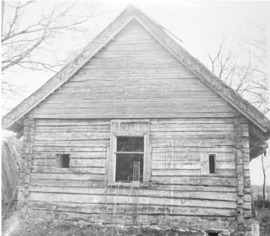
Foto 2.6.3. Sutlepa. Sutlepa kabeli idafassaad (sein E). Allikas: EVM 194: 1-41 R. Valdre
