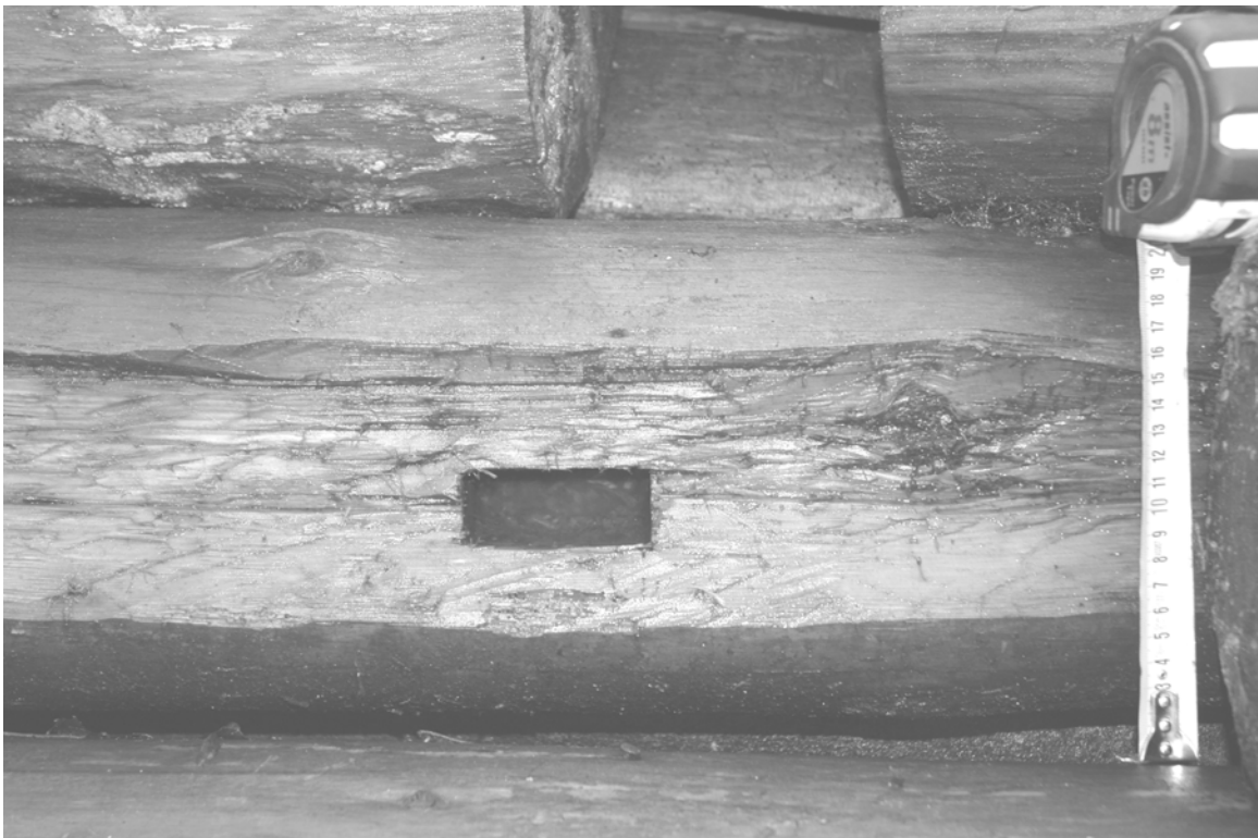
Foto 2.5.5. Konstruktsioonist eemaldatud seinapalk. Näha on kirvega raiitud vara ning salapulga auk.
