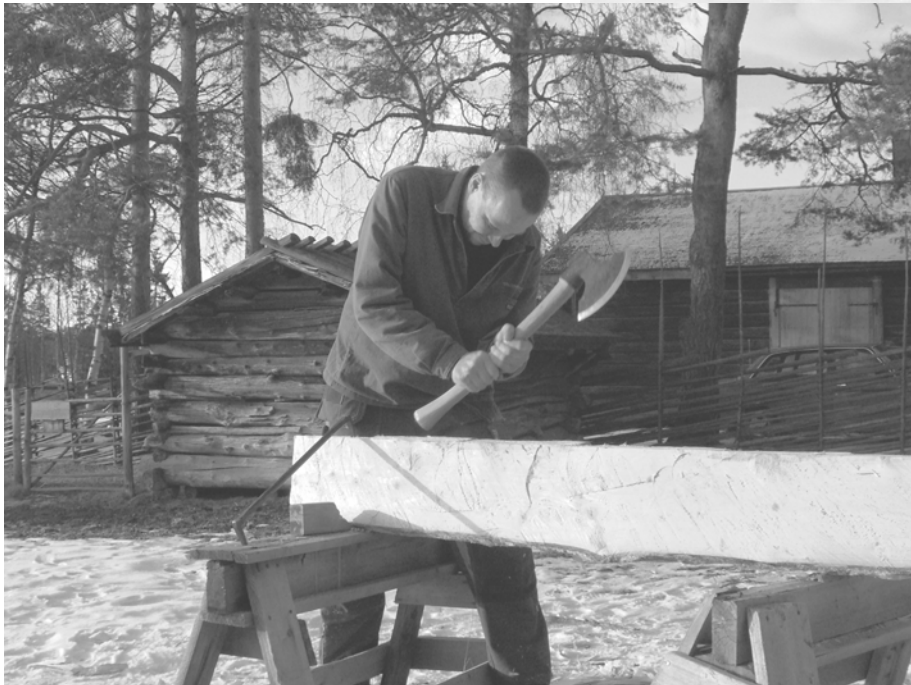
Foto 2.1.5. Jamtli Maakonnamuuseum. Mjölkboden på Fäboden. Asenduspalgi valmistamine rootsi tahumiskirvega. Allikas: Øyvind Svenning
