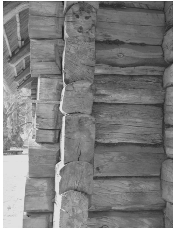
Foto 2.6.9. Nurk EF. Viga asenduspalkide kõrguste arvestamisel. Palgil F13 pole märgatavat õnarust
