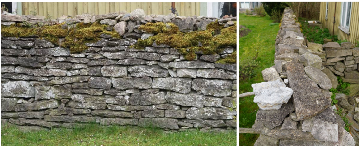
Foto 9 Pikk tn 41 ja 43 vahelisel piiril paiknev kuivlaona laotud kiviaed küljelt ja otsast vaadates.
