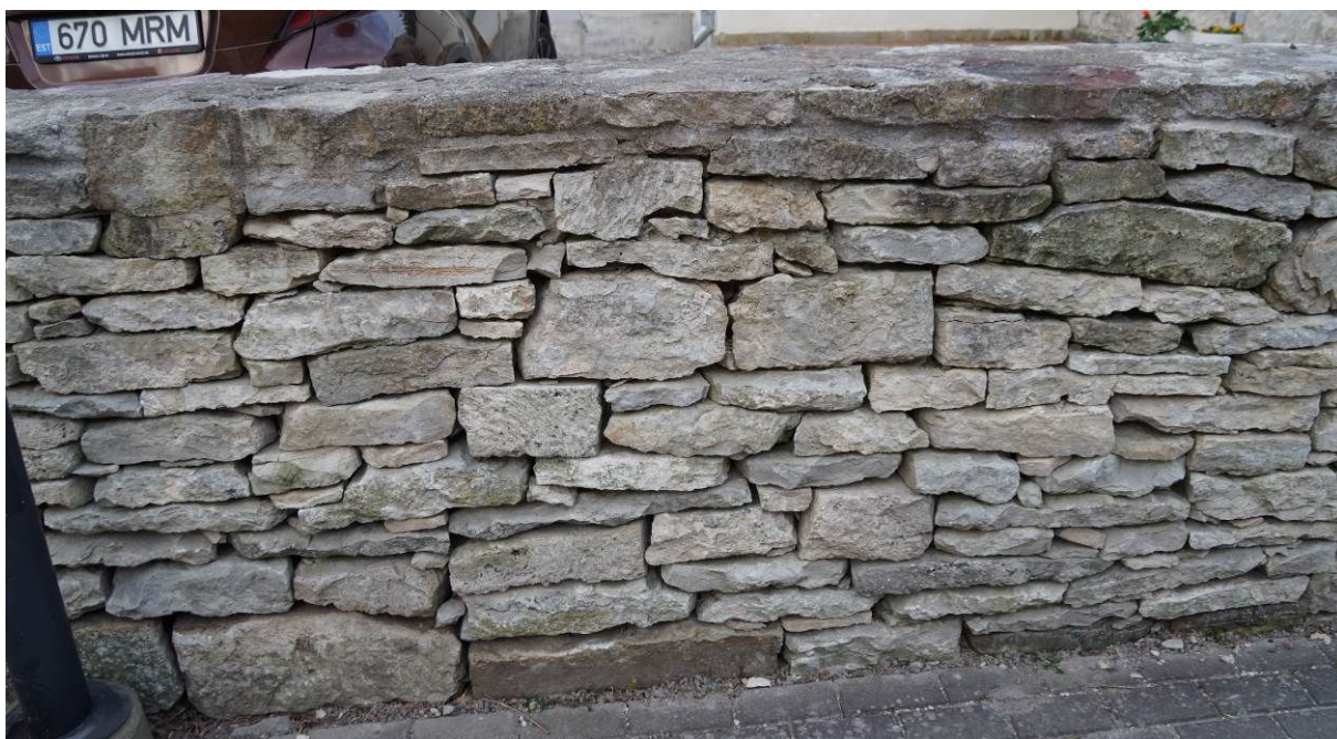
Foto 7 Kohtu 16A uus kiviaed. Kate puudub, s.t. viimane kiht on mõrdiga pealt kokku laotud.
