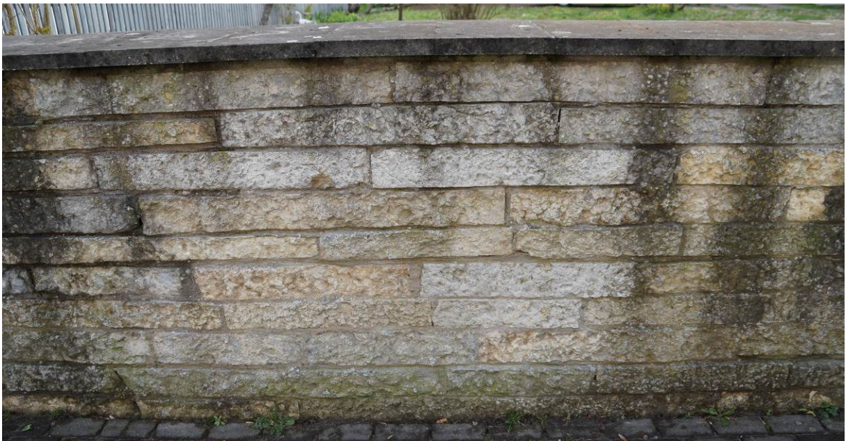
Foto 12 Kauba tn 17 otsas olev uuem kiviaed on tehtud saetud servadega ja murtud eksponeeritava küljega paekividest. Kiviread on enam-vähem ühtlase kõrgusega ja puhasvuugiga. Aial on dolomiidist katteplaat.
