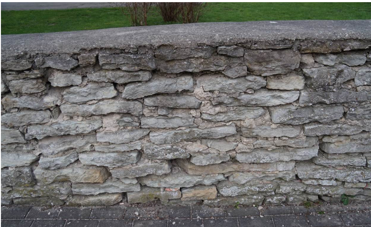
Foto 8 Kohtu tn 18 ees vana kiviaed, mille vuugid on juhusliku sügavusega ja võib aimata, et aed oli varem krohvitud.
