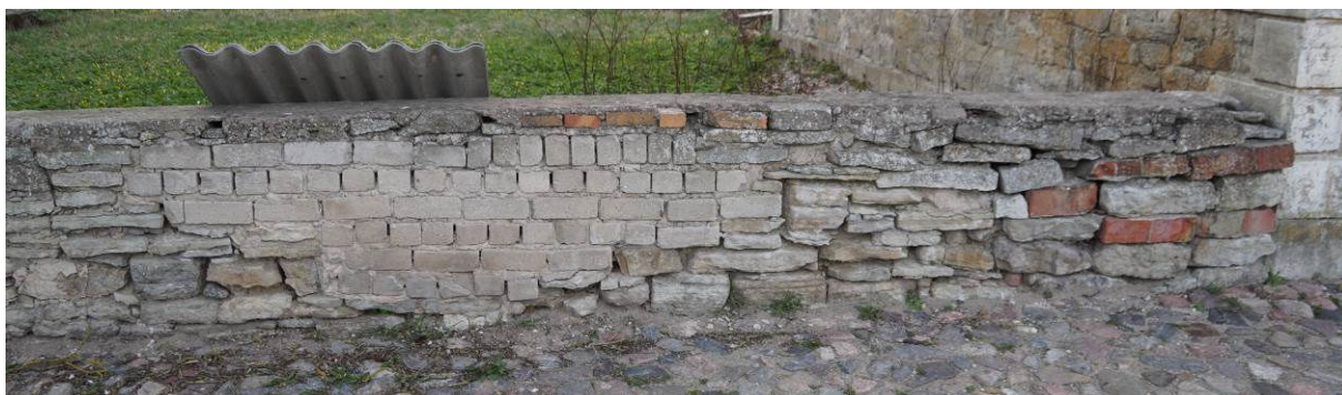
Foto 15 Pikk tn 56 kõrval olev kiviaed on korduvalt parandatud ja saanud kaootilise välimuse. Sellist kiviaeda ei ole võimalik vastupidavalt ja korraliku välimusega isegi krohvida ja tuleb korralikust paekivist uuesti laduda.
