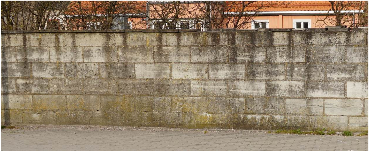
Foto 10 Pikk tn 25 ees olev vanem saetud pinnaga dolomiitplokkidest kiviaed. Kattekivide liitekohtadest ja purunenud kattekivide ümbrusest hakkab müüritise pind kiiremini määduma.
