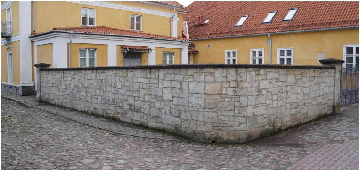
Foto 5 Kauba tn 12 Kohtu tänava poolne külj. Uus tahatud kividest kiviaed on korrektselt dolomiitplaadiga kaetud. Aia otstes reljeefse pinnaga dolomiidist väravapostid.
