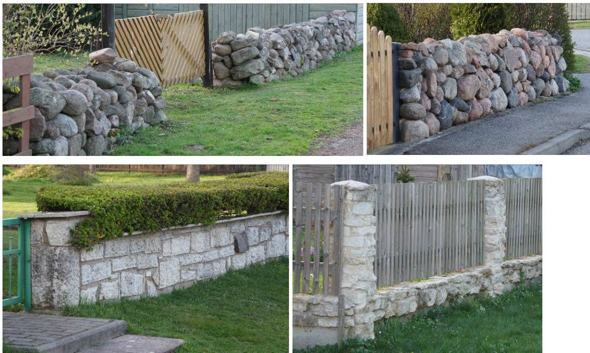
Foto 1 Kaks mördita laotud kiviaeda maakivist (ülemised fotod), mördiga laotud madal paekiviaed (vasakul all) ja murtud paekividest sokli ja postidega puitlippaed (all paremal) Kuressaare aedlinna piirkonnas.
