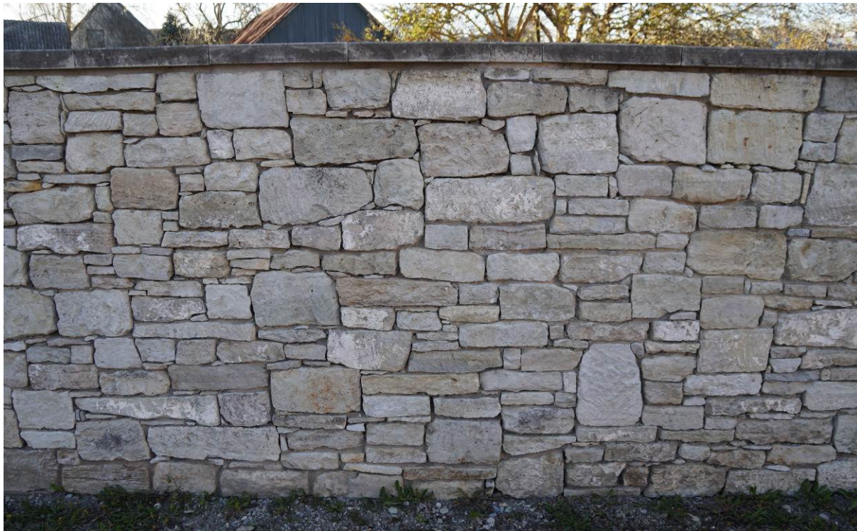
Foto 6 Suur-Sadama tn 7 uus dolomiitplaadiga kaetud kiviaed
