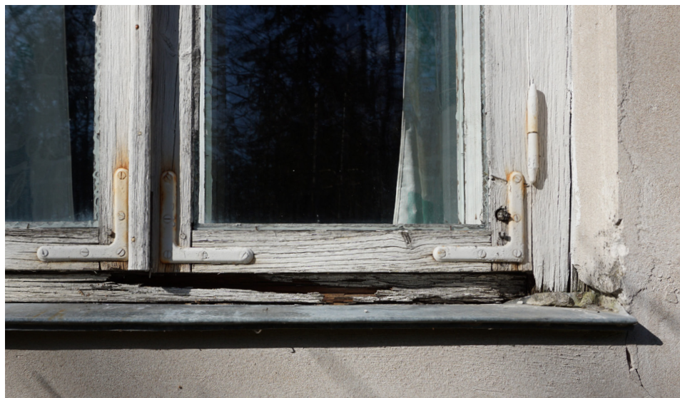
Illustratsioon 15. Hävinud aknaleng hoone lõunaküljel; foto asukohast 9
