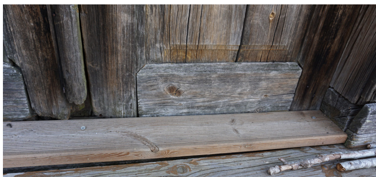
Illustratsioon 23. Veranda välisuksed; foto asukohast 16
