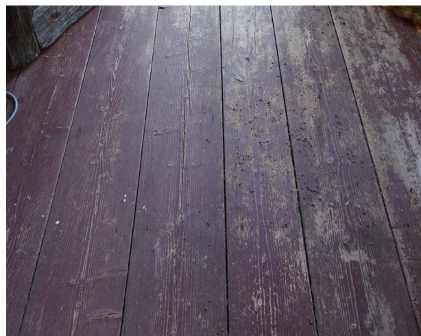
Illustratsioon 13. Säilinud põrandlauad; foto asukohast 7
