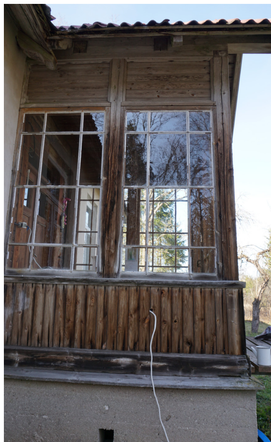
Illustratsioon 20. Veranda lõunakülg; foto asukohast 14
