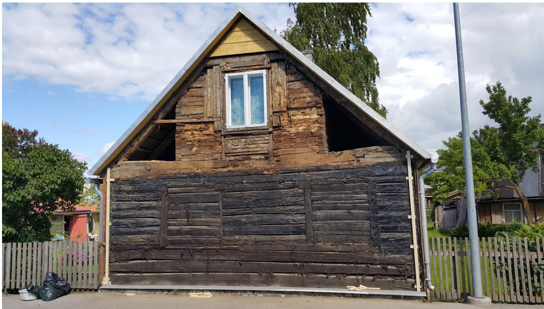
17. Lõunapoolne välissein avatuna. Foto: Peeter Jalakas.
