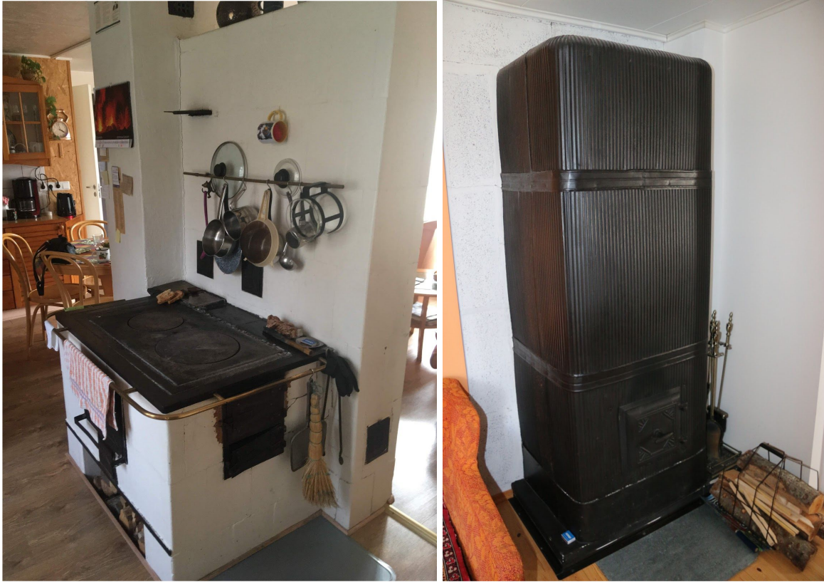
25, 26. Soojamüüri pliit ja ahi. Fotod: Gerda Ruuser ja Peeter Jalakas.
