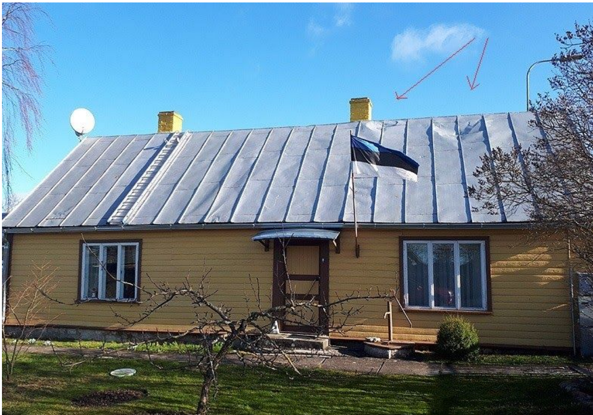
21. 1938–1939 paigaldatud „inglise plekist” katus. Nooltega on tähistatud 1944. aasta sündmuse meenutama jäänud mõlgid. Näha on ka kahte suurt läänefassaadi akent. Foto: Peeter Jalakas.
