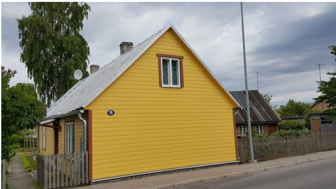
18. Lõunapoolne välissein pärast soojustamist. Foto: Peeter Jalakas.
