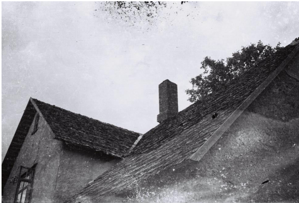
Foto 18: Püksi talu eluhoone vaade katusele lõunast. Alar Jürgensoni erakogu. Autor teadmata. 1960-ndad
