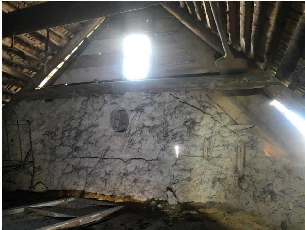
Foto 5: Püksi talu eluhoone loode seina juurdeehitus ja vanad sarikapesad. Autor Tominga. 30.04.2020
