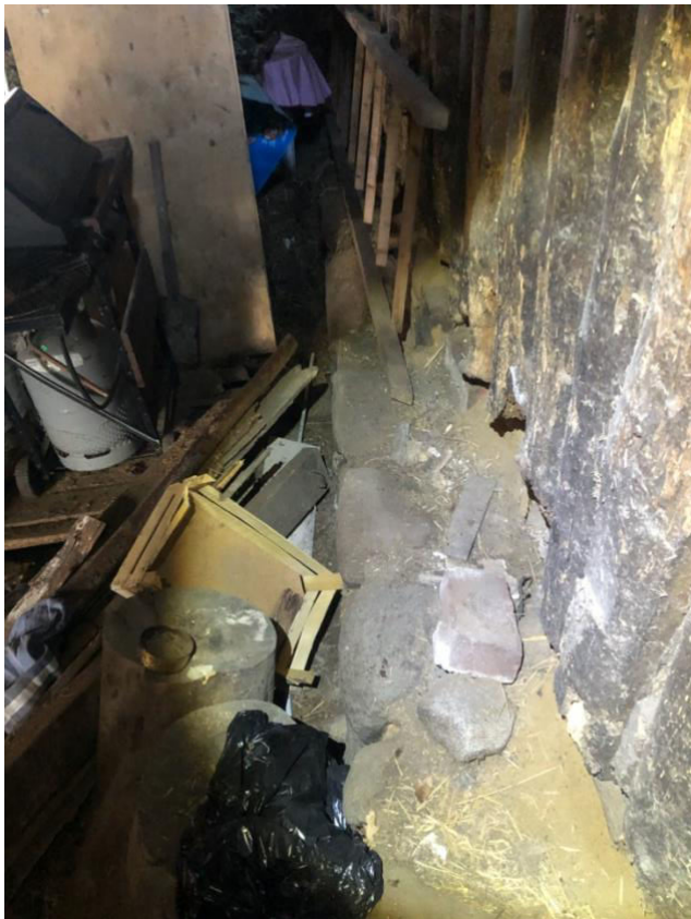
Foto 4: Püksi talu eluhoone eluruumide ja abiruumide vaheline sein. 60cm laiuse maakivivundamendi näol võib arvata, et algselt on seal olnud savisein. Autor Tominga. 30.04.2020
