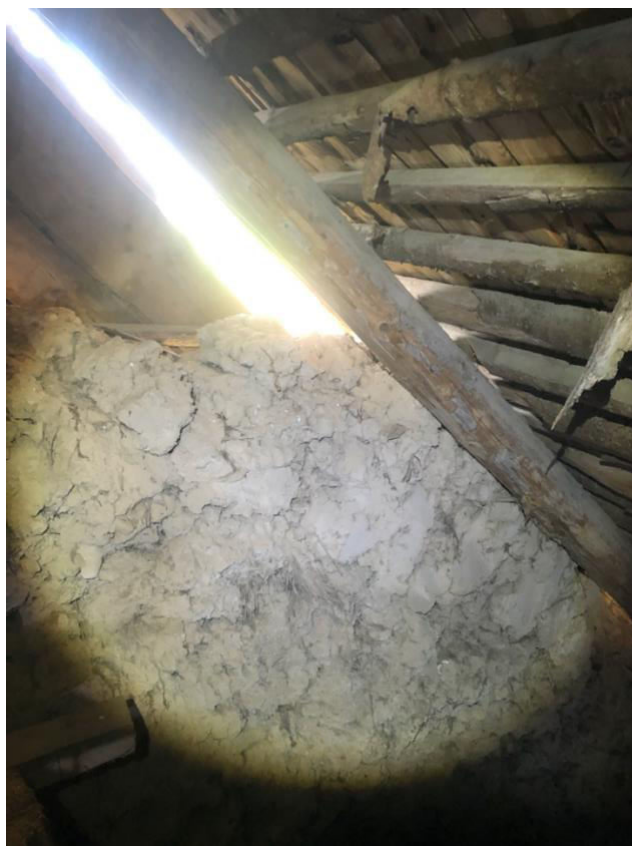
Foto 6: Püksi talu eluhoone loode seina juurdeehitus. Katuse kõrgemaks ehituse käigus on lisatud saviseinale täidet. Autor Tominga. 30.04.2020
