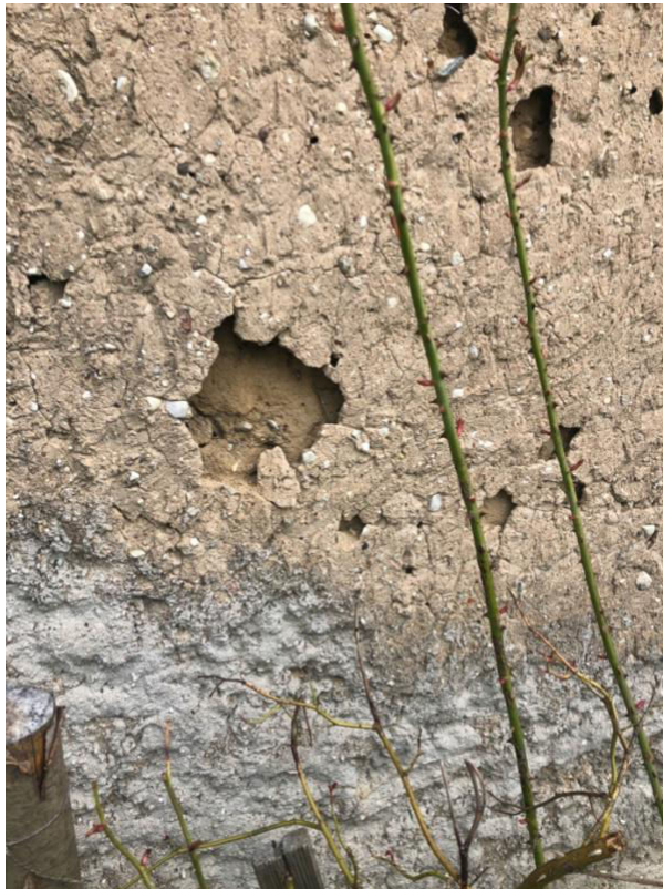
Foto 14: Püksi talu eluhoone edela seina irdunud savikrohv (lisatud ka stabiliseerimiseks lupja) ja seda kattev lubikrohv. Autor Tominga. 30.04.2020
