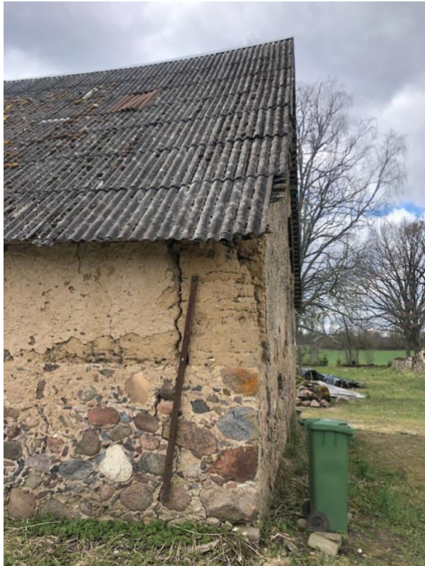
Foto 17: Püksi talu eluhoone nurk põhjast vaadatuna. Autor Tominga. 30.04.2020
