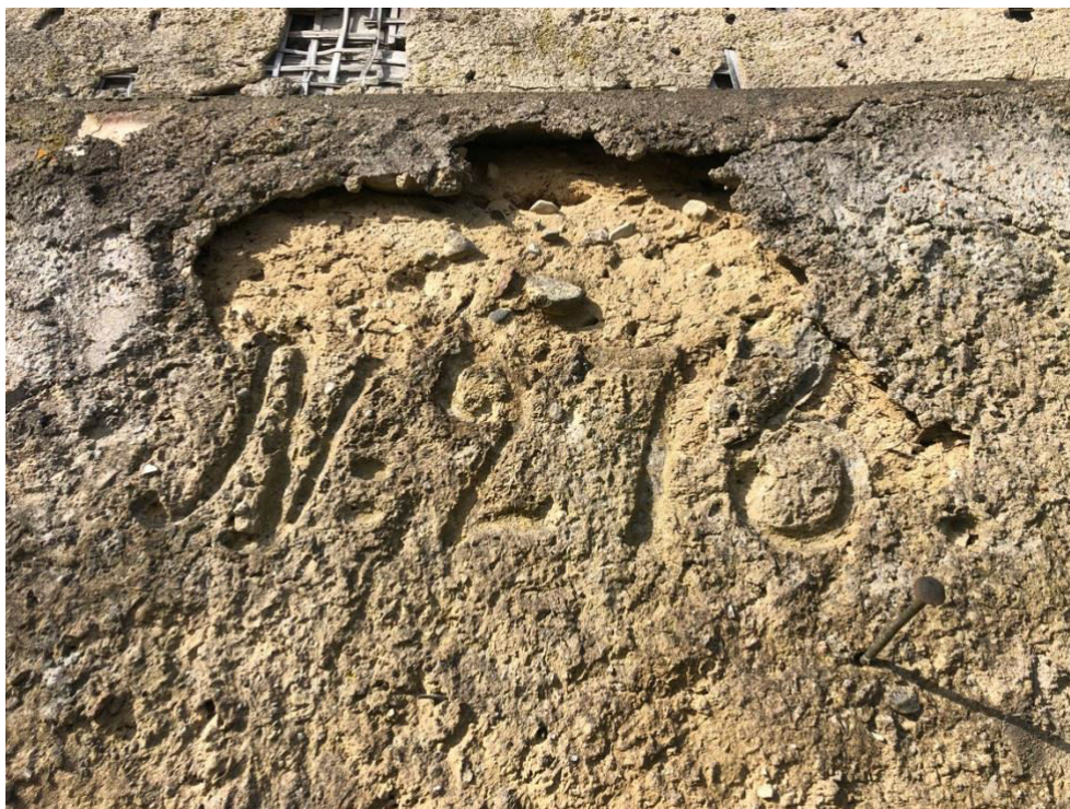
Foto 24: Püksi talu nr kirde seina lubikrohvis. Autor Tominga. 30.04.2020
