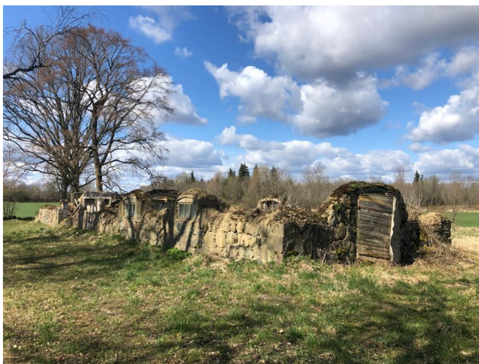
Foto 12: Püksi talu lauda varemed. Autor Tominga. 11.04.2020
