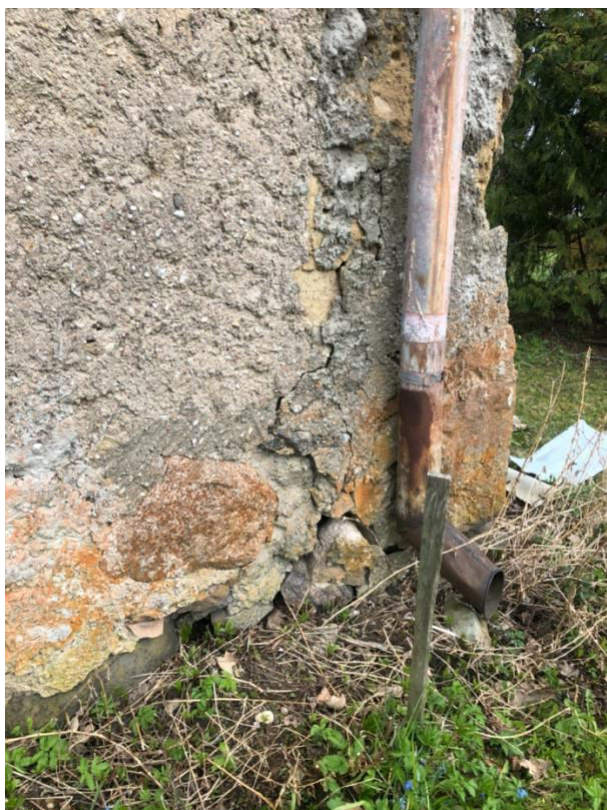
Foto 20: Püksi talu eluhoone lõuna nurga vundamendi kahjustus. Autor Tominga. 27.04.2020
