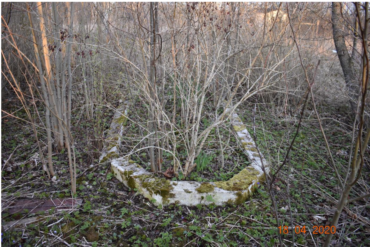
Foto 13. Betoonäärüstusega peenrad esiväljakul.
