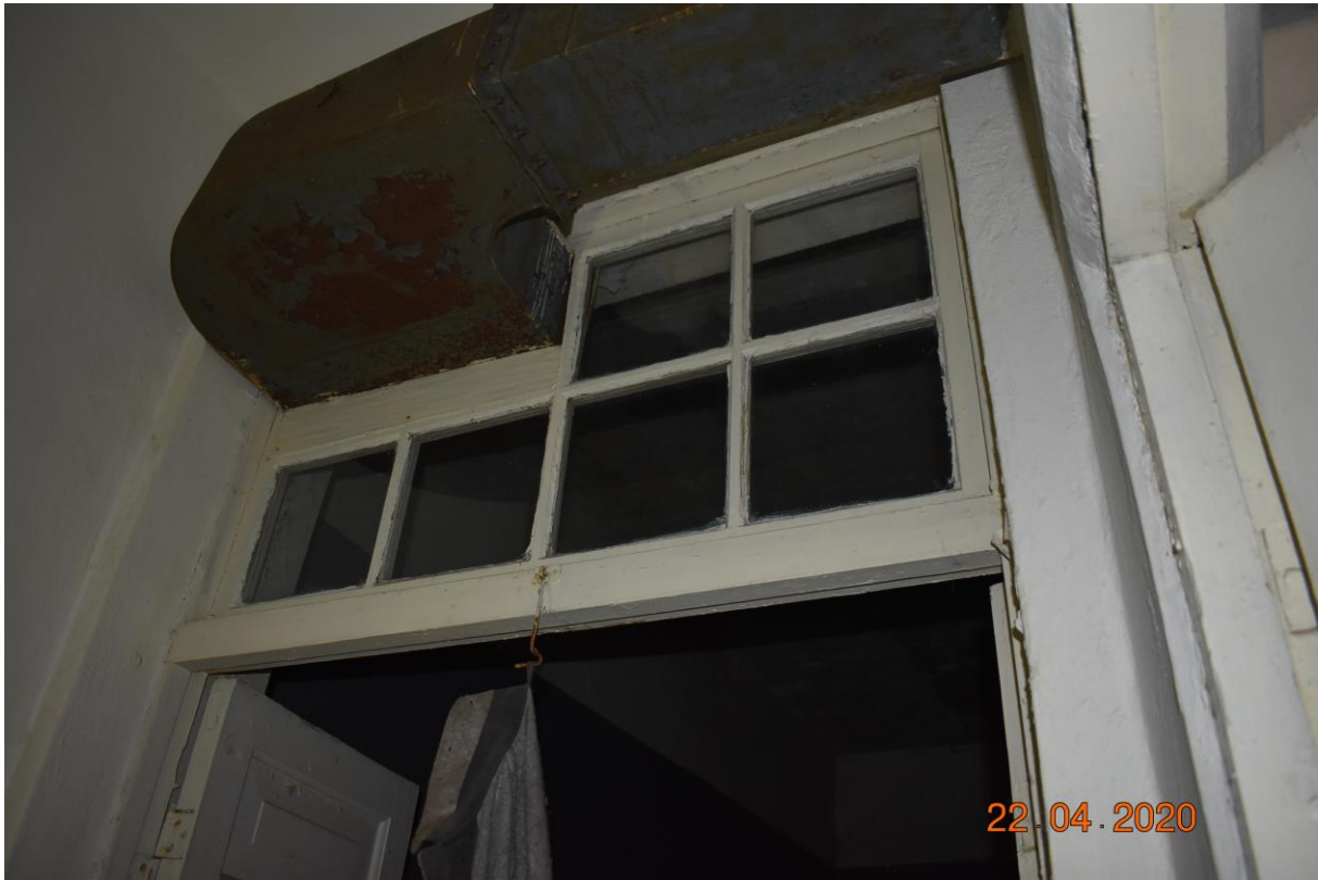
Foto 10. Ukse framuug ventilatsioonitoruga
