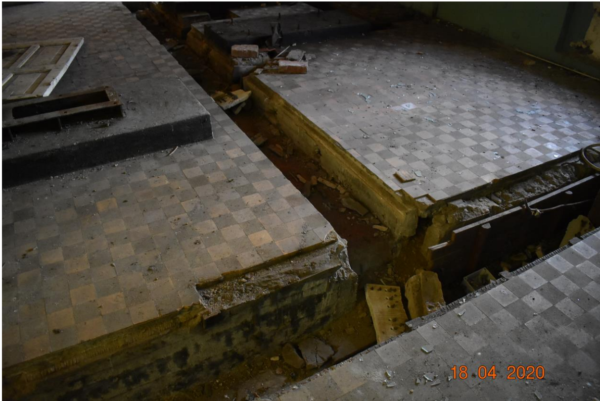
Foto 12. Generaatoriruumi põrand kaablikanalitega
