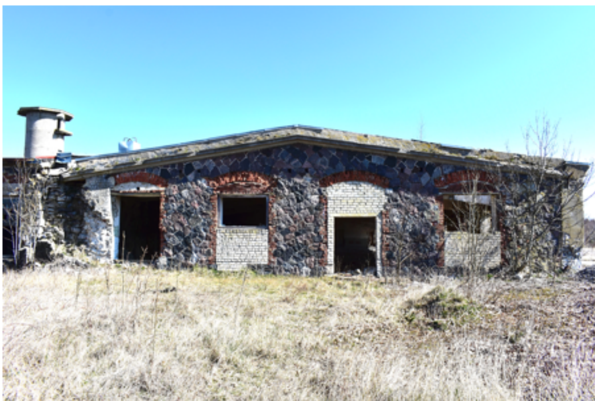
36. Hoone tagakülje otsaseinas on seespoolt tuvastatav originaalne ukseava, kahjuks aga on sein ise üsna lagunenud ja ümberehituste käigus ka suures osas oma originaalse ilme kaotanud. Autori foto
