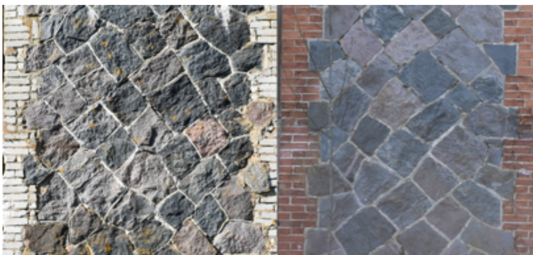
25. Fragmendid välismüüri diagonaalsest kivilaost. (vasakul hoone nr.8 fassaad, paremal hoone nr.9 külg) Autori foto
