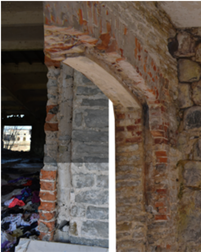
41. Autori kollaaž. 2 ja 3 ruumi vaheseina sisse laotud ukseleengist.
