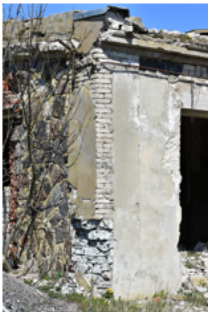
35. Vasakpoolne pilt: hoone taga, otsaseinas veel tuvastatav algselt pækivist kvaadritega olnud nurk. Parempoolne pilt: fragment samast nurgast. Autori foto
