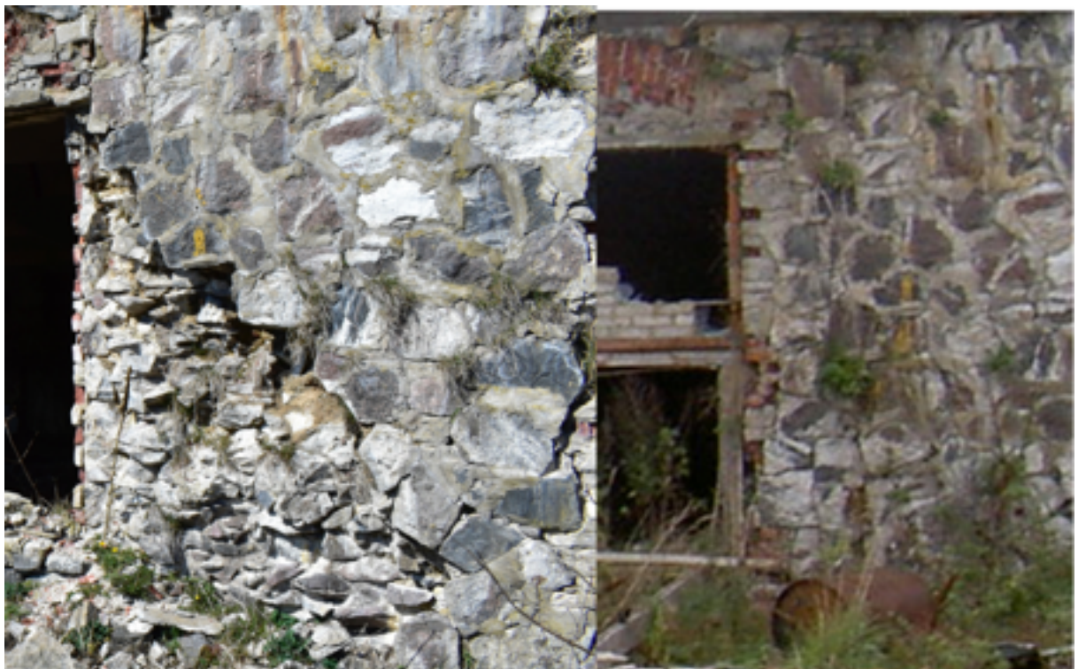
28. Parempoolne foto on tehtud enne liivapritsi kasutamist 2002 aastal, vasakpoolne foto 2020 täpselt samast kohast, hoone nr.8 külgmüürist. Vasakpoolne on Autori foto, parempoolne Urmas Voolma, Dagopen, 2002
