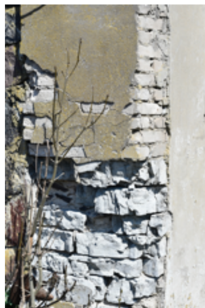
35. Vasakpoolne pilt: hoone taga, otsaseinas veel tuvastatav algselt pækivist kvaadritega olnud nurk. Parempoolne pilt: fragment samast nurgast. Autori foto
