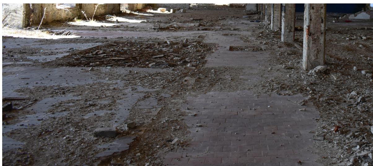
54. Lihakombinaadi ajal olid enamused põrandaid kaetud kahhelplaatidega. Pildil fragment teise ruumi põrandast. Autori foto
