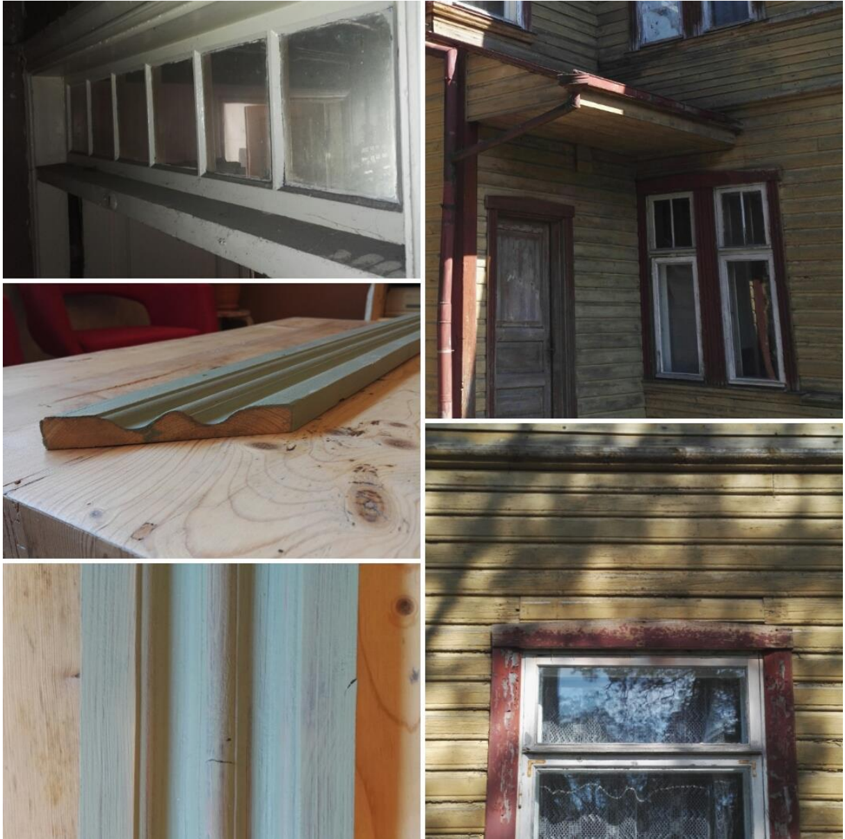
Foto 6. Aknad : valgmiku, originaalsed aknad ukse kõrval, originaalsed liistud, muudetud kõrgusega ja laiusuga aken (parandus fassaadil).
