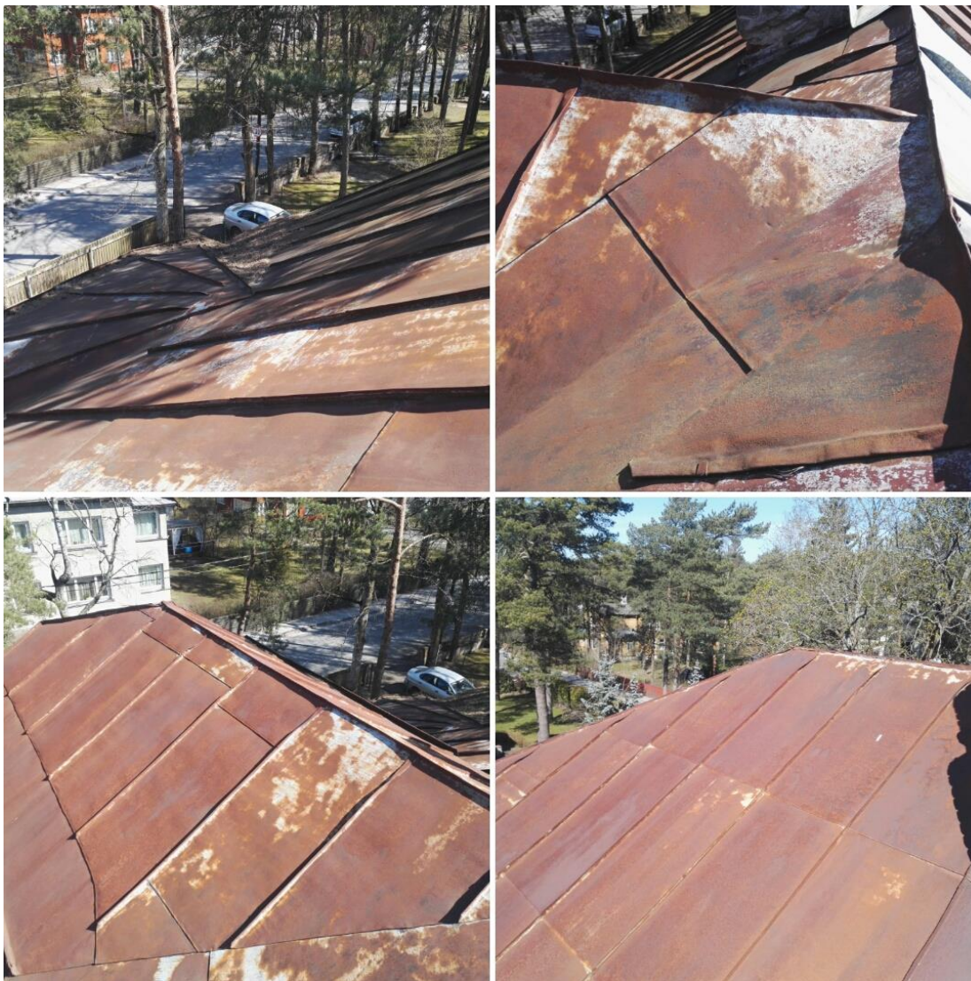
Foto 2. Katuseplekk. Erkeri pealne, neelukoht, katusehari, plekitahvlite ruudustik.
