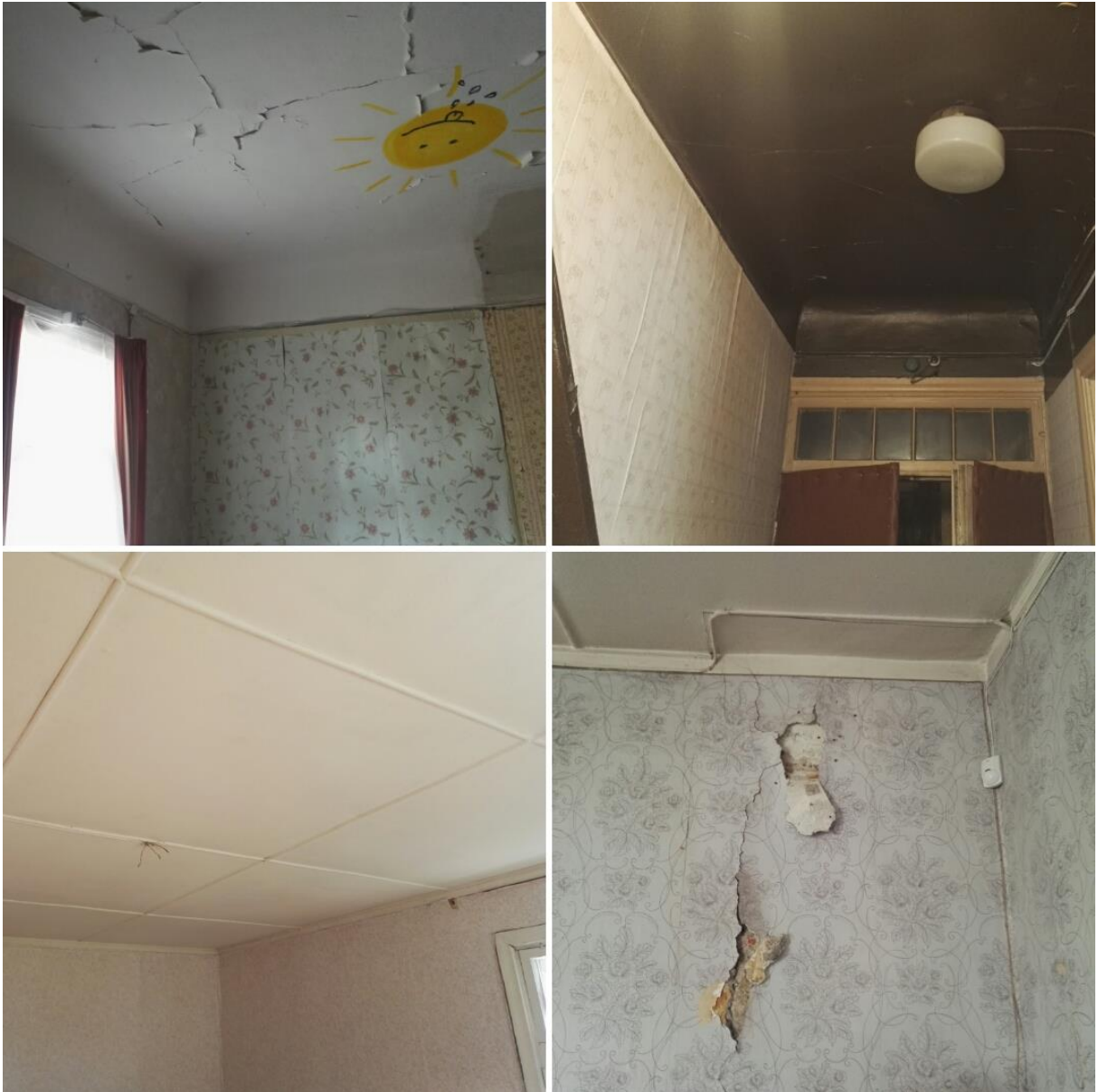
Foto 9. Seinad, laed : toas ja trepikojas säilinud peegelvõlv, plaatmaterjaliga kaetud lagi, tapeedi tagant paljanduv lubikrohv.
