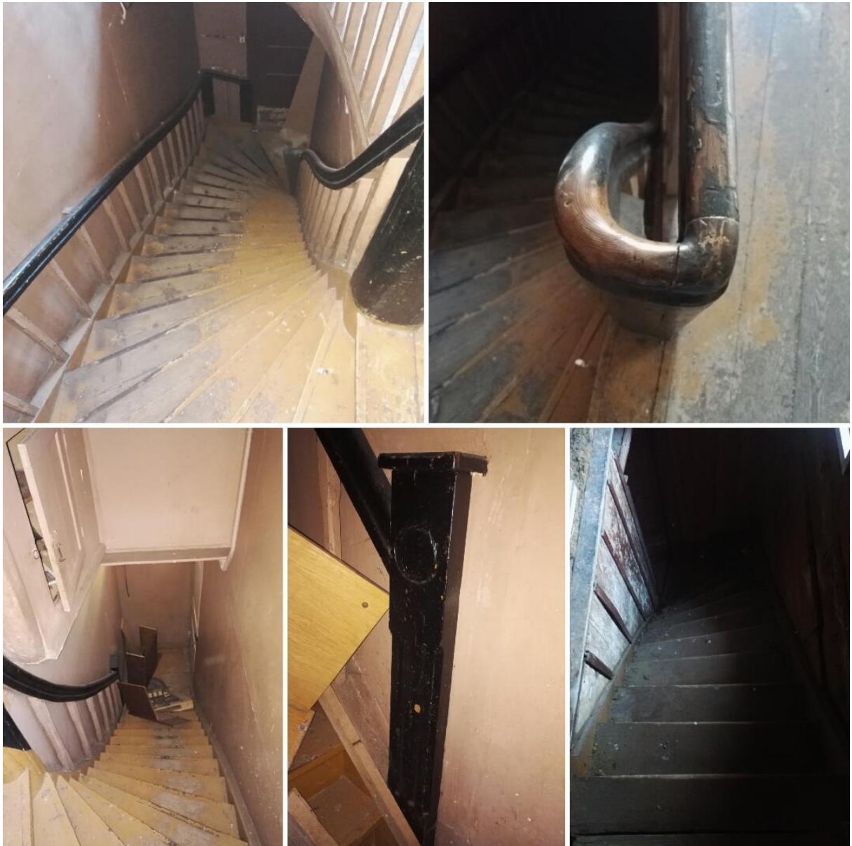
Foto 7. Trepid : peatrepp ja käsipuu, teine trepp ja post, pööningutrepp.
