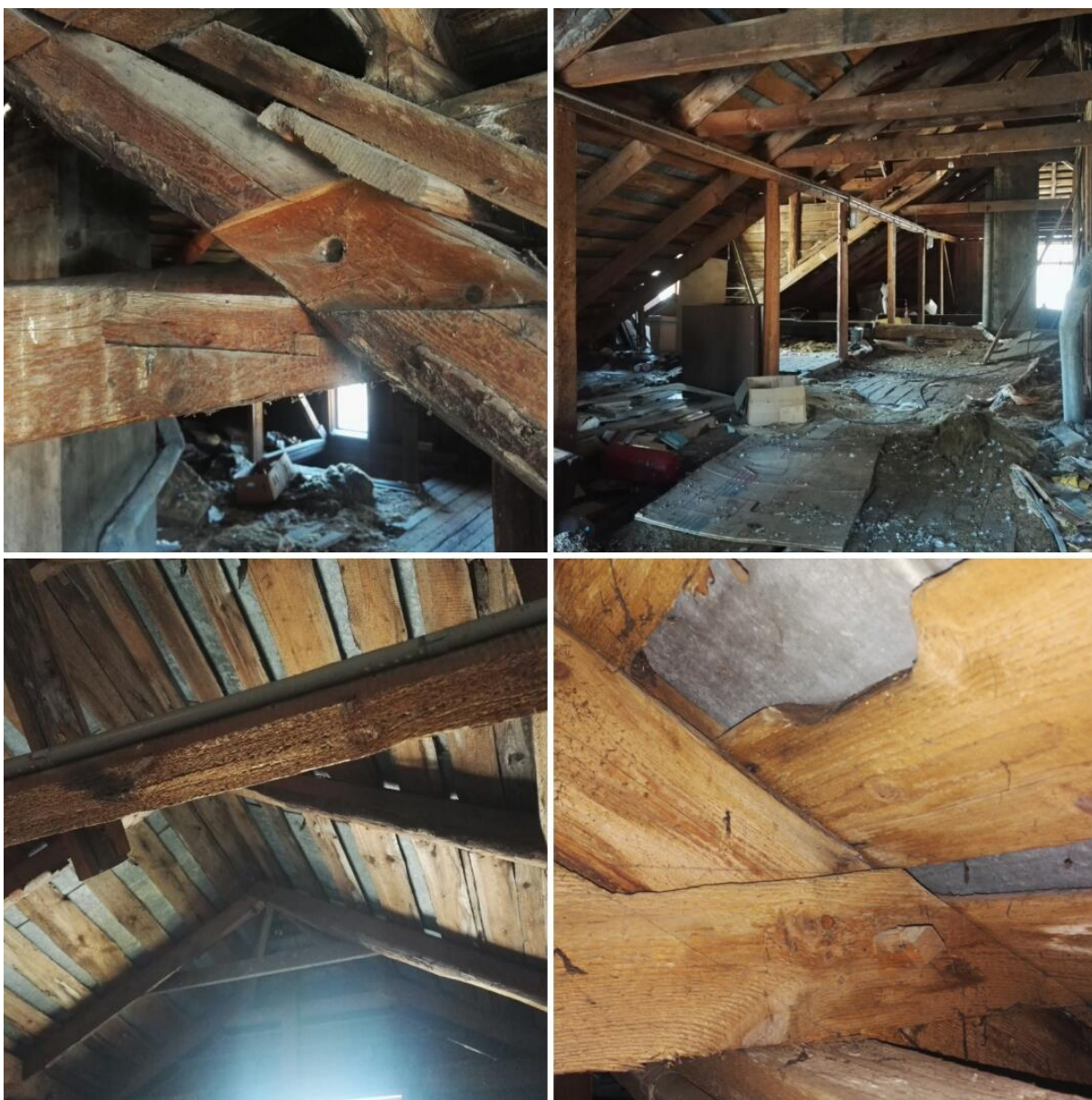
Foto 3. Katusekonstruktsioon. Poolkalasabatapp ja punnühendus penni ja sarika vahel. Nn. Hollandi jätktapp toolvärgil. Servamata lauast pleki alusroovitis. Kahed pennid.
