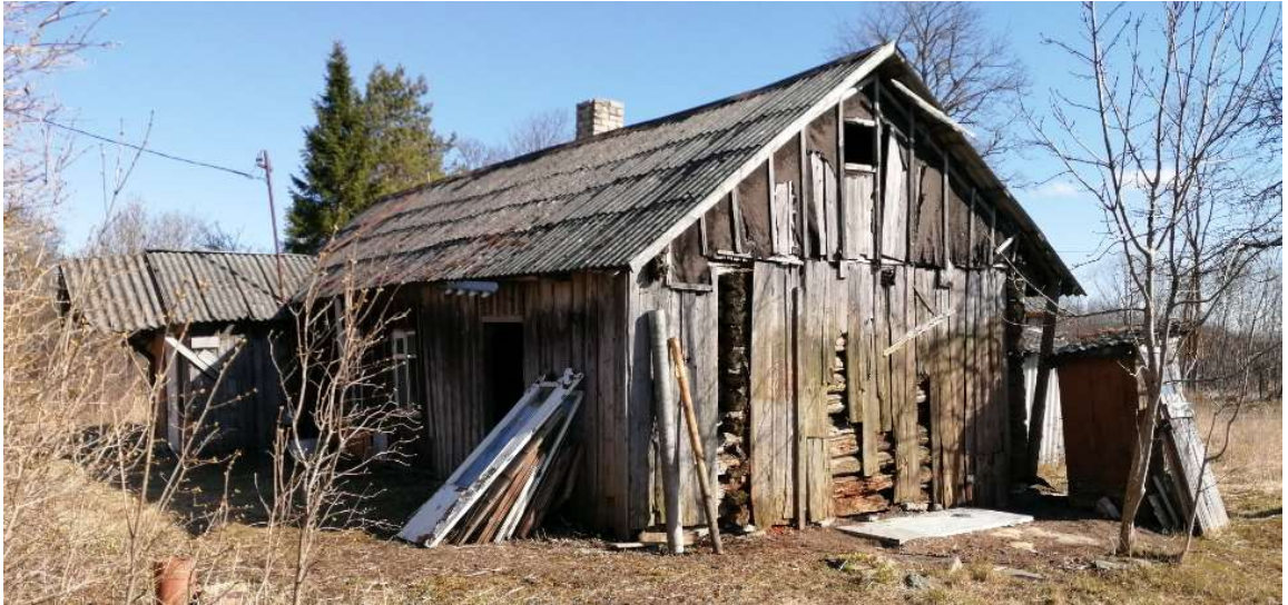
ill 17. Vaade põhjast pärast avariilise varjualuse eemaldamist
