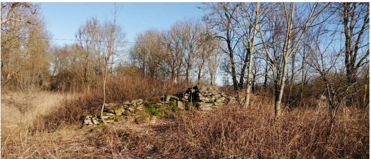
ill 22. Vaade lauda vundamendile
