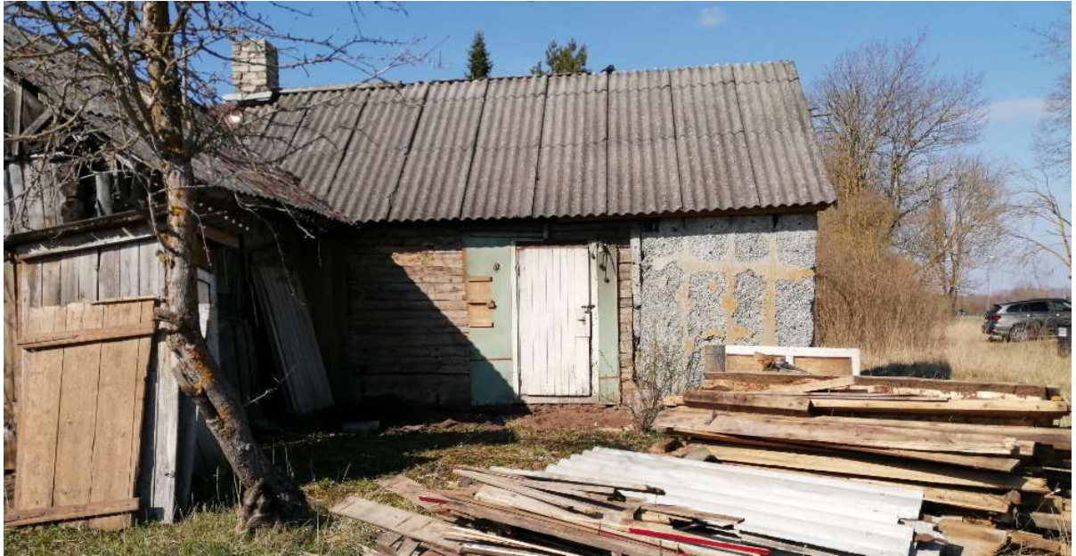
ill 33. Vaade uuema hooneosa freespalkseinale peale kuuri lammutamist
