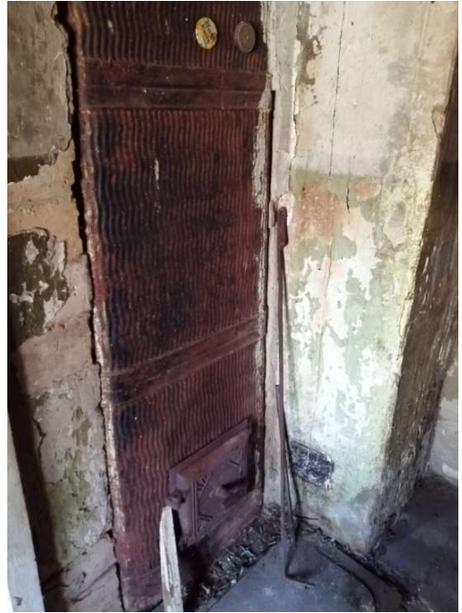
ill 27. Vaade vanema hooneosa küttekahadele
