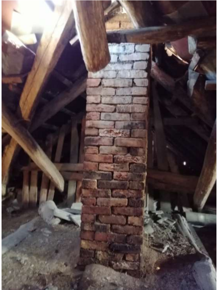
ill 31. Vaade katuse katkisele konstruktsioonile
