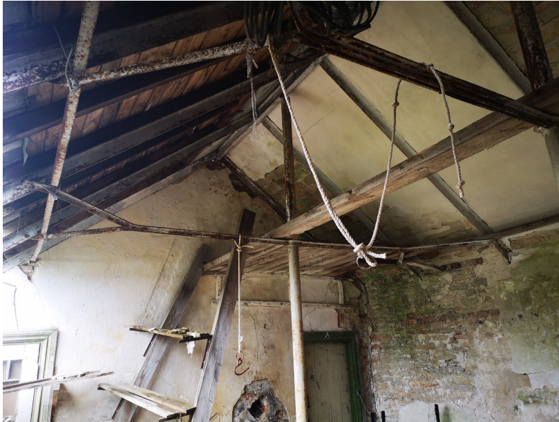
39. säilinud metallist katusekonstruktsioon
