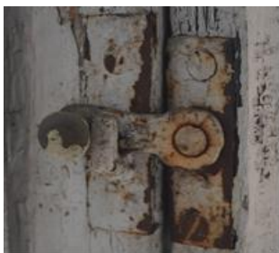
Illustratsioonid 50, 51. Tuulutuse akna sulgurid.
