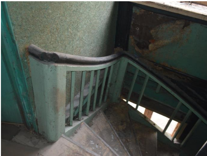
Illustratsioon 55. Esimese trepikoja trepp teisel korrusel.
