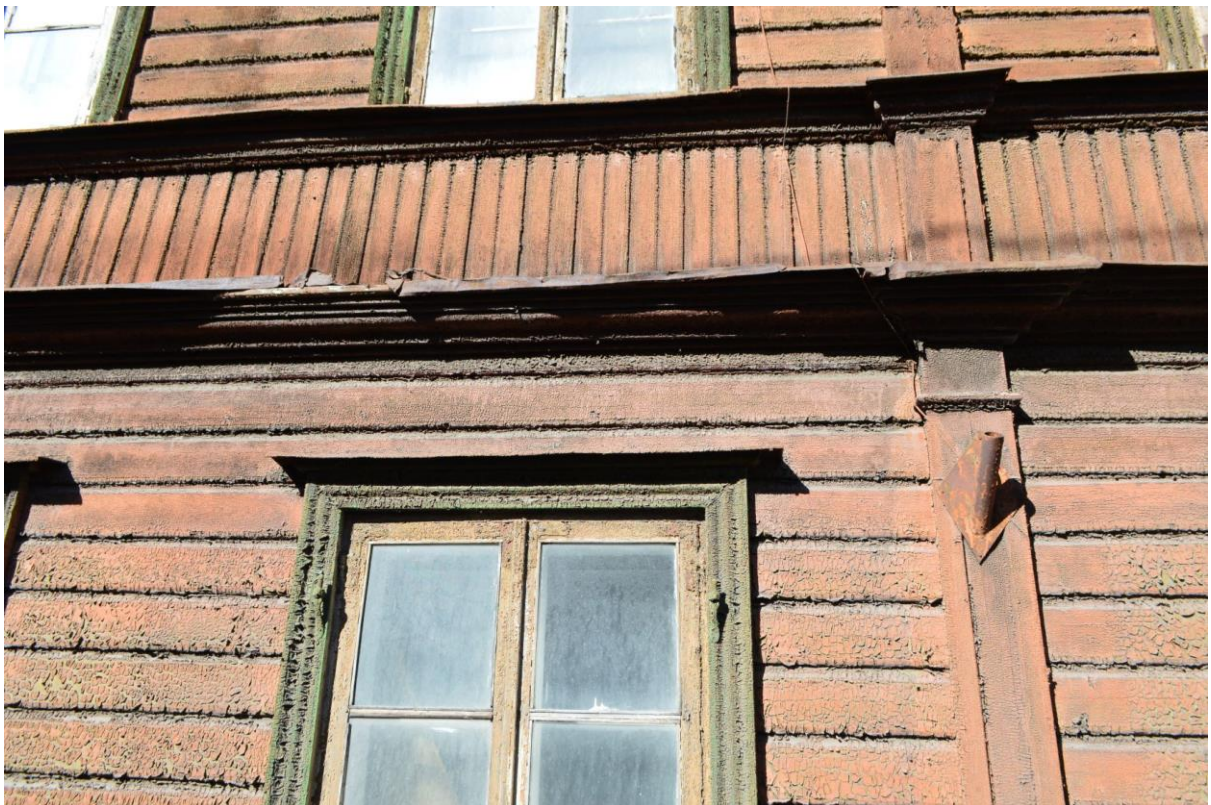
Illustratsioon 64. Fassaadi karniisid ja voodrilauad.
