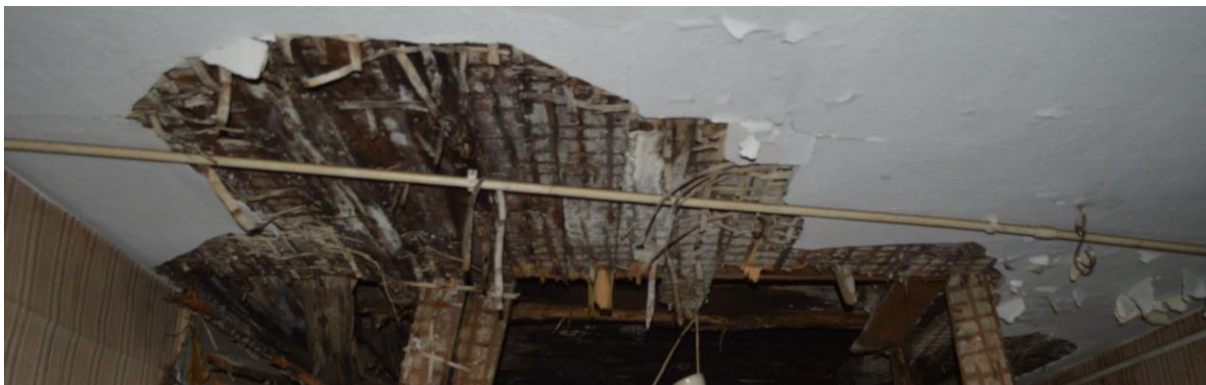
Illustratsioon 38. Lagunenud lagi teise korruse korteri köögis.
