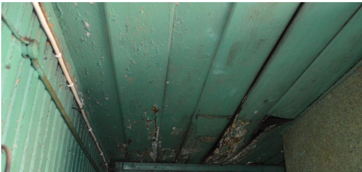
Illustratsioon 41. Vaade teise trepikoja laele teisel korrusel.
