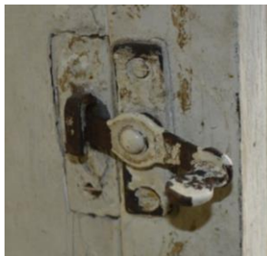
Illustratsioonid 50, 51. Tuulutuse akna sulgurid.
