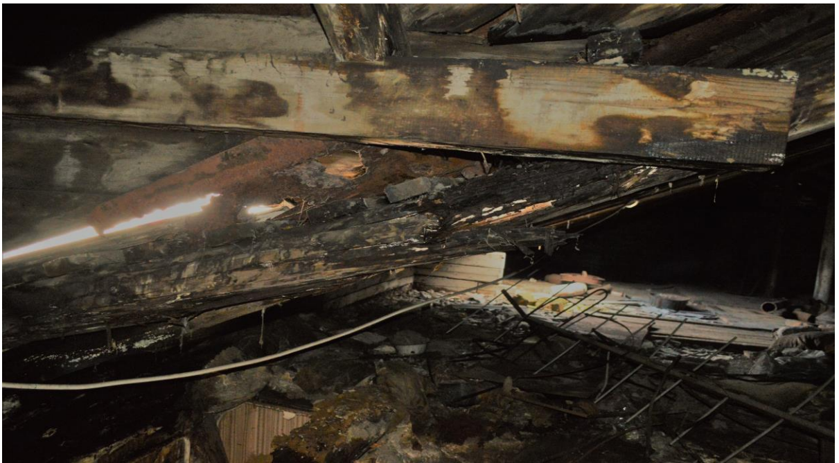
Illustratsioon 7. Katkine ja mädanenud katuse sarikas.
