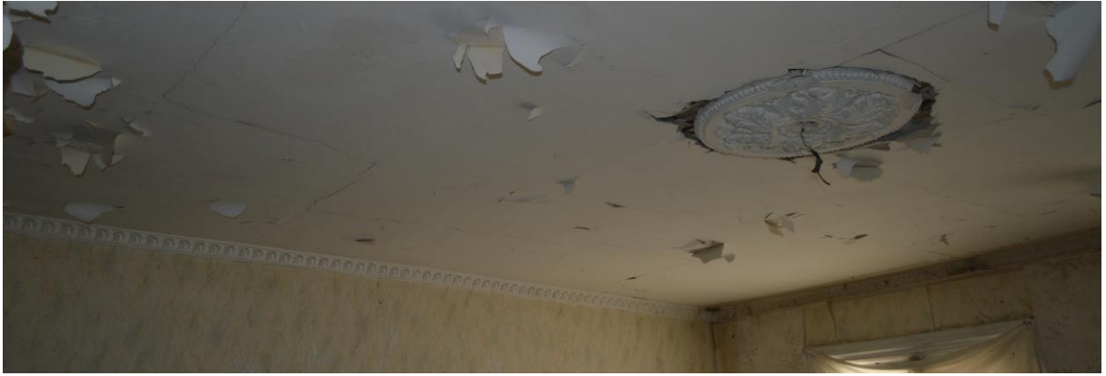
Illustratsioon 44. Algupärane krohvitud lagi koos lae karniisiga- ja rosettiga.
