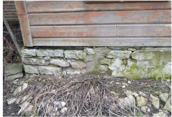
Illustratsioon 15. Tsementmördiga parandatud sokel ja puuduv veelaud.
