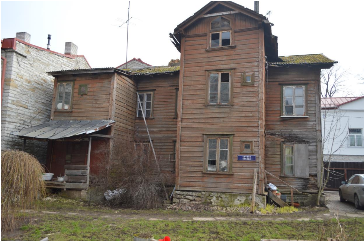
Illustratsioon 4. Vaade fassaadile hoovi poolt.
