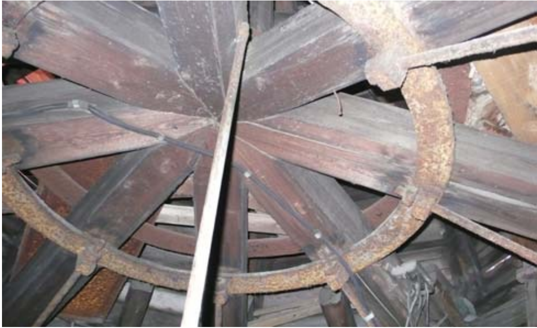
19. Kalasadama 2, endise gaasivabriku katusekonstruktsioon, 2009.
