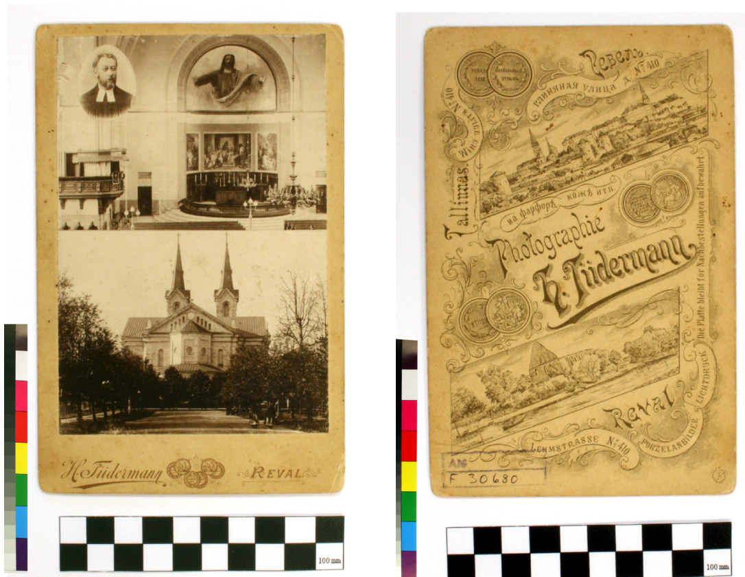
14. Heinrich Tiidermann. Tallinna Kaarli kiriku sise- ja välisvaade, kollaaž. u. 1900 -1904. Läkiv kolloodiumfoto, kabinetiportree formaat ja vormistus, 16,4 x 10,8 x 0,15cm. EAM, F 30680. Saadud Sirje Annistilt 2000.a. Aluspapi tagakülje trükipildil on kolmes keeles andmed fotoateljee asukoha ja täpsema tegevuse kohta, saadud auhinna-medalite kujutised.
