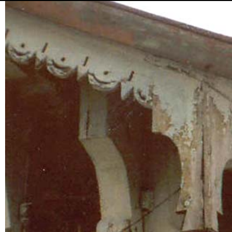
Lääne-Virumaa, Lehtse raudteejaam (avati 1876.a., kivist hoone puitpits)
