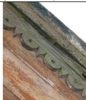
Paide raudteekompleks, Vaksali 2 (kõrvalhoone.)
