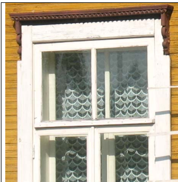
Põlvamaa, Värskas, Kalda 4, I k
