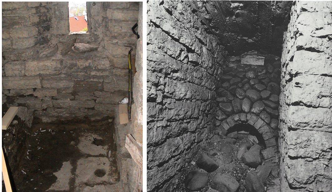
Vasakul Ill. 12: Landskrone torni kerishüpokaustiga köetav meeskonnaruum. Paremal Ill. 13: : Pika Hermanni kerishüpokausti jäänused.
