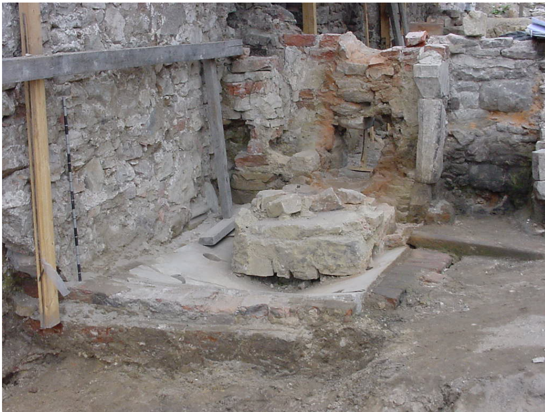
Ill. 31: Foto Haapsalu Osutitorni kaevamistelt. Hüpokausti kütteplaadi peale on ehitatud kahhelahju vundament.
