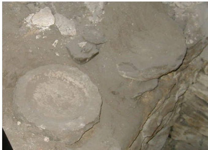
Vasakul Ill. 28: Paest tõmbekausid, leitud Kuninga tn 6 kütteplaadi alt. Paremal Ill. 29: Analoogsed detailid Rüütli 12a hoonest
