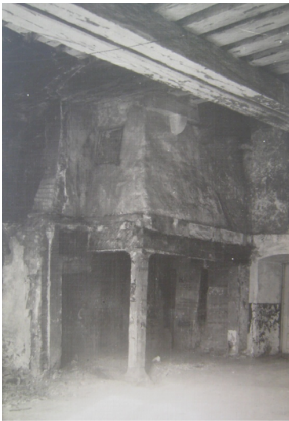
Ill. 10: Mantelkorsten Lai 38 diele nurgas, foto tehtud enne ümberehitust 1930. aastatel.
