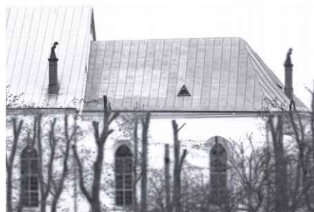
84./85. Mattlakk on negatiivi klaasipoleel, kujutis osaliselt laki alt välja puhastatud. Lakiga kaetud aladel on kujutis udune (vt puid), kiriku katusedetailid aga teravad, EFA f 215
