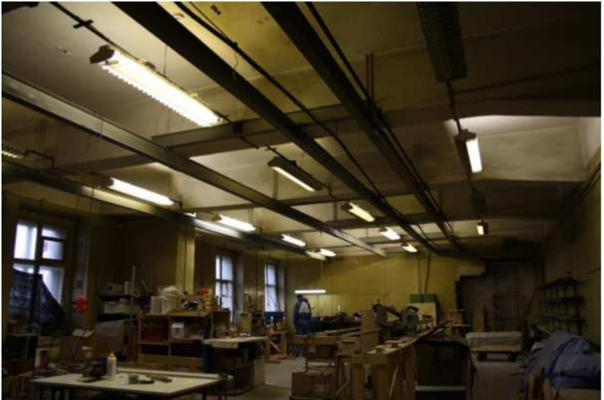
Illustratsioon 49. 1 korruse siseruum. RB vahelagi
