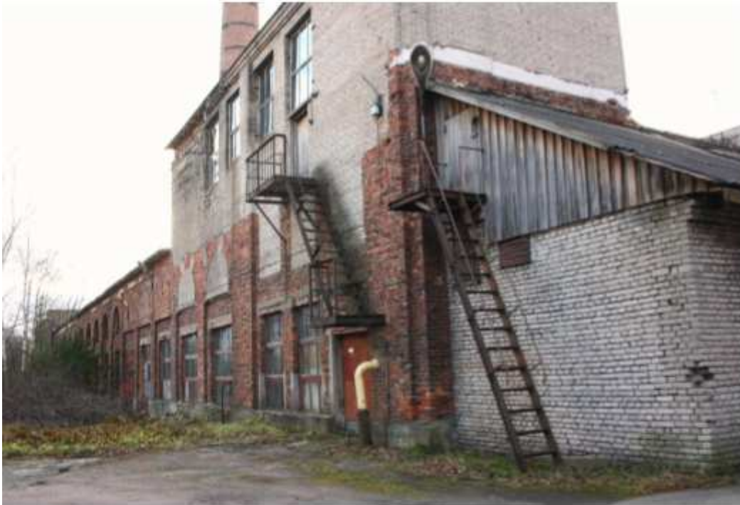
Illustratsioon 67. Läänetiiva Tööstuse tn. poolne fassaad.
