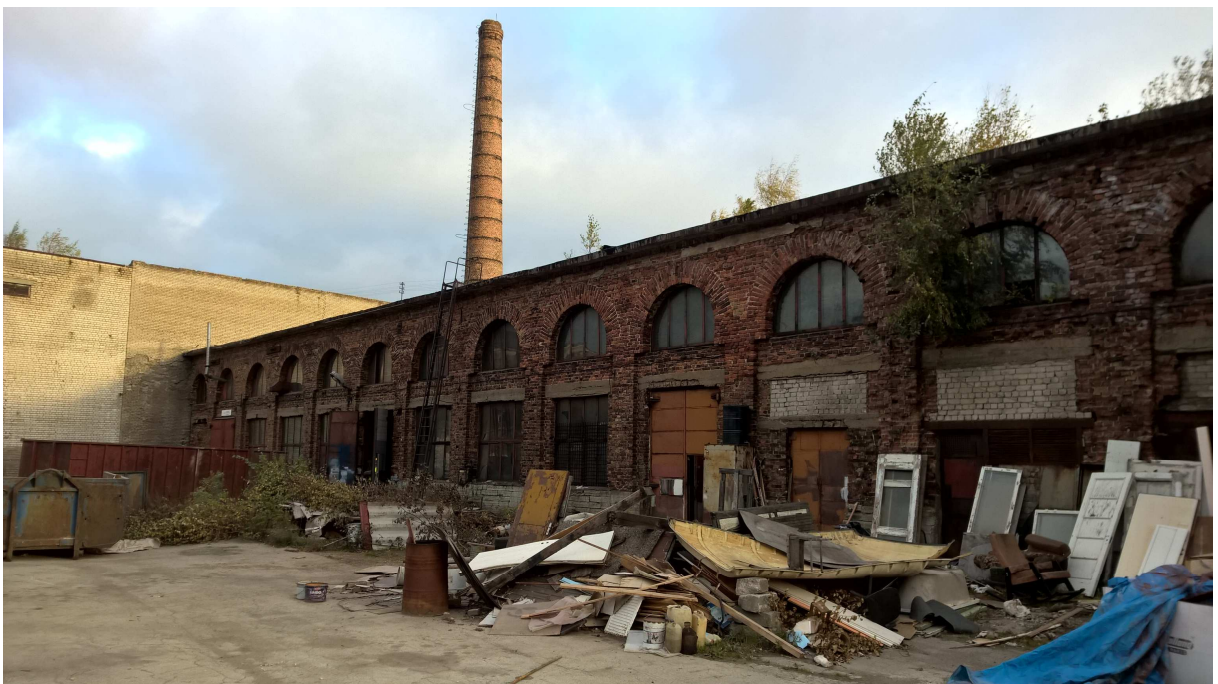
Illustratsioon 62. Läänetiiva hoovipoolne fassaad. Katlamaja ja korsten.
