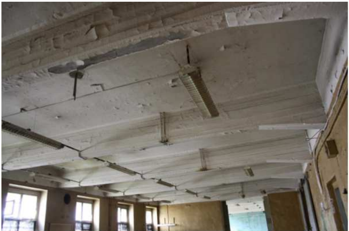
Illustratsioon 50. 1 korruse siseruum. RB vahelagi
