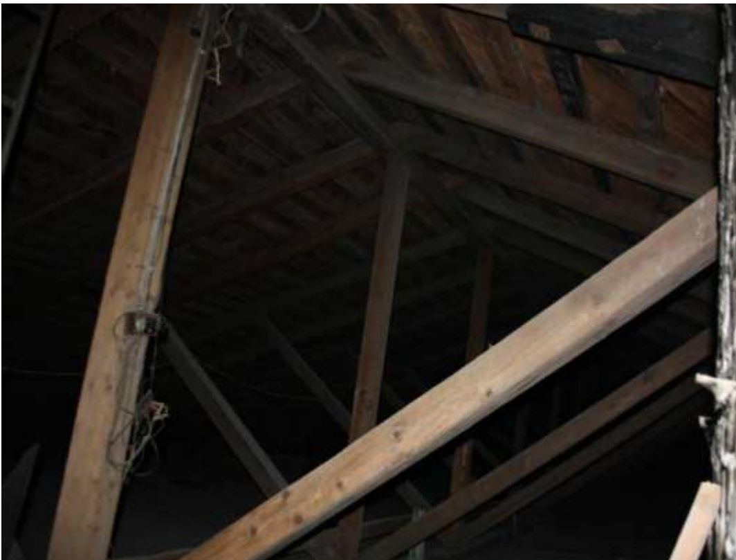
Illustratsioon 61. Katuse kandev konstruktsioon.
