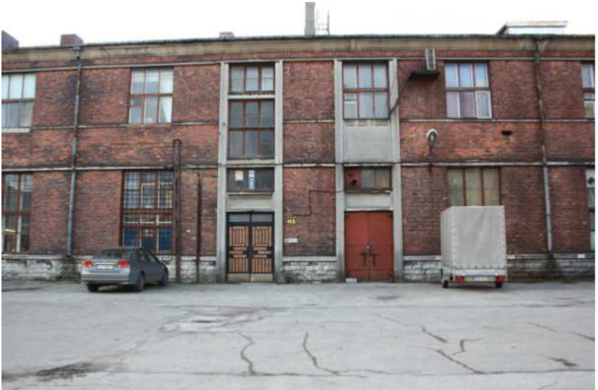
Illustratsioon 56. Vaskplaatide kaetud välisüks põhja fassaadil.
