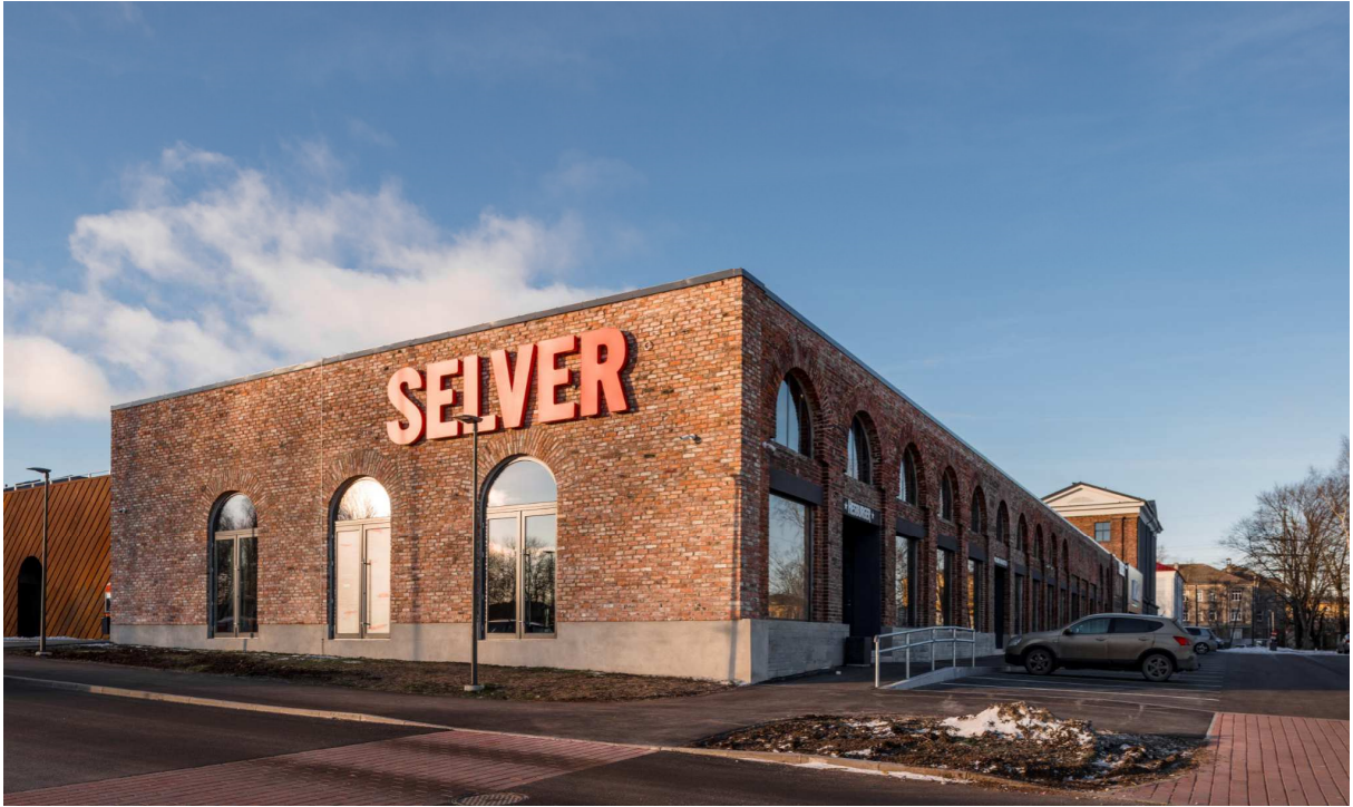
Illustratsioon 76. Otsasein-uus sein vanadest kividest. Tööstuse maja läänetiib.
