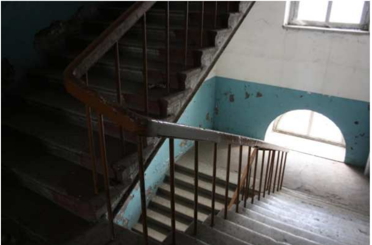
Illustratsioon 51. põhjapoolse risaliidi paekivist trepp ja käsipuu.
