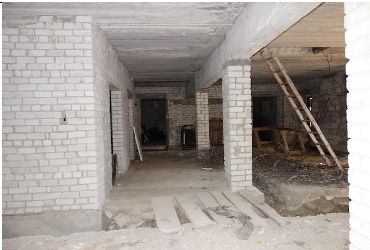
Foto 31, Vaade ümberehitatud talupoegade tallile. Pildi keskel vahelae tugipostid.
