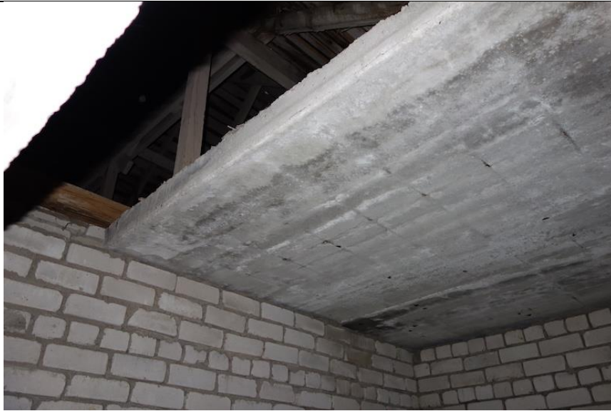
Foto 23, vaade raudbetoonist vahelae plaatidele, mis toetuvad silikaatseinale. Asukoht sakste tallis.
