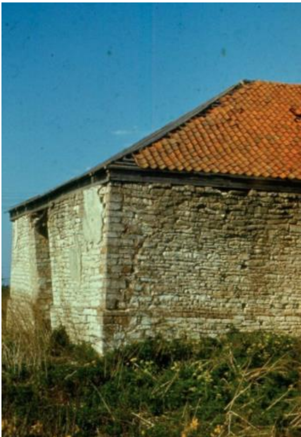
Foto: Talupoegade talli ots aastal 1977, enne suuri restaureerimisi ja ümberehitamist. Näha on paekivi ladu, kõrget, kergelt eenduvat soklit ja müüripealset murispuud millele sarikad toetusid. Foto: Foto: A. Joonsaar, 1977, Muinsuskaitseamet; https://register.muinas.ee/
