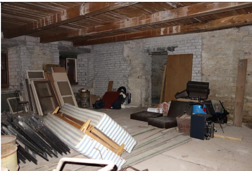
Foto 34. Vaade kõrtsitoale. Vasakul maantepoolsed avad A6 ja A5. Paremäl on näha algupärast paemüüri.
