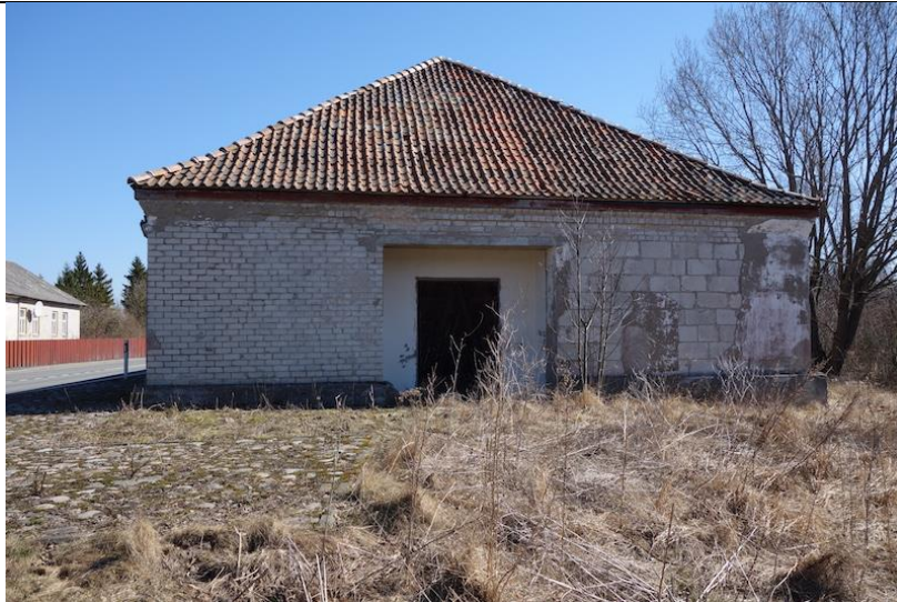
Foto 7. Vaade läänepoolsele fassaadile, talupoegade talli sissepääsule. Näha on silikaadist ja tuhablokkidest välisseinad, katusealune karniis, põletatud kividest kelpkatus.
