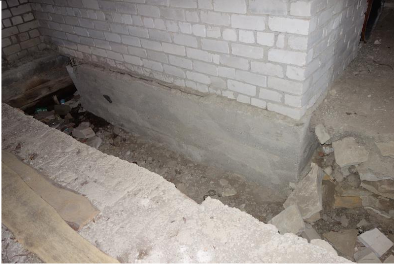
Foto 32. Vaade talupoegade talli kanalisatsioonitrassile. On näha, et pinnas on täidetud endiste müüri ja vaheseinte kividega. ..
