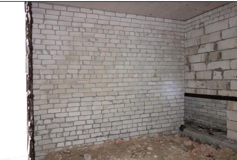
Foto 33, Vaade talupoegade talli ümberehitusele. Pinnas on täidetud algsete vaheseintega...
