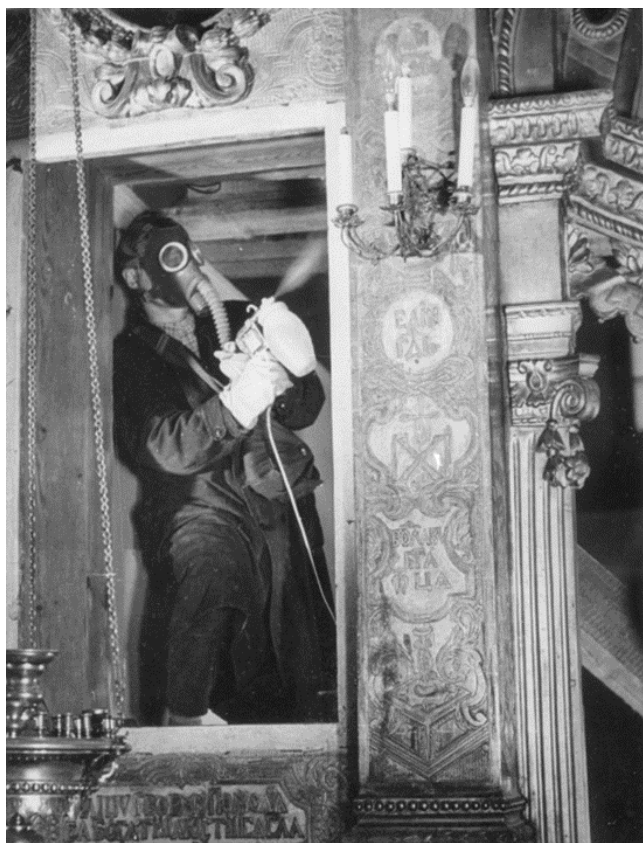
8. Restauraator Arnold Kärbo tõrjub puidukahjureid. I. Zarudnõi loodud ikonostaasilt Issanda Muutmise Peakirikus Tallinnas, 1967.
