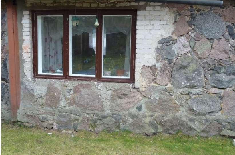
Foto nr. 17.1. Vaade põhjast elamuks ehitamise käigus sisse lammutatud aknaavast. Vaade ruum 7 aknale.
