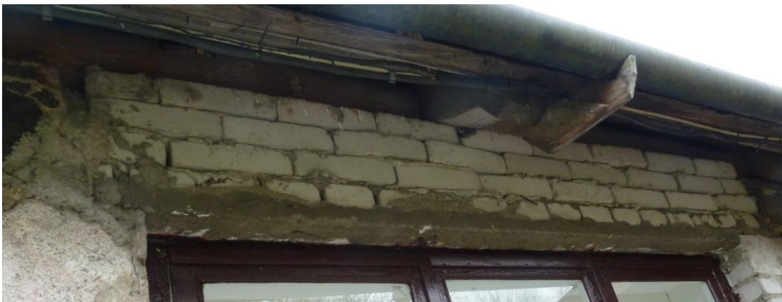
Foto nr. 18. Vaade ruumi nr. 4 tellistest laotud aknasillusele
