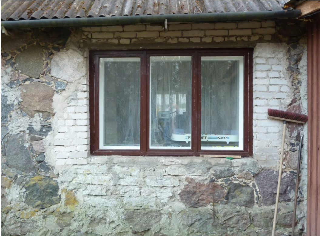
Foto 17.2 Vaade hoone kirdenurgast elamuks ehitamise käigus sisse lõhutud aknaavale
