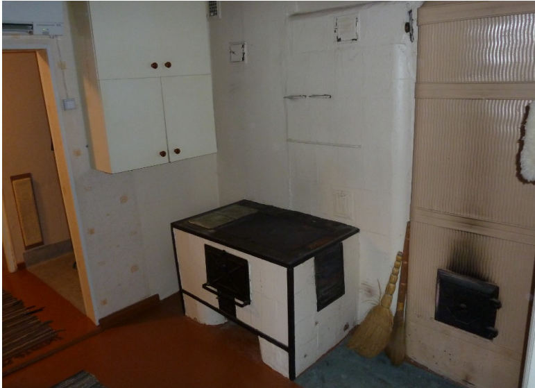
Foto nr. 12. Plekkkestaga ahi ja puupliit vanas köögis ehk ruumis 7
