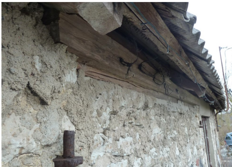
Foto nr. 18.3. Vana rehevärava puittalast sillus, hoone lõunaküljel.
