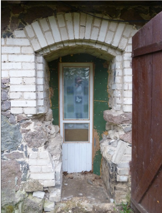
Foto nr. 18.6. Vaade ruumi nr. 9 põhjapoolsele ukseavale, mis tundub algselt olevat kaheks eraldi avaks jaotatud olema.
