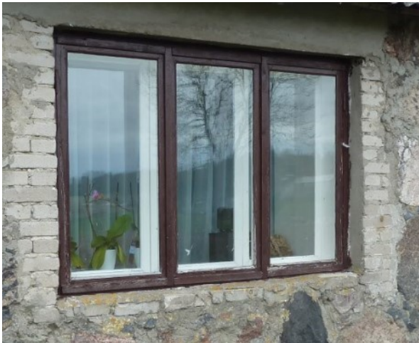
Foto nr. 23. Vaade lõunast ruumi nr.5 aknale. Akna jaotus ei sobi hoone proportsioonidega
