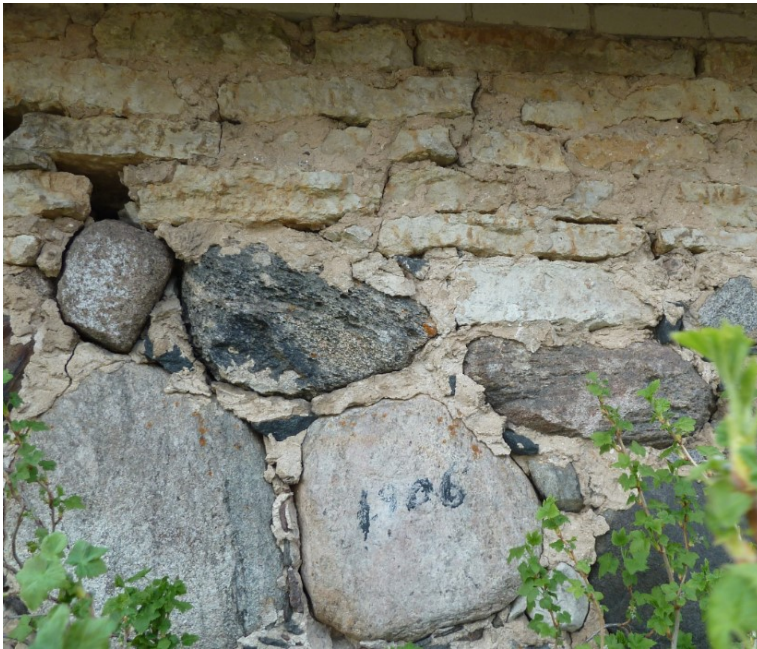
Foto nr. 1. Lammutamisele määratud hoone ehitusaasta 1906
