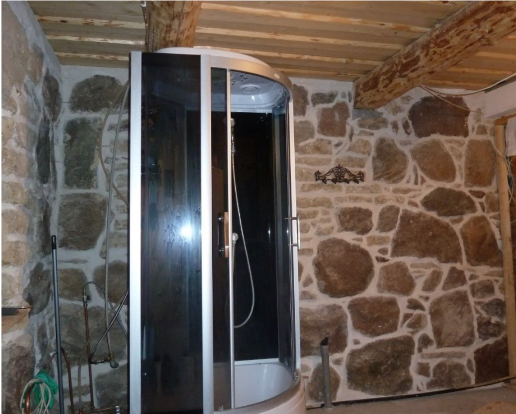
Foto nr. 21.2. Vaade ruumise nr. 8 läänepoolsele välisseinale
