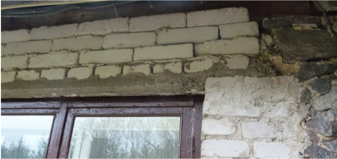
Foto nr. 18.1. Vaade ruumi nr. 7 silikaattelistest laotud akna sillusele
