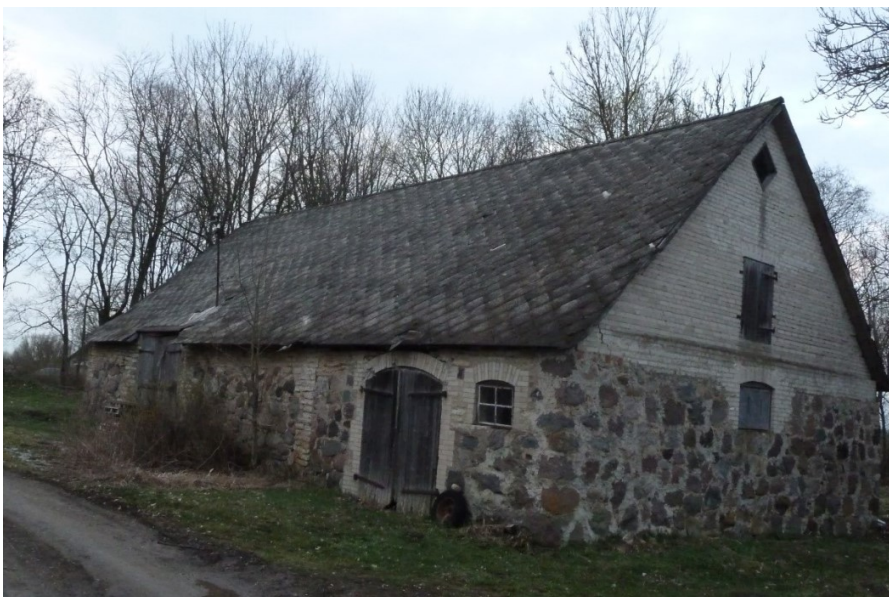
Foto nr. 2. Vaade lammutamisele määratud küünile kagust.
