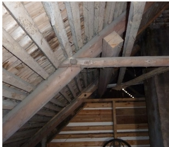
Foto nr. 6 Ebaõnnestunud vekseldamine
