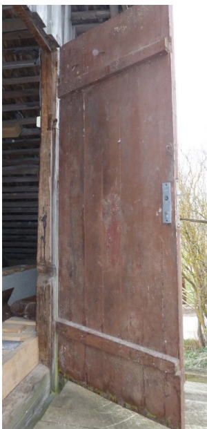
Foto nr. 24. Pööningu uks. Uks asub hoone lääneküljel.
