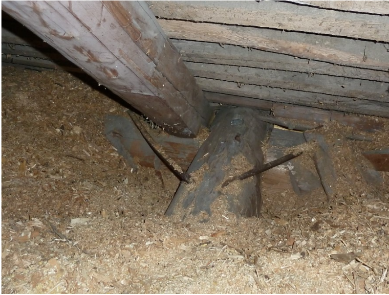
Foto nr. 9. Riiskade ja suure sepanaelaga räästapärilinite vahelise sidetala kinnitussõlm
