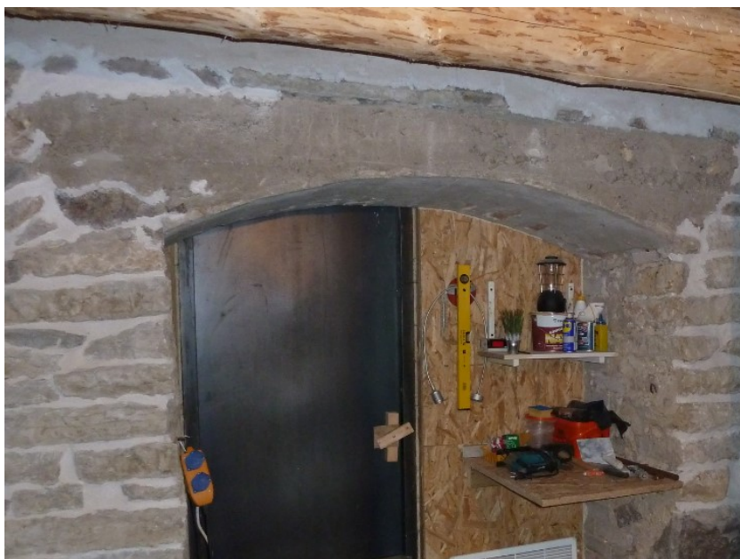
Foto nr. 18.4. Ruumi nr. 8 (raud)betoonist kaarekujuline ukseava sillus.
