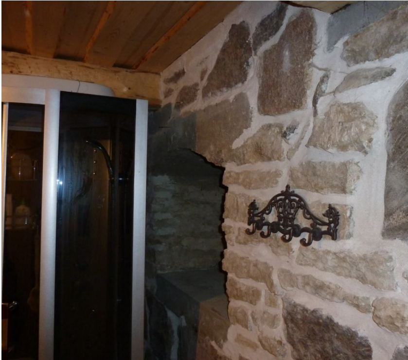
Foto nr. 18.5. Ruumi nr. 8 loodesuunas kaarjas raudbetoonsillus. Ava oli ca 15mm terasvarrastega trellitatud.
