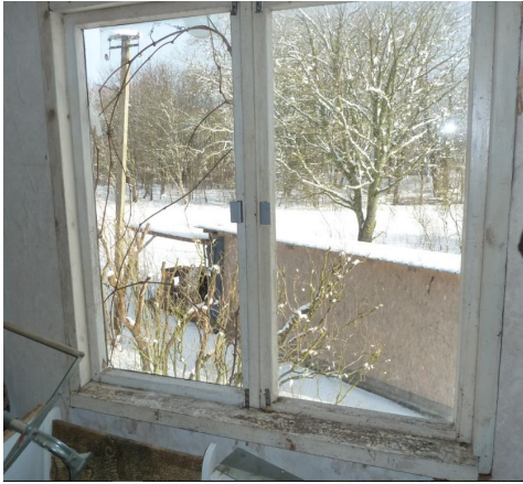
Foto nr. 23.2. Pööningu aken. Akna leng 1 kordse raami jaoks. Akna puitosa heas korras. Raam istub lengi täpselt.
