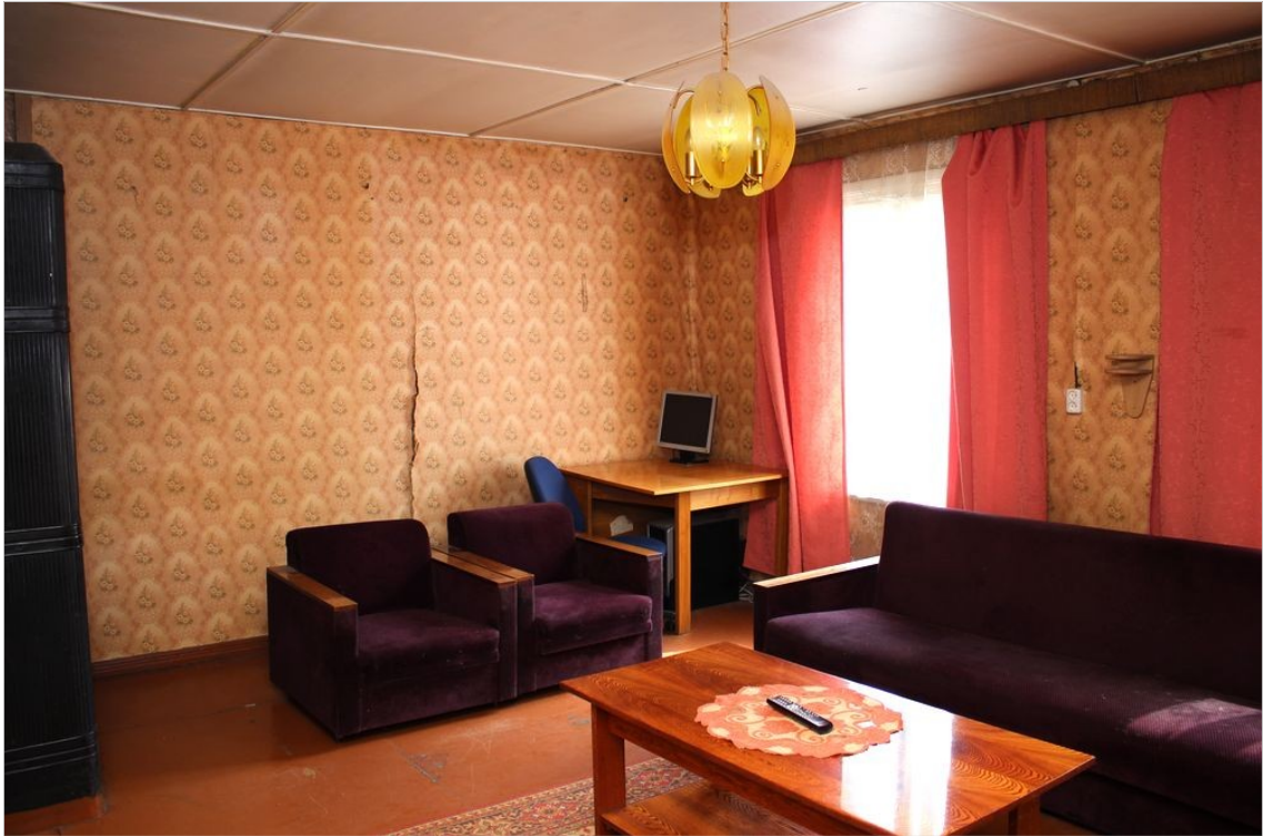
29. Tuba maja lääneosas. Vaade eeskoja suunas. Seinal on tapeedis näha pragu – tapeet varjas toa ja eeskoja vahel olevat ust.
