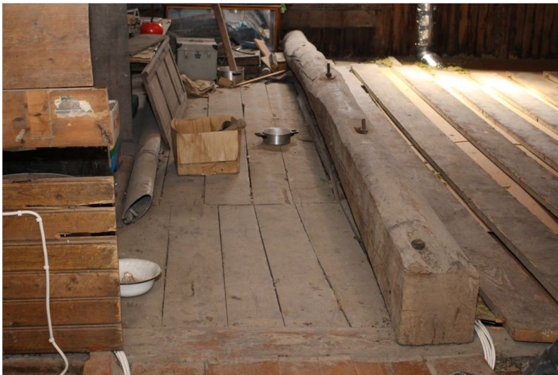
13. Pööningu põrand ja ripptala.
