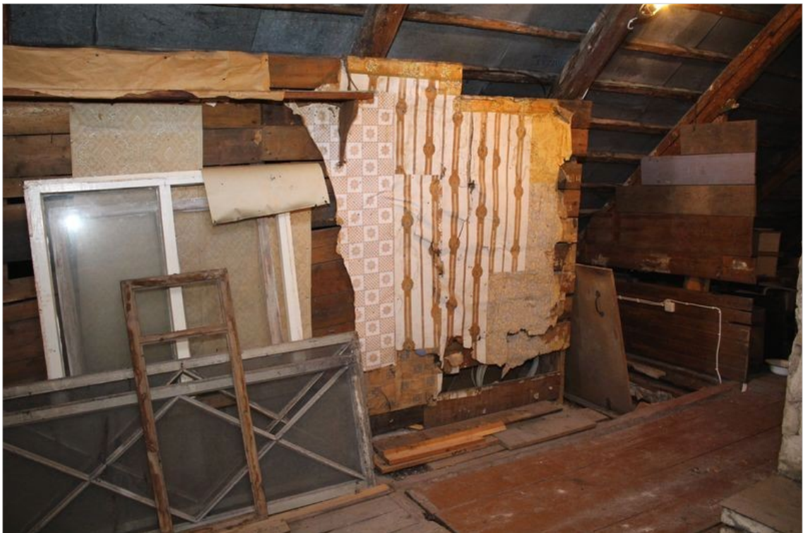
15. Laudadest sein pööningul. Paremäl pööninguluuk, vasakul vanad aknad.
