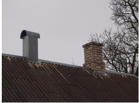
Illustratsioon 53. Rehielamu korstnad
