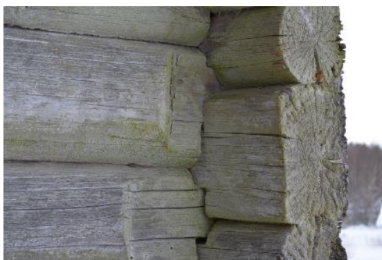
Illustratsioon 16. Nurgakonstruktsioon - järsknurk
