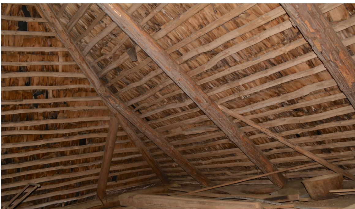
Illustratsioon 49. Kambri laepealse katuse kandekonstruktsioonid
