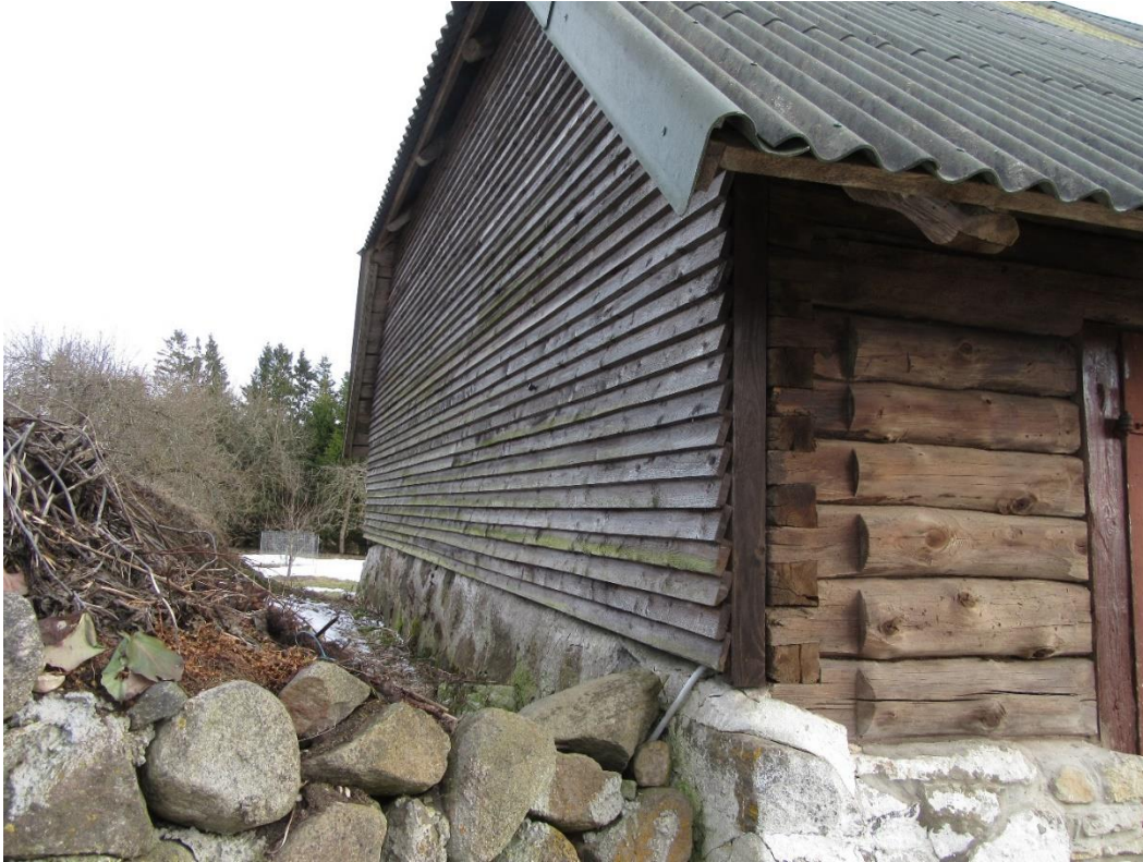
Pilt 10, Rehielamu vaade põhjast
