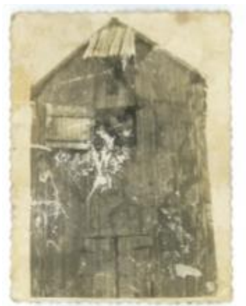
Pilt 45; Vaade tuulikust enne lammutamist
