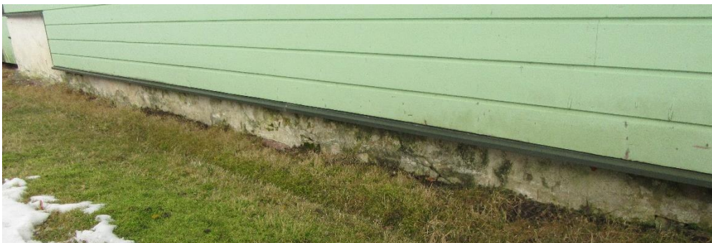
Pilt 3, Sokkel vaade põhjast
