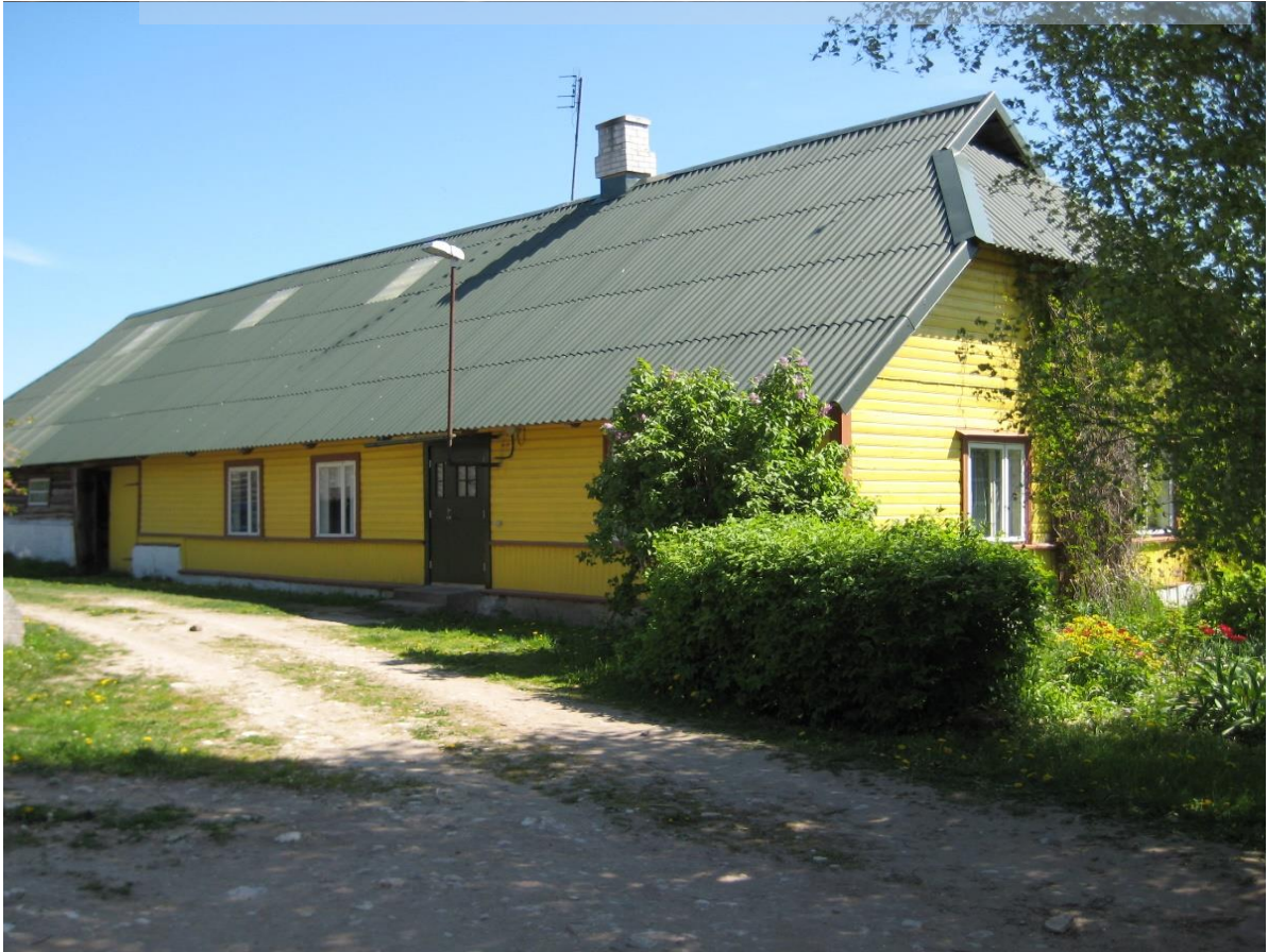
Pilt 8, Rehielamu vaade enne fassaadi remonti
