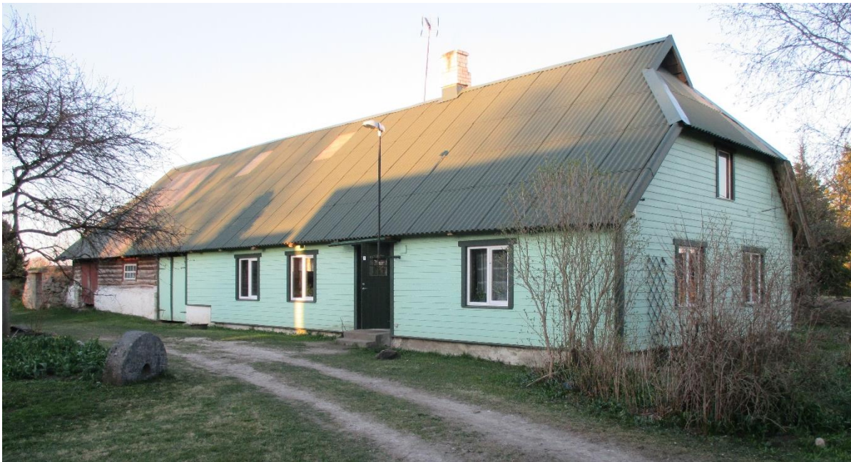
Pilt 9, Rehielamu vaade peale fassaadi remonti
