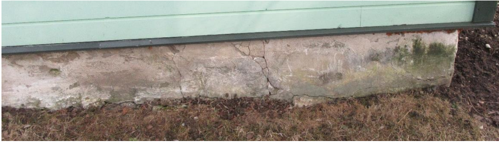
Pilt 4, Sokkel vaade põhjast
