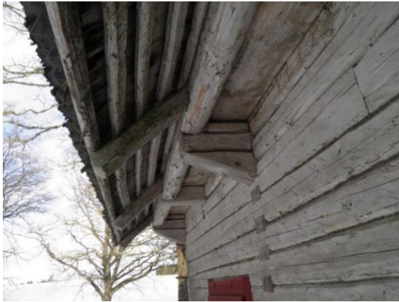
Pilt 26. Aida räästas oli laiem-varikatus laadimiseks
