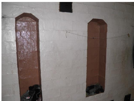
Pilt 10. Ahjukappidega pliidi soemüür, ehitatud 1930. a
