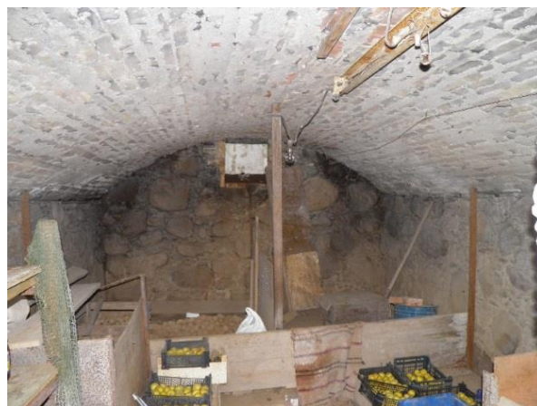
Pilt 35. Keldri sisevaade
