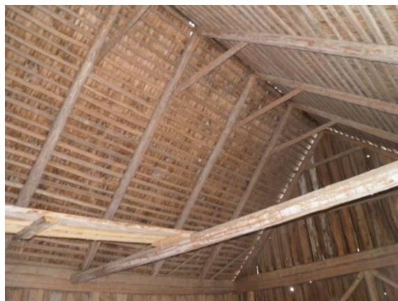
Pilt 19. Küüni katusekonstruktsioon
