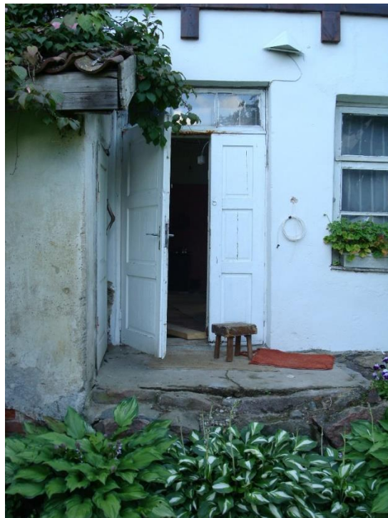
Illustratsioon 13. Vaade vanale trepile ja köögiuksele. Käimla katusel näha vanad mõisast pärinevad kivid. Foto: autor 2007
