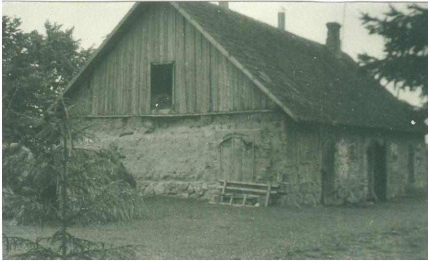
Illustratsioon 9. Kõrvalhoone veel algse laastukatusesga. Juba on näha erosioonijäljed otsaseinal. Allikas: perearhiiv, aastaarv teadmata.
