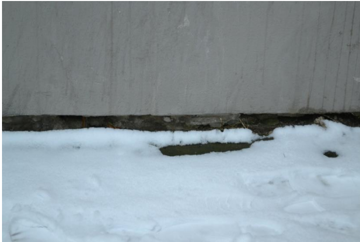
Krohvipinna all näha paevundament.
