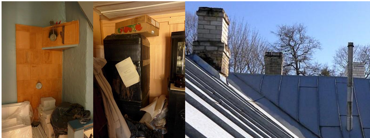
22. Pottahi II korrusel. Autori foto. 23. Profileeritud terasplekist 24. Korstnapitsid. Autori foto. ümbrisega tellisahi I korrusel. Autori foto.
